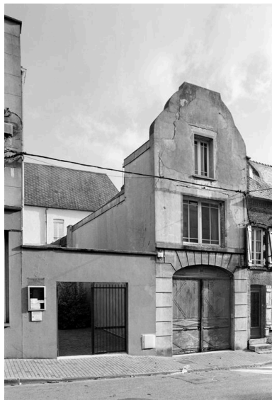
Vue du porche d'entrée, avec son pignon en façade de style néo-flamand. Phot. Pierre-Yves Brest IVR22_19990207139Z
