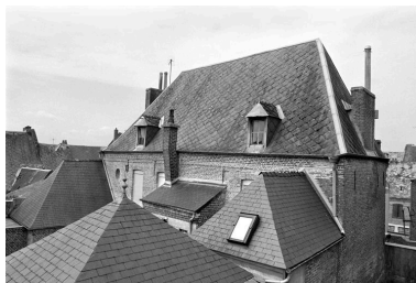
Vue de l'élévation postérieure, depuis une maison située place de l'église. Phot. Pierre-Yves Brest IVR22_19990202873Z
