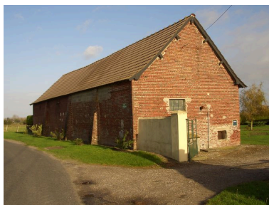
Vue de la grange sur rue.
