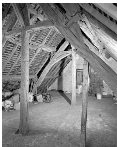
Vue de la charpente. Phot. Thierry Lefébure IVR22_19950203236V
