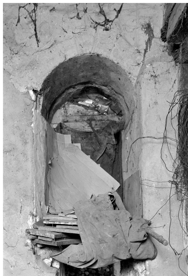
Baie du rez-de-chaussée : vue de l'intérieur. Phot. Thierry Lefébure IVR22_19950203309X
