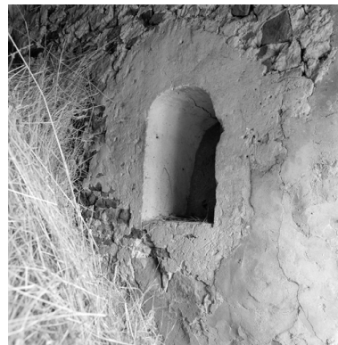
Baie condamnée dans le mur nord du rez-de-chaussée. Phot. Thierry Lefébure IVR22_19950203282X
