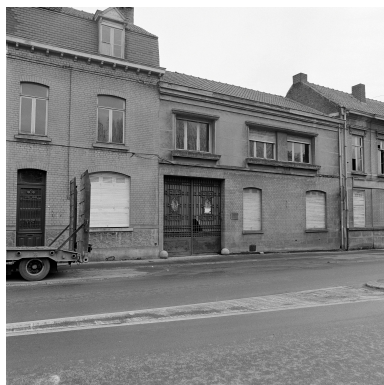
Élévation rue de la Liberté. Phot. Olivier Marlard IVR31_19895900435X
