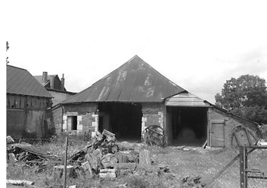
Vue de l'ancienne ferme, logis et grange attenante, transformée aujourd'hui en grange. Phot. Xavier-Philippe Guiochon IVR22_19980201473Z
