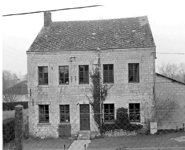
Vue générale. Phot. Laurent Jumel IVR22_19970202192X
