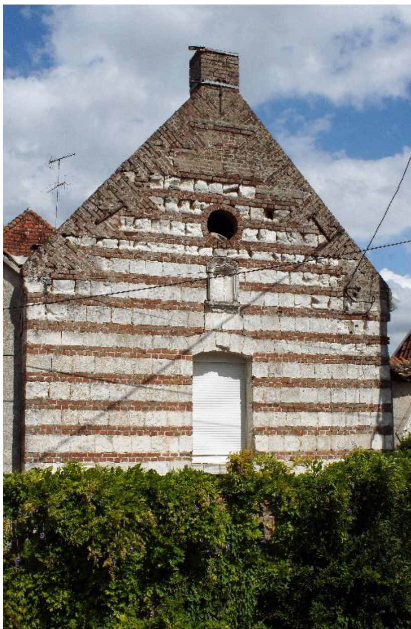
Vue du pignon à assises alternées brique et pierre.
