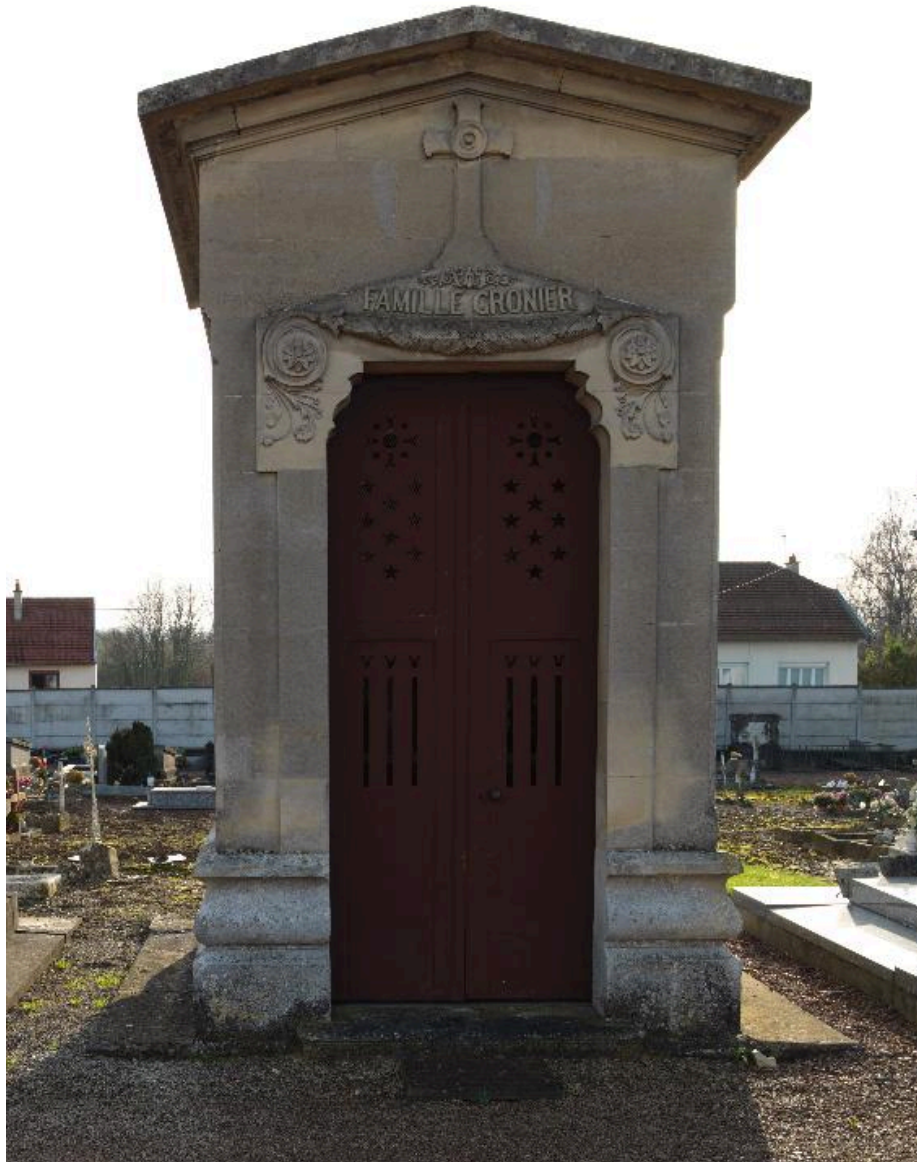
Vue de la façade antérieure.
