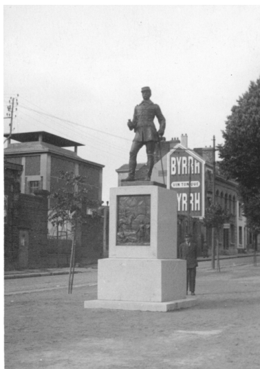
A gauche, la brasserie reconstruite (tourail en béton et brique), photographiée durant l'entre-deux-guerres (BM Saint-Quentin). Phot. Pillet Frédéric IVR22_20050205764NUCAB
