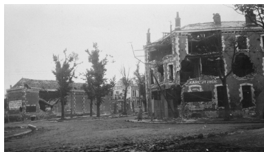
A gauche, la brasserie Duprez, en ruine, vers 1918-1919 (AC Saint-Quentin). Phot. Pillet Frédéric IVR22_20050205938NUCAB
