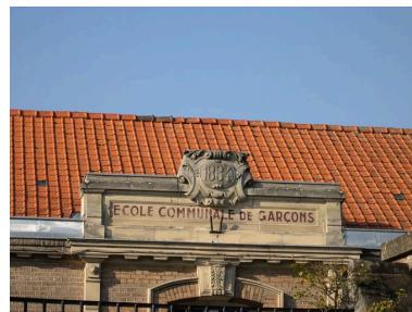
Vue de détail sur le fronton. Phot. Isabelle Barbedor IVR22_20048010568NUCA
