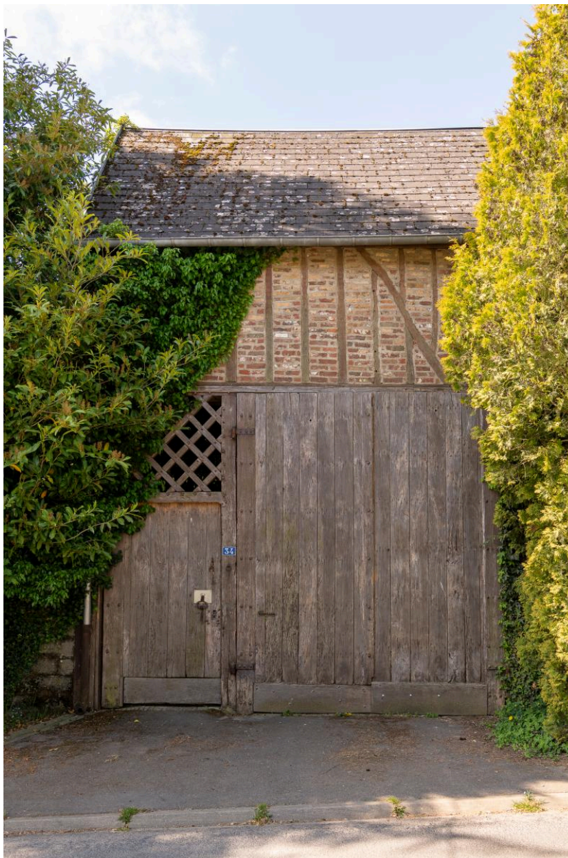
Détail de l'entrée charretière avec porte pitéonne et imposte ajourée, n°34 Grande Rue, vue depuis le nord-est.
