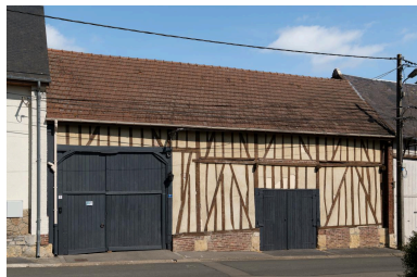
Ancienne grange sur rue avec entrée charretière, n°7 rue Prién, vue depuis le sud-est. Phot. Marc Kérignard IVR32_20226000309NUCA
