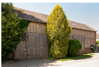
Ancienne grange et entrée charretière sur rue, n°34 Grande Rue, vue depuis le nord-est. Phot. Marc Kérignard IVR32_20226000317NUCA
