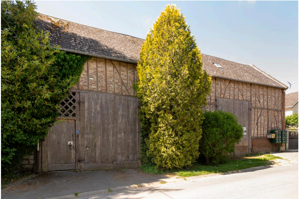
Ancienne grange et entrée charretière sur rue, n°34 Grande Rue, vue depuis le nord-est.
