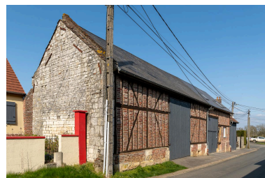
Ancienne grange sur rue avec entrée charretière, n°11 rue de la Mairie, vue depuis le sud-ouest. Phot. Marc Kérignard IVR32_20226000217NUCA
