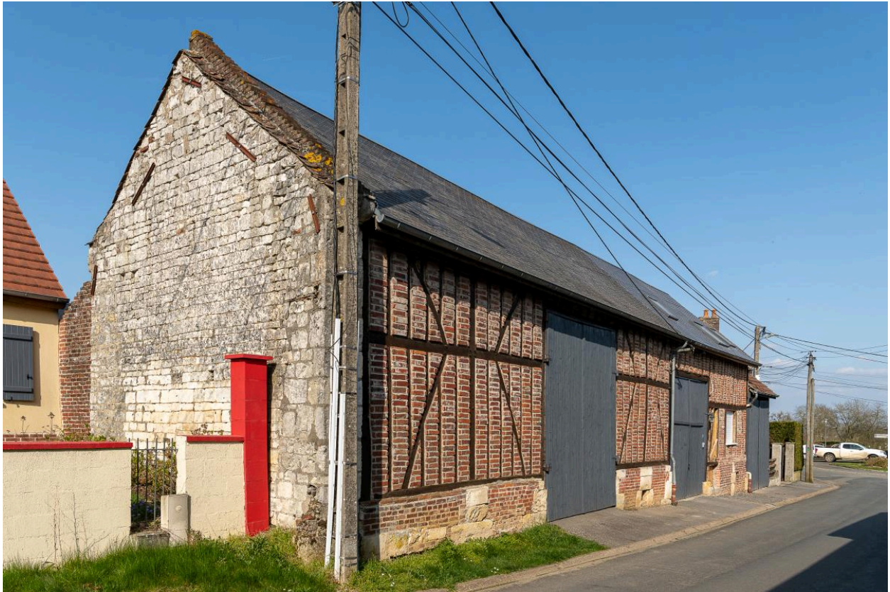
Ancienne grange sur rue avec entrée charretière, n°11 rue de la Mairie, vue depuis le sud-ouest.
