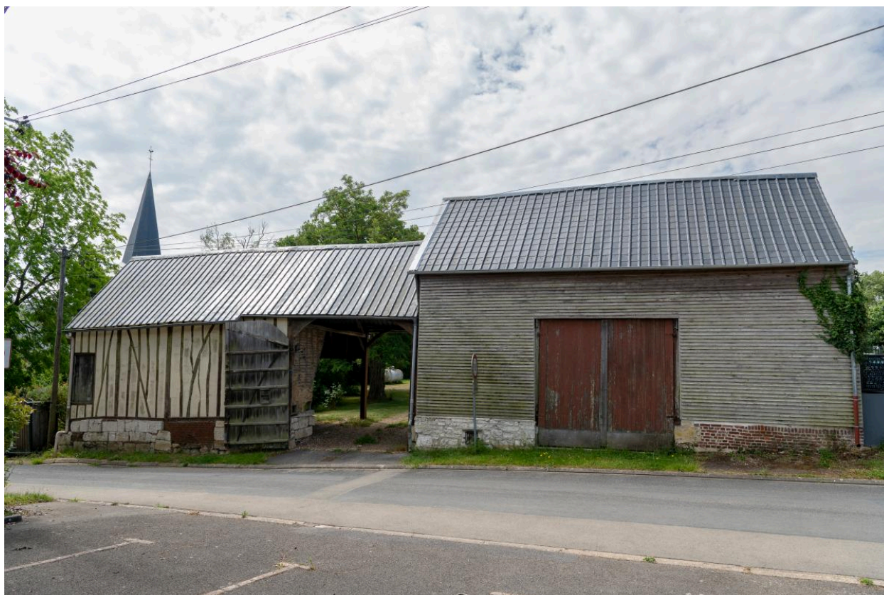
Deux anciennes granges avec entrées charretières, n°2 rue de l'Église, vue depuis le nord.
