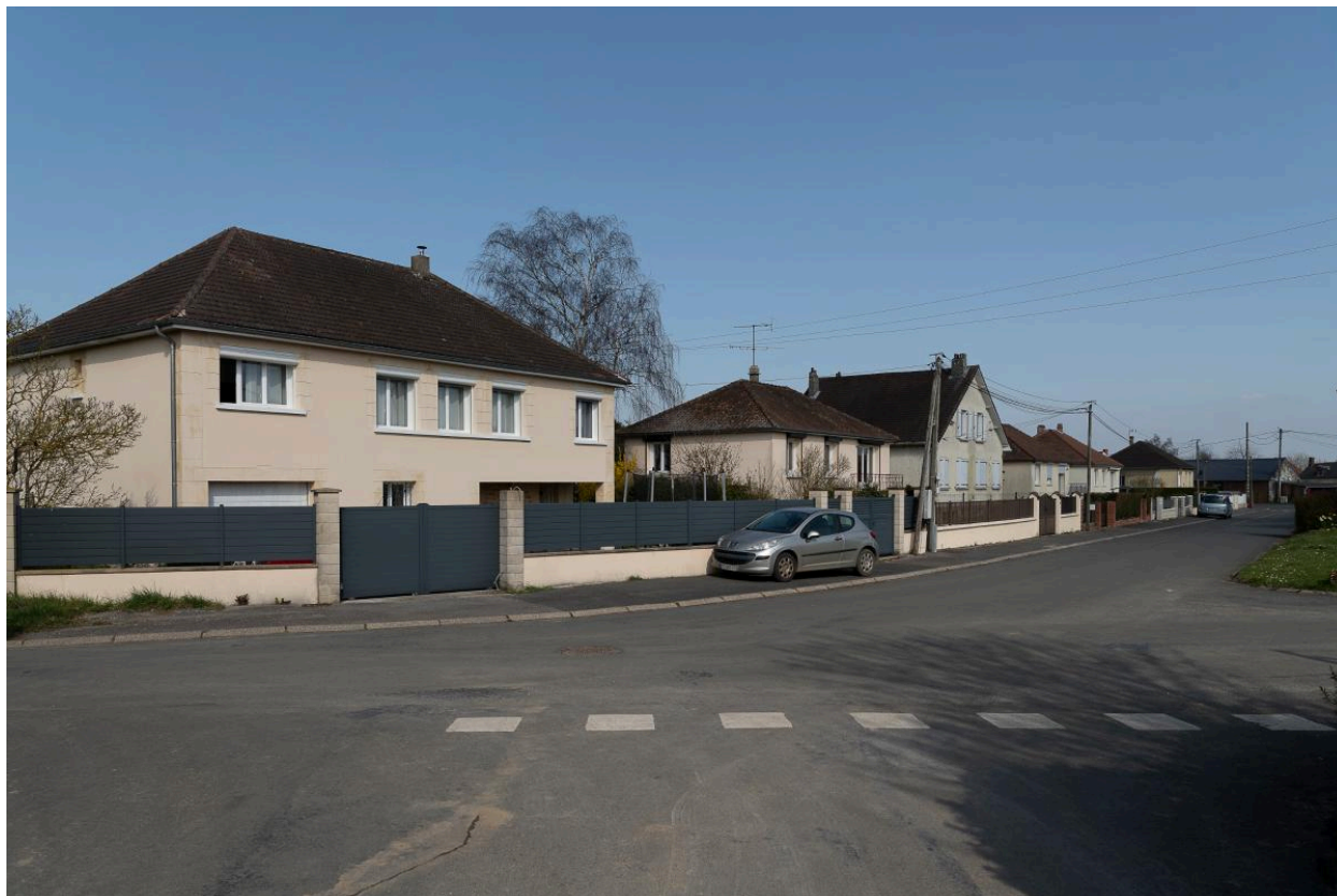
Pavillons construits dans la 2e moitié du 20e siècle, place des Tilleuls, vue depuis le sud-ouest.
