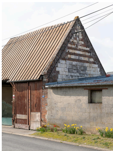
Mur coupe-feu en brique et pierre, n °5 rue de la Mairie, vue depuis l'est. Phot. Marc Kérignard IVR32_20226000218NUCA
