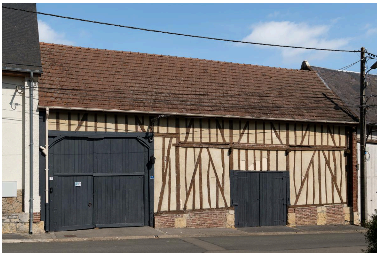
Ancienne grange sur rue avec entrée charretière, n°7 rue Prien, vue depuis le sud-est.
