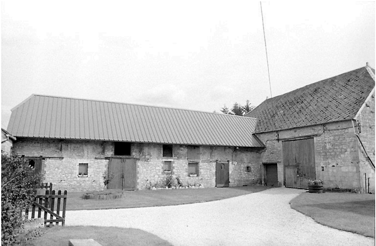
Vue générale de la grange et des étables depuis le nord-ouest.
