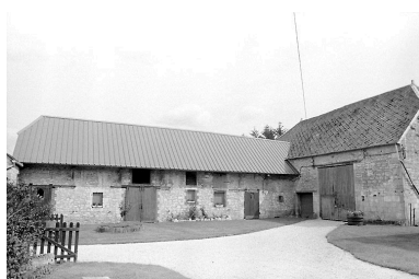
Vue générale de la grange et des étables depuis le nord-ouest. Phot. Xavier-Philippe Guiochon IVR22_19980201491Z
