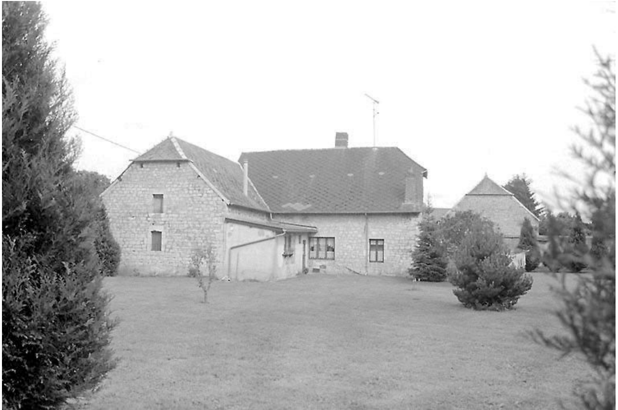
Elévation postérieure du logis.
