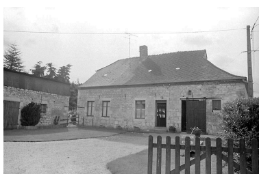
Elévation antérieure du logis. Phot. Xavier-Philippe Guiochon IVR22_19980201488Z
