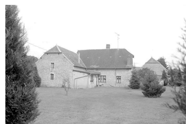
Elévation postérieure du logis. Phot. Xavier-Philippe Guiochon IVR22_19980201496Z
