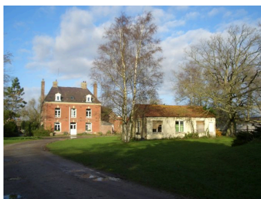
Vue générale. Phot. Inès Guérin IVR22_20068005636NUCA
