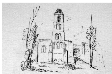
Boves. [Eglise Notre-Dame-des-Champs. Façade nord], dessin, par Louis Duthoit (En voyage avec Aimé et Louis Duthoit, 1979). Phot. Thierry Lefébure IVR22_20048000046NUCA
