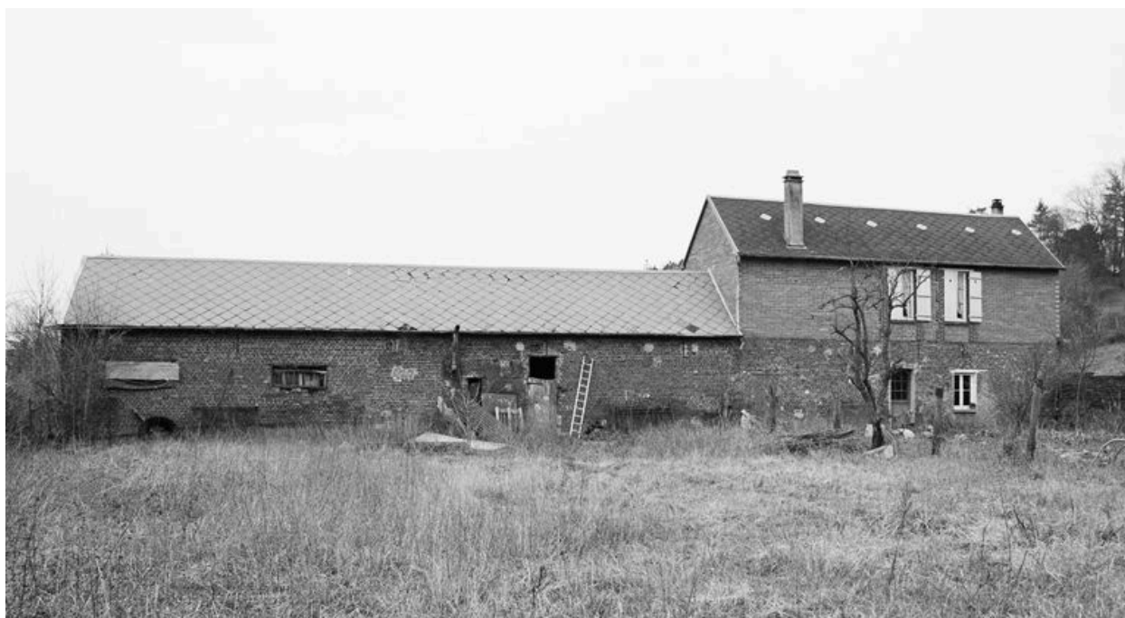
Ferme de la sucrerie : logis et dépendance agricole en prolongement.
