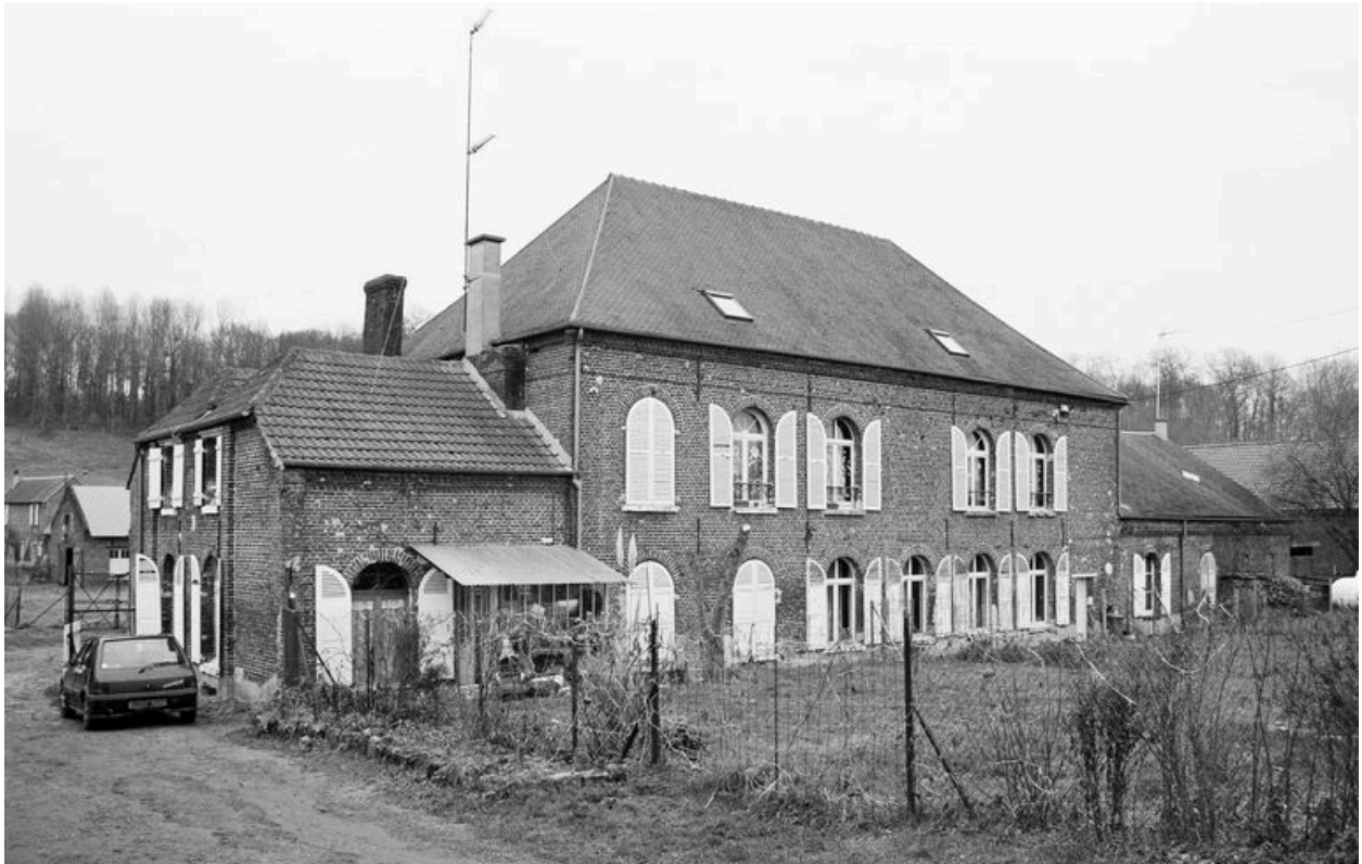
Logement patronal et bureaux : façade antérieure.
