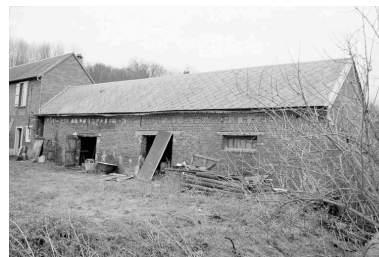
Ferme de la sucrerie : étable. Phot. Bertrand Fournier IVR22_20006000039Z
