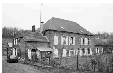
Logement patronal et bureaux : façade antérieure. Phot. Bertrand Fournier IVR22_20006000041Z
