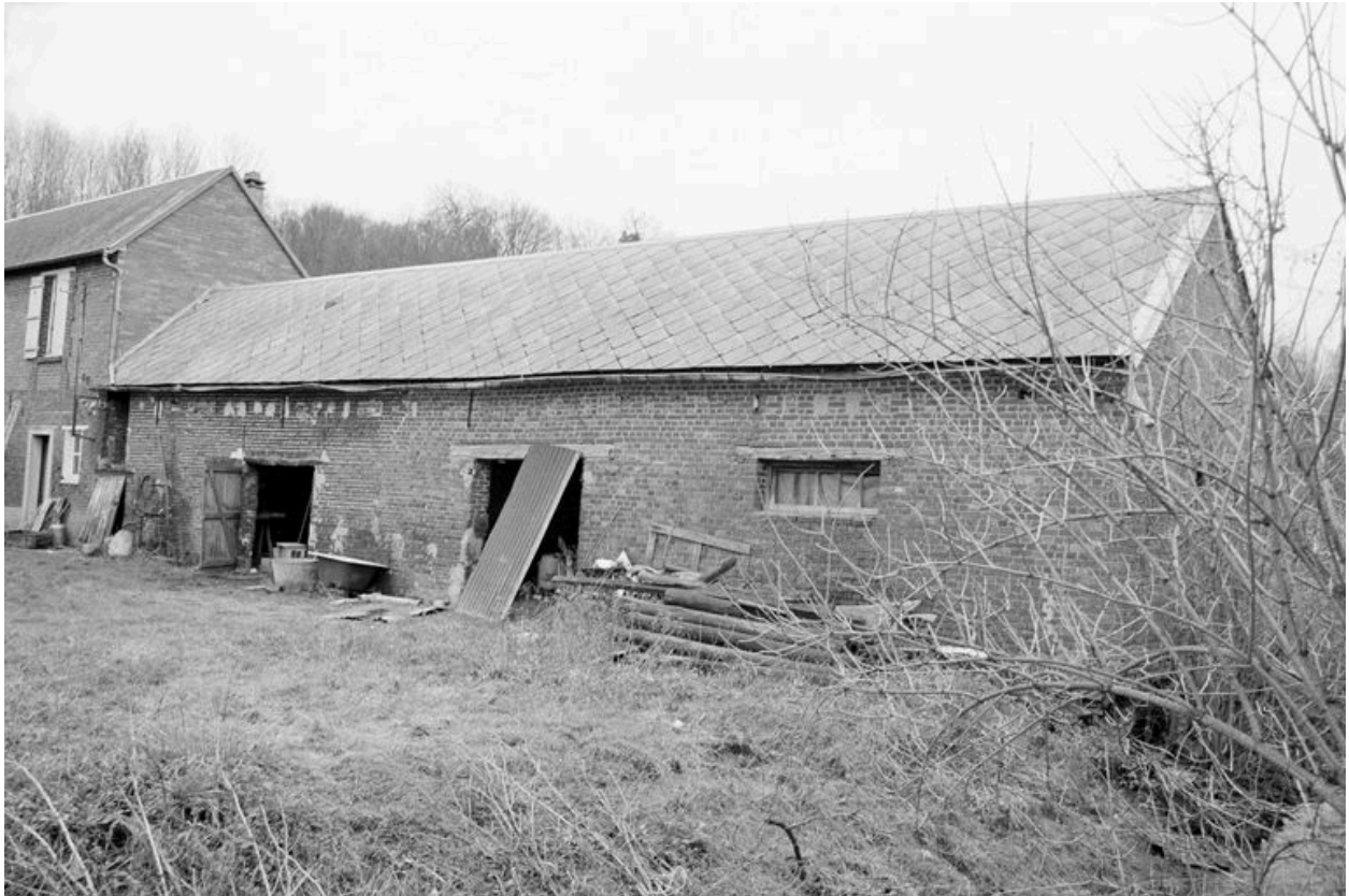
Ferme de la sucrerie : étable.
