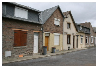
Façade antérieure. Phot. Frédéric Pillet IVR22_20060205038NUCA
