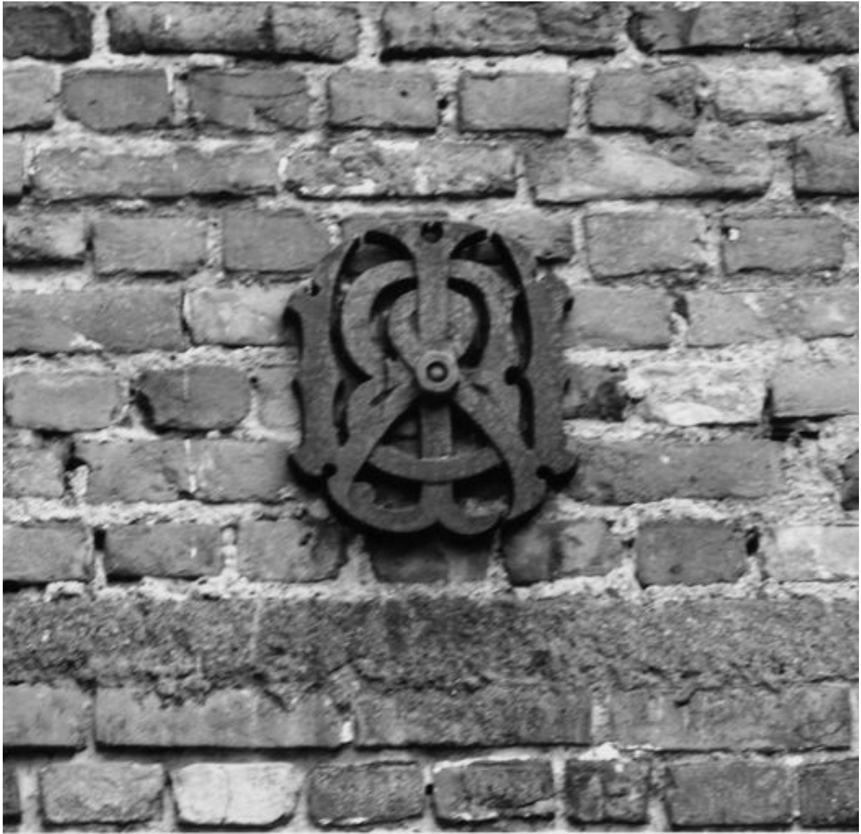
Détail sur une ancre de tirant.
