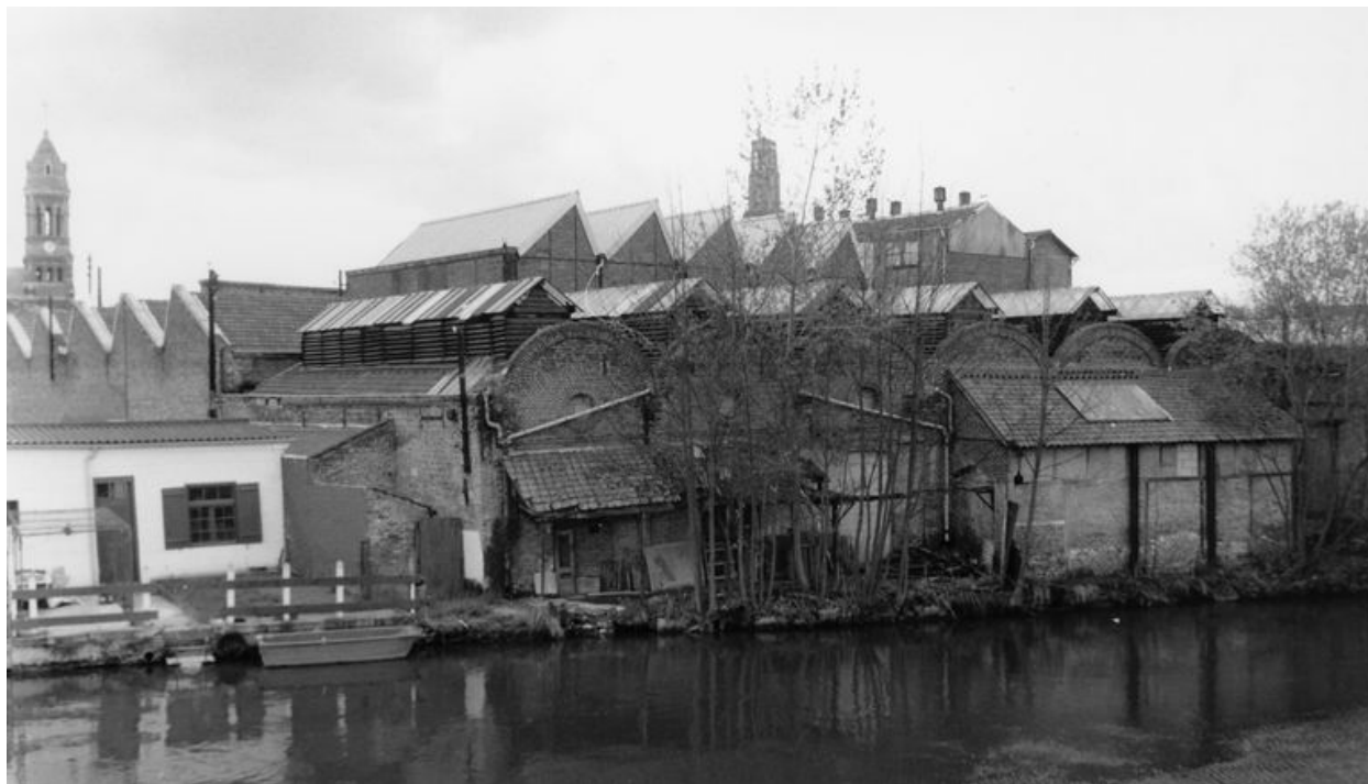
Vue de situation depuis le nord.
