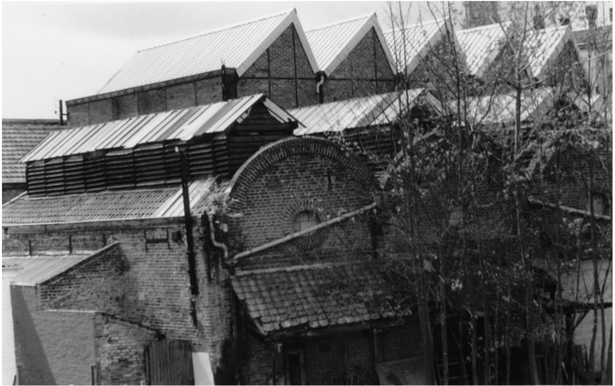
Détail sur les ateliers.
