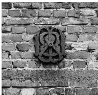
Détail sur une ancre de tirant. Phot. Thierry Lefébure IVR22_19898000090X
