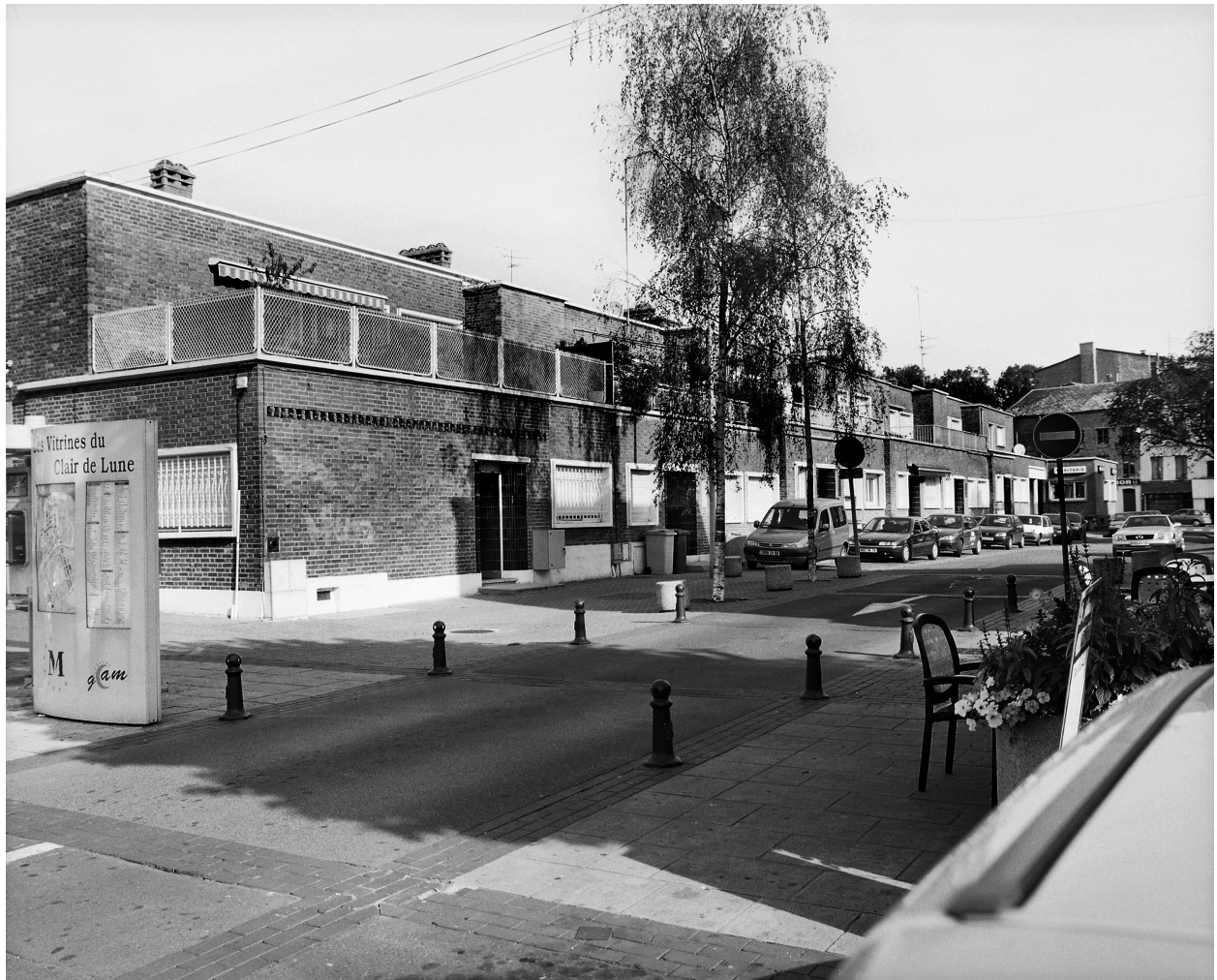
Bloc 3 de l'îlot D : alignement postérieur.
