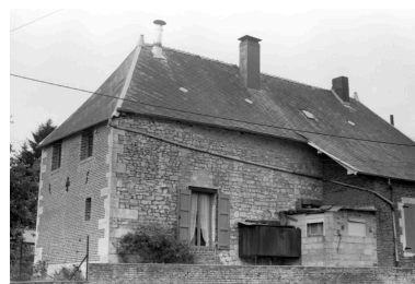
Elévation postérieure. Phot. Xavier-Philippe Guiochon IVR22_19980201526Z
