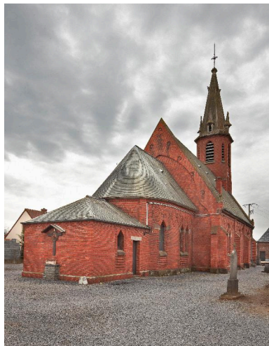
Vue générale depuis le chevet. Phot. Hubert Bouvet IVR31_20105900091NUCA
