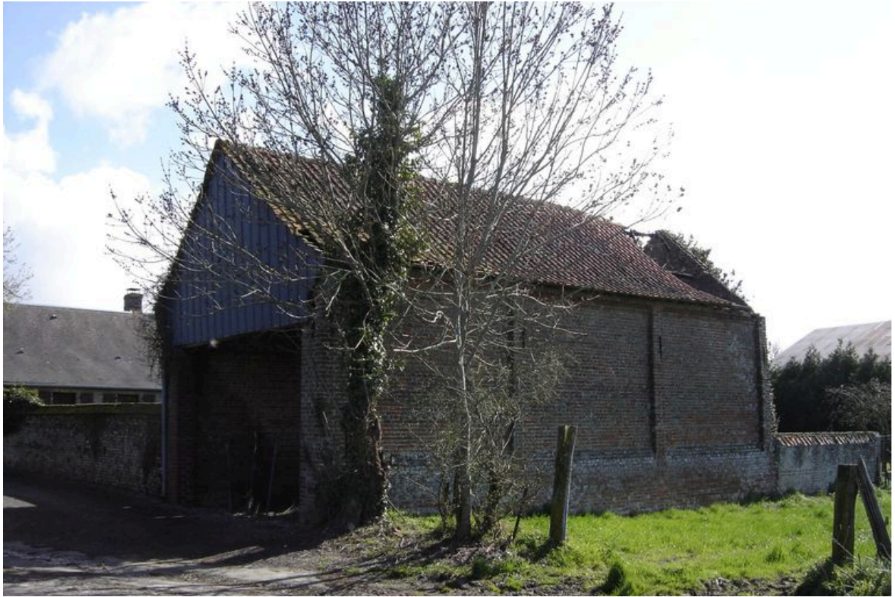
Vue du hangar en fond de parcelle.
