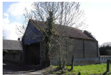
Vue du hangar en fond de parcelle. Phot. Inès Guérin IVR22_20058005479NUCA
