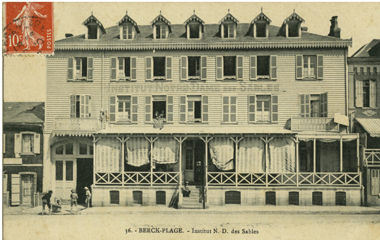
Elévation antérieure sur l'Entonnoir avant l'ajout des galeries de cure, vue générale prise de face. Carte postale, début du 20e siècle (coll. part).
