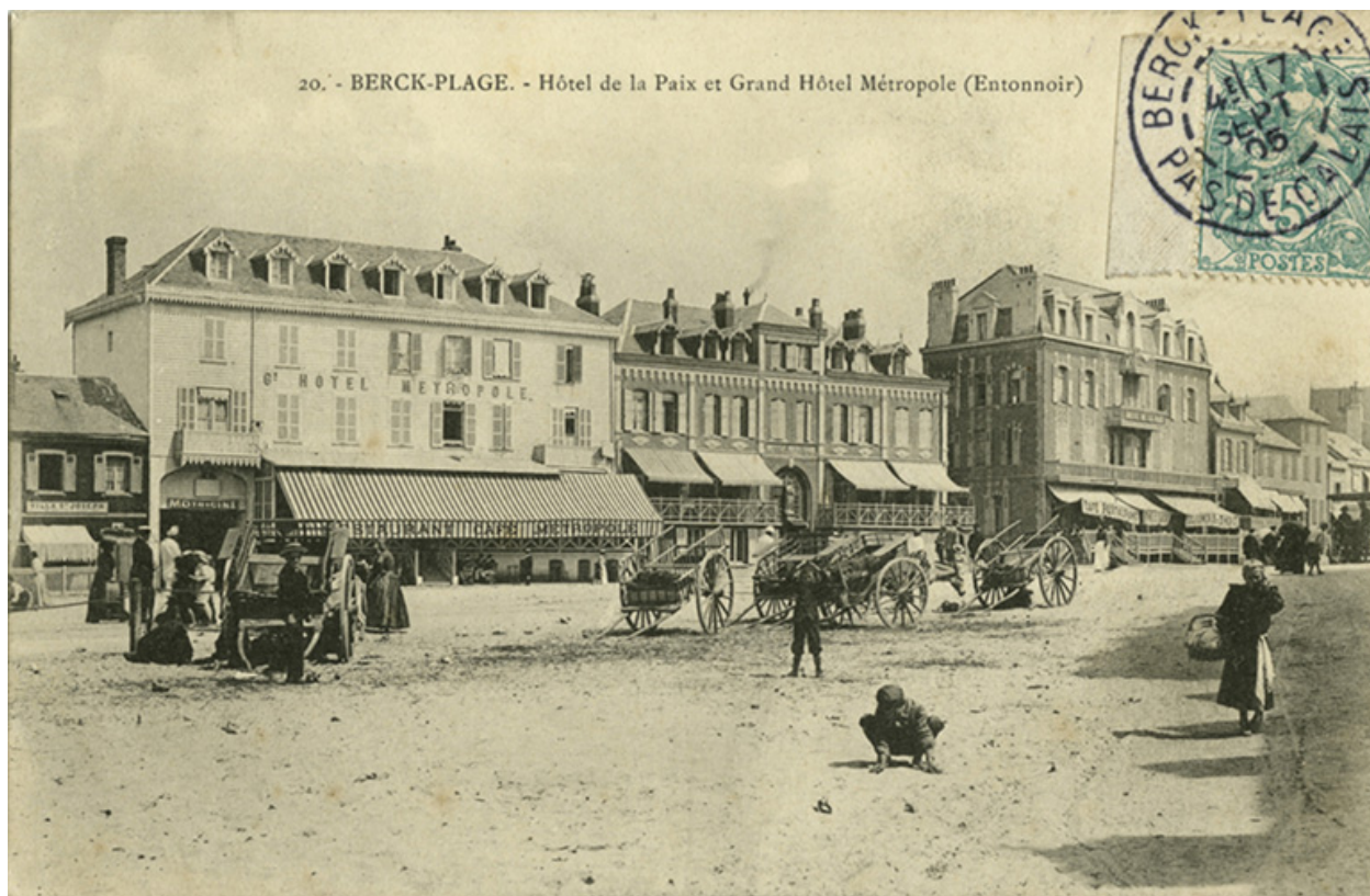
Grand hôtel Métropole, devenu ensuite l'institut Notre-Dame-des-Sables, avec, sur la droite, l'institut Notre-Dame, élévations antérieures sur l'Entonnoir, vue d'ensemble prise de trois-quarts gauche. Carte postale, début du 20 e siècle(coll. part).
