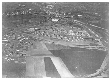
Photo aérienne de la cité de cheminots avant son achèvement. Photographie ancienne, photographe inconnu, vers 1925 (ANMT Roubaix, 202 AQ 1189). Phot. Eddy Stein IVR31_20015902067NUC
