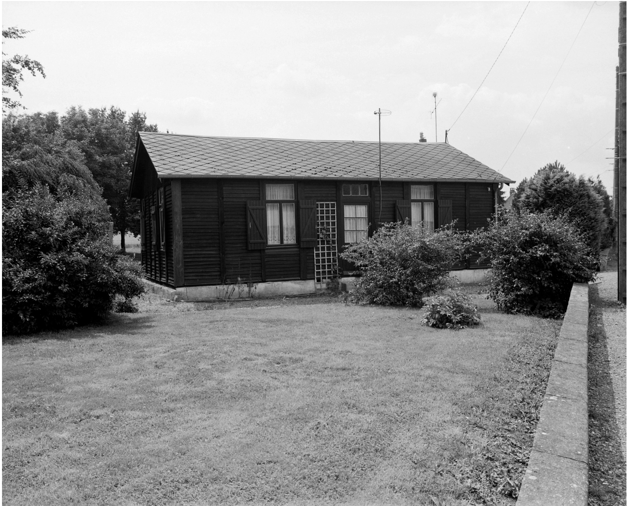
Vue générale d'une maison en bois de la cité Ferrer.
