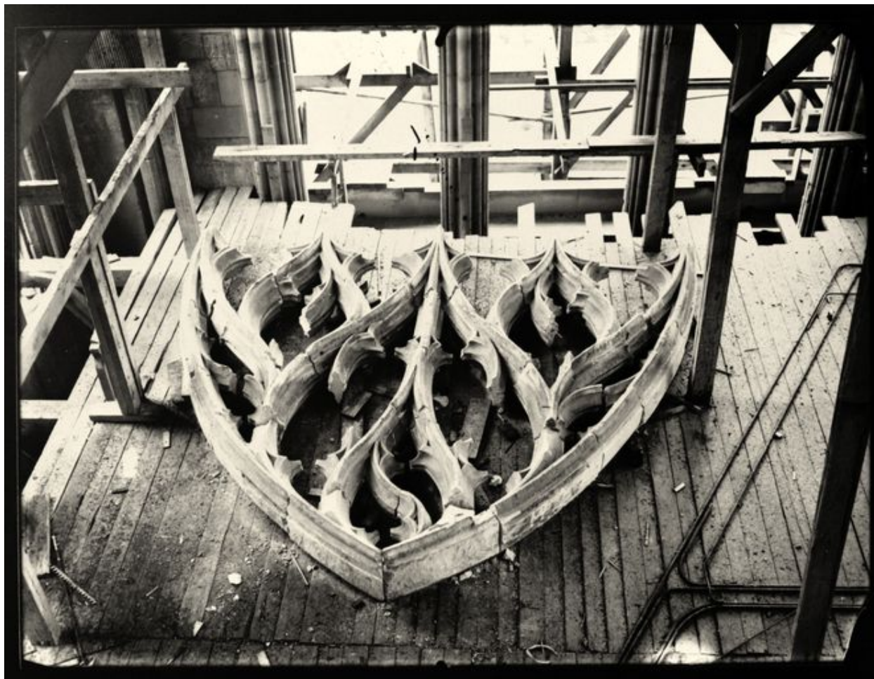
Vue du tympan d'une fenêtre déposé, à des fins de restauration (photographie de l'entre-deux-guerres).
