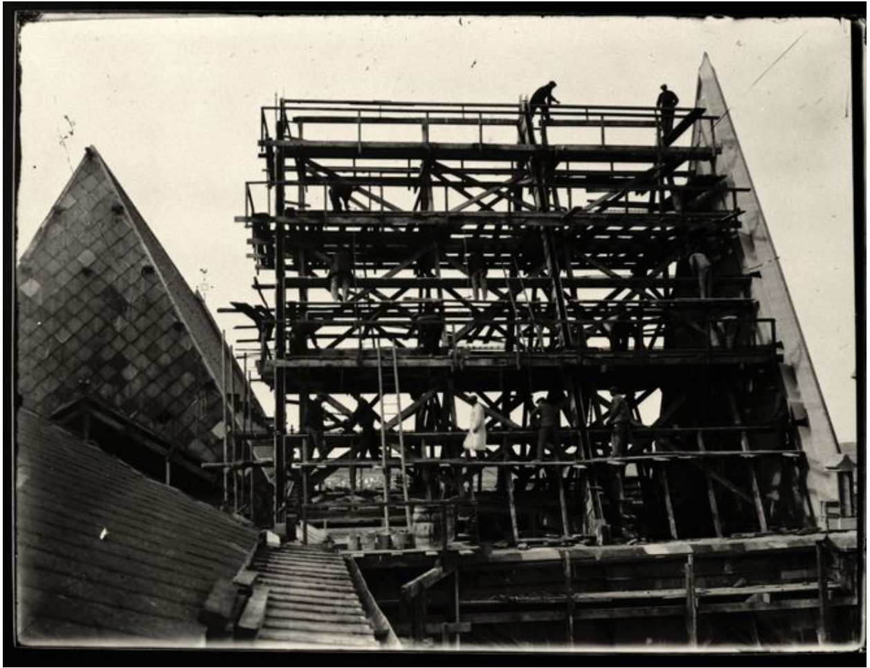
Construction de la charpente du bras nord du grand transept (photographie de la première moitié des années trente).
