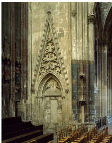
Bras sud du grand transept : vue de l'ancienne porte du chapitre. Phot. Thierry Lefébure IVR22_20090200174VA
