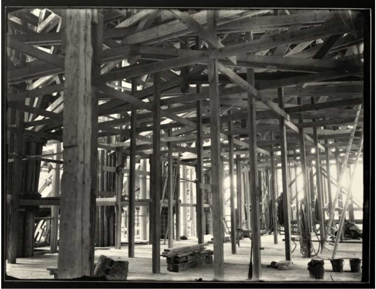
Faux plancher et ouvrage en charpente permettant de restaurer les parties supérieures de l'église (photographie de l'entre-deux-guerres).
