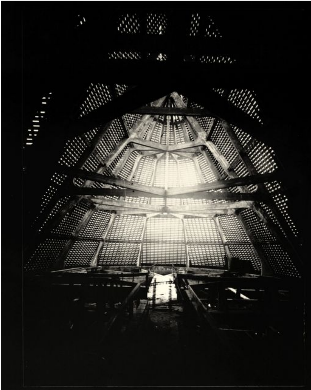
Vue intérieure de la charpente de l'abside, pendant la pose de la couverture (photographie des années trente).
