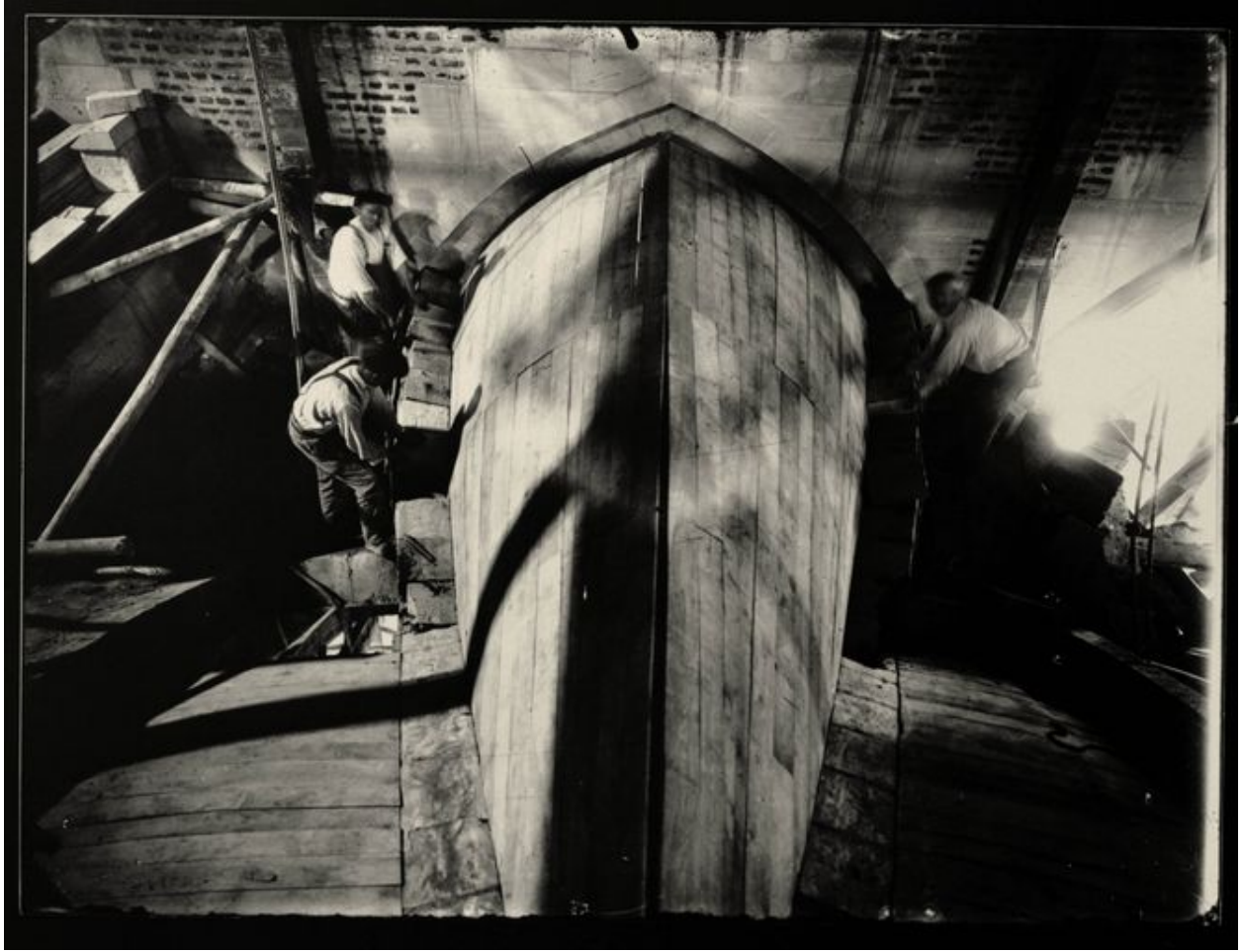
Réfection de l'extrados des voûtes du vaisseau central ou des transepts.
