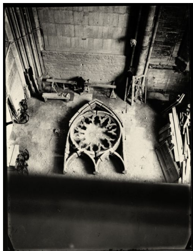
Partie supérieure d'une baie de l'abside en cours de restauration (photographie de l'entre-deux-guerres).
