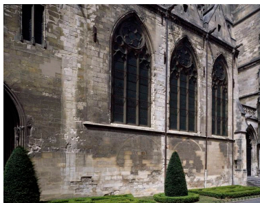
Traces des arcs du cloître sur le mur des chapelles sud du choeur. Phot. Thierry Lefébure IVR22_20090200160VA
