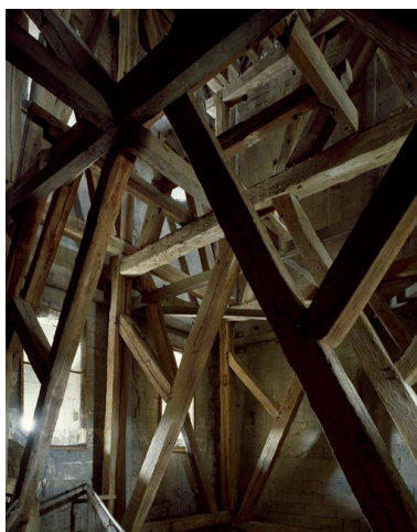
Vue de la charpente du clocher. Phot. Thierry Lefébure IVR22_20100200257VA
