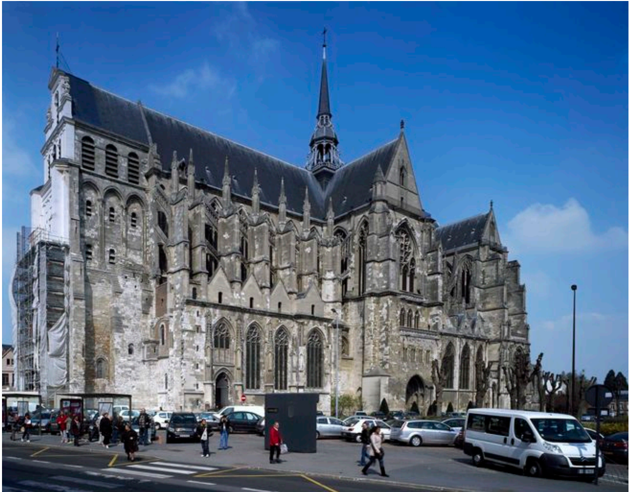
Vue de l'élévation sud.
