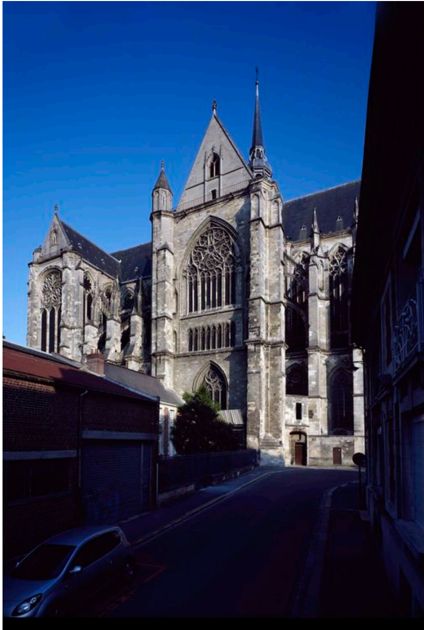
Vue de l'élévation nord du choeur.
