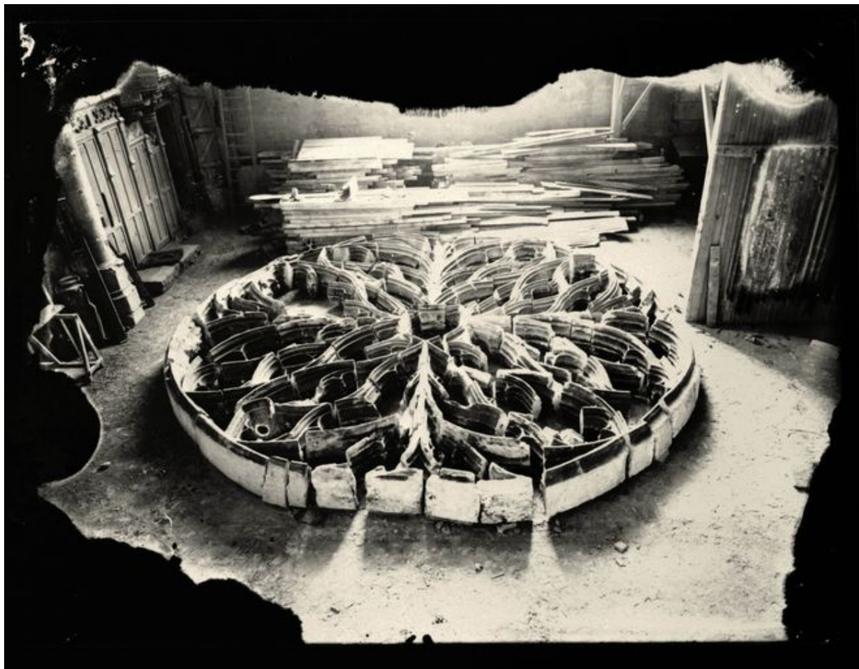
Vue de la rose du bras nord du petit transept, déposée pour être restaurée (photographie de l'entre-deux-guerres).
