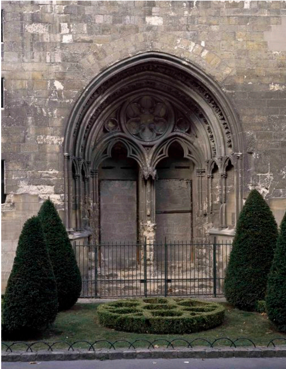
Elévation sud du grand transept : portail "du cloître".
