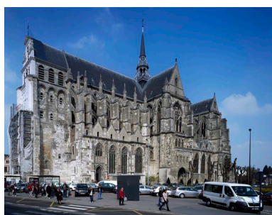
Vue de l'élévation sud.
