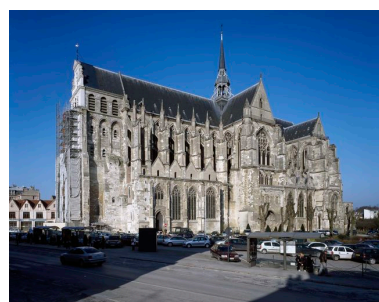
Vue de l'élévation sud.
