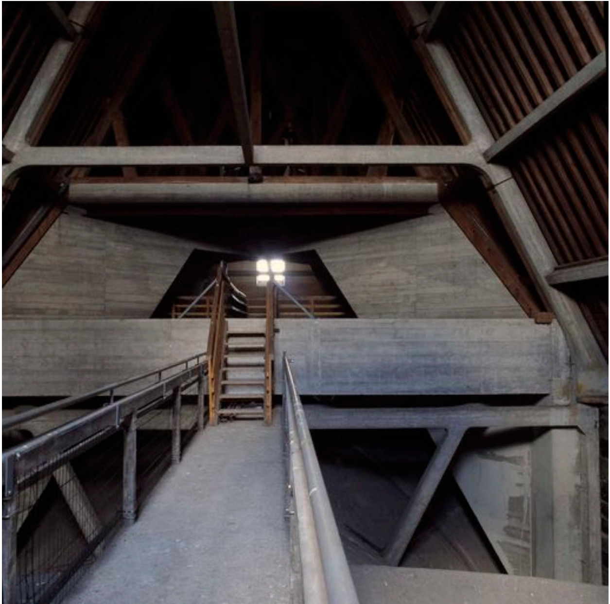
Vue de la charpente en béton du petit transept.
