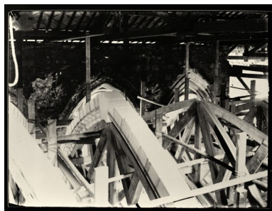
Les voûtes, en cours de reconstruction (photographie de l'entre-deux-guerres). Phot. Jean-Michel Périn (reproduction) IVR22_19840200064XB
