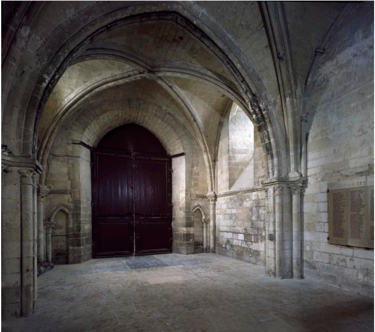
Vue du rez-de-chaussée du clocher-porche.
