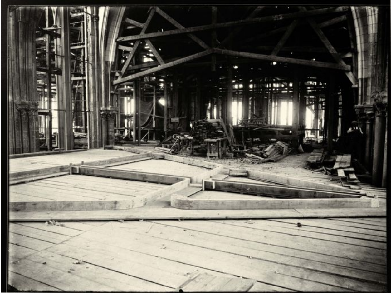
Vue d'une ferme de la charpente (photographie de l'entre-deux-guerres).
