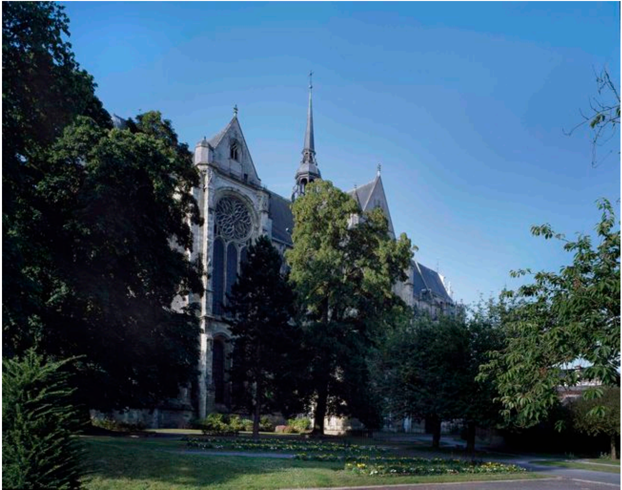
Vue de l'élévation nord.
