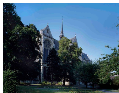
Vue de l'élévation nord. Phot. Thierry Lefébure IVR22_20090200155VA
