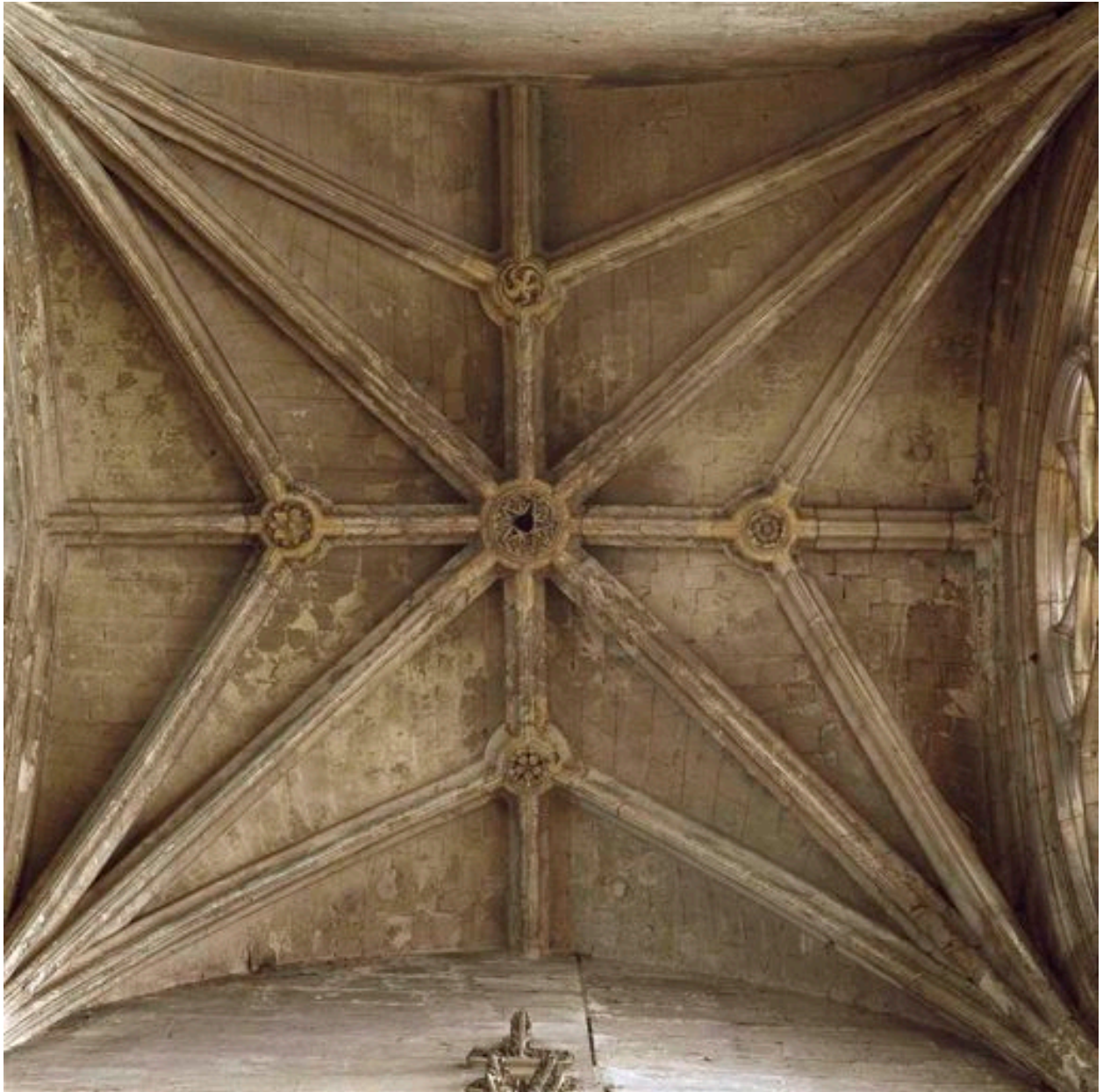
Voûte de la chapelle Saint-Fursy.
