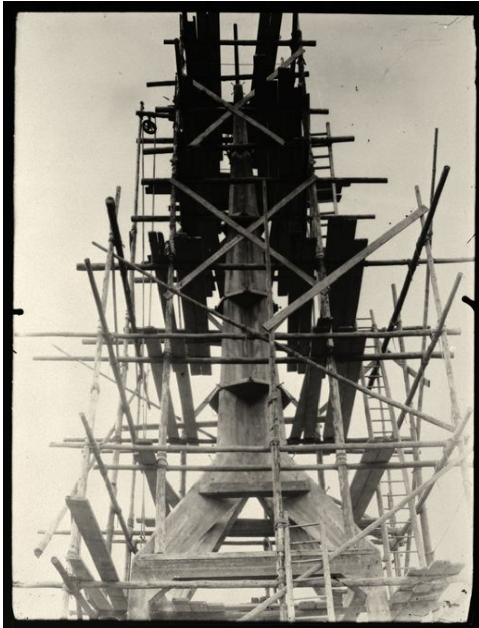
Construction de la charpente de l'abside (photographie des années trente).
