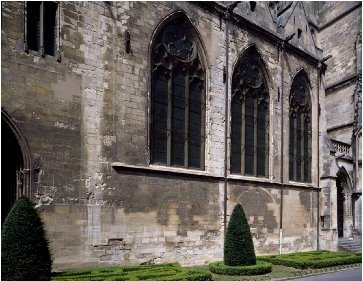
Traces des arcs du cloître sur le mur des chapelles sud du choeur.
