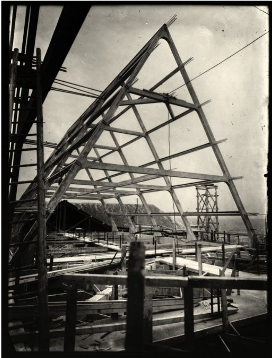
Construction de la charpente du choeur (photographie de la première moitié des années trente).
