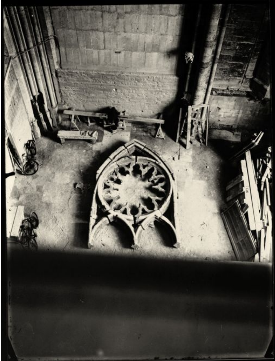
Partie supérieure d'une baie de l'abside en cours de restauration (photographie de l'entre-deux-guerres).
