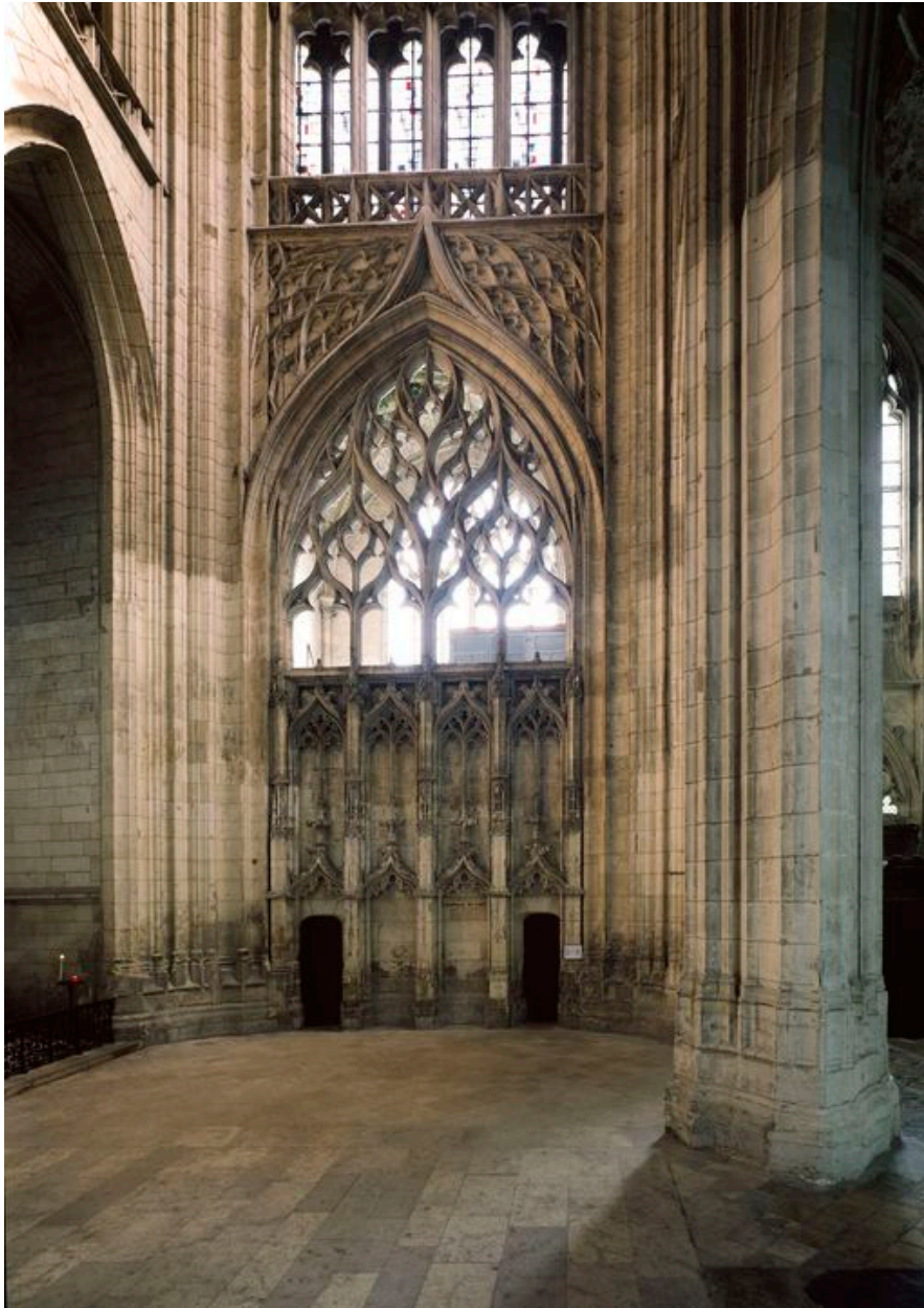
Vue intérieure du bras sud du second ou petit transept.
