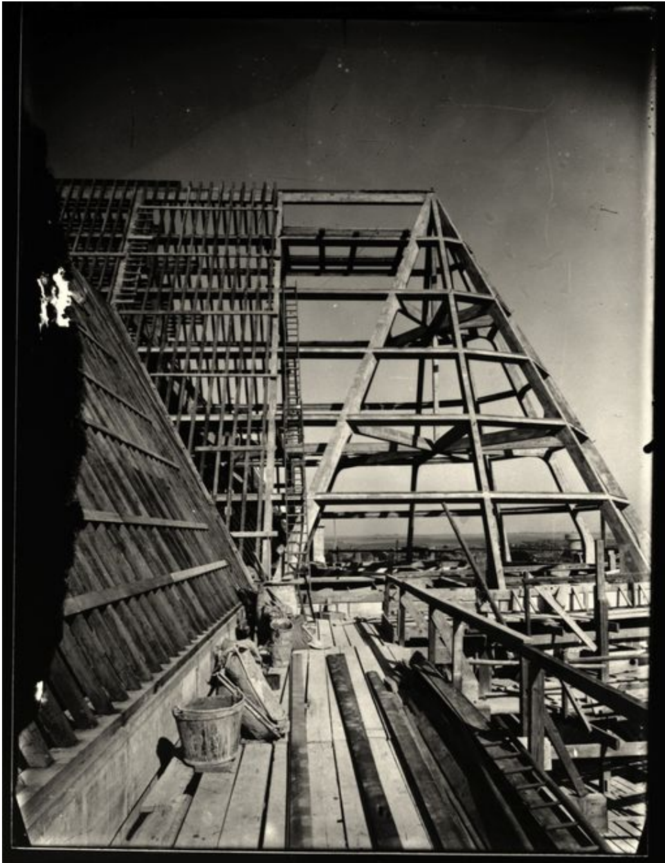
Pose de la couverture de l'abside (photographie des années trente).
