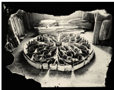
Vue de la rose du bras nord du petit transept, déposée pour être restaurée (photographie de l'entre-deux-guerres).
