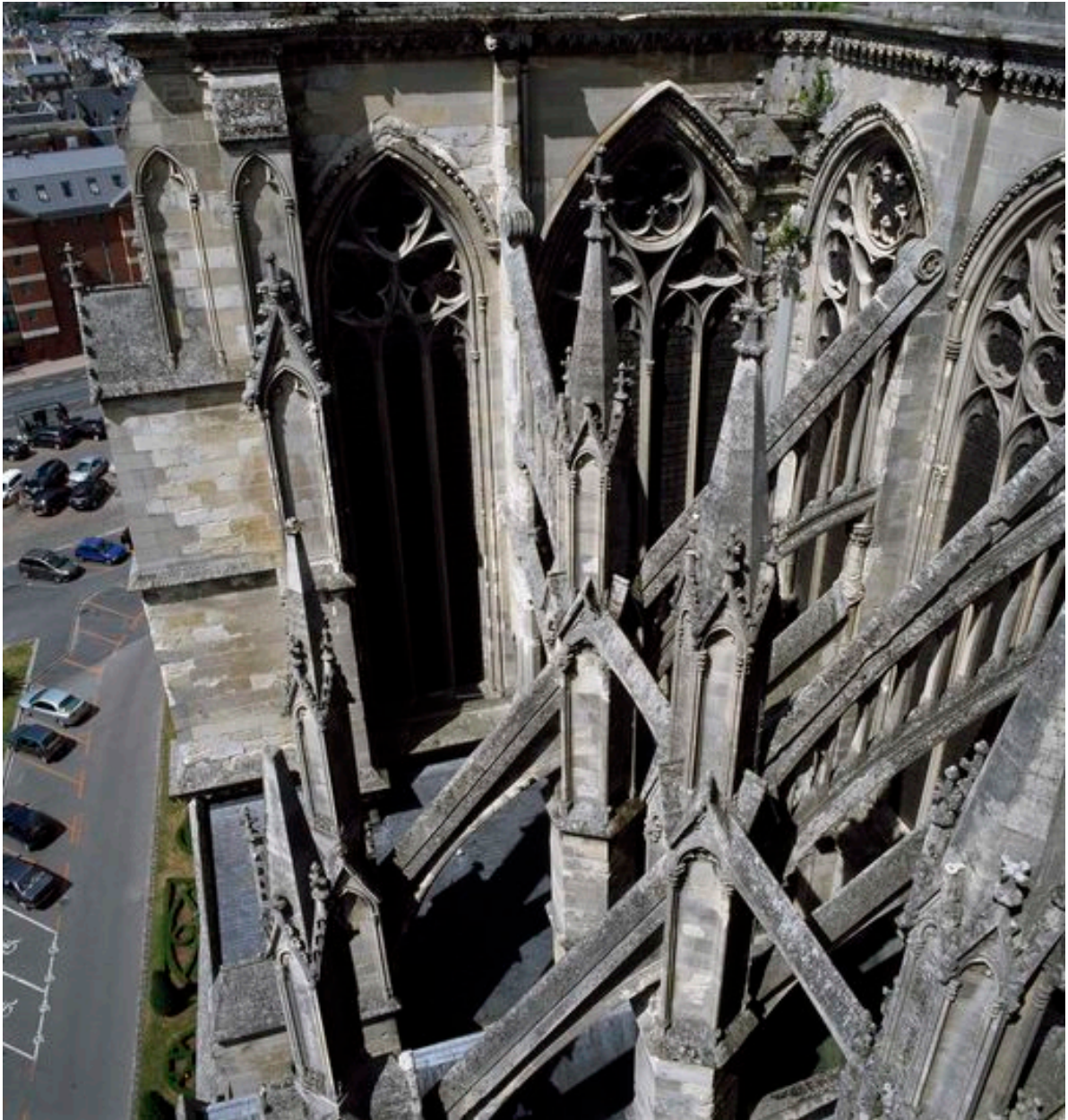
Vue du contrebutement au sud du chœur.
