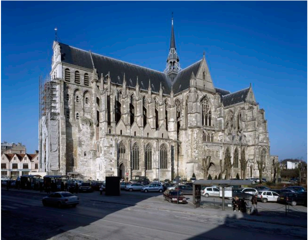
Vue de l'élévation sud.
