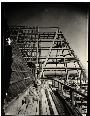
Pose de la couverture de l'abside (photographie des années trente). Phot. Jean-Michel Périn (reproduction) IVR22_19840200069XB
