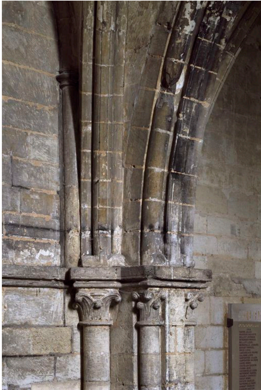
Chapiteaux et arcs du rez-de-chaussée du clocher-porche.
