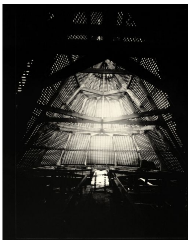
Vue intérieure de la charpente de l'abside, pendant la pose de la couverture (photographie des années trente). Phot. Jean-Michel Périn (reproduction) IVR22_19840200074XB
