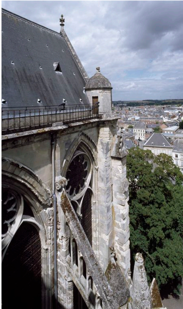
Vue partielle du bras nord du petit transept.
