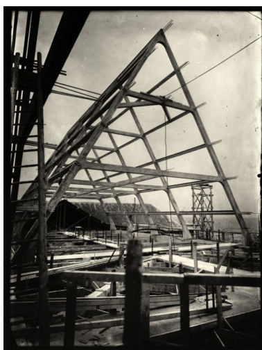
Construction de la charpente du chœur (photographie de la première moitié des années trente). Phot. Jean-Michel Périn (reproduction) IVR22_19840200062XB
