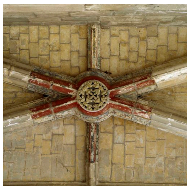
Voûte de la première travée du collatéral nord de la nef. Phot. Thierry Lefébure IVR22_20100200154XA
