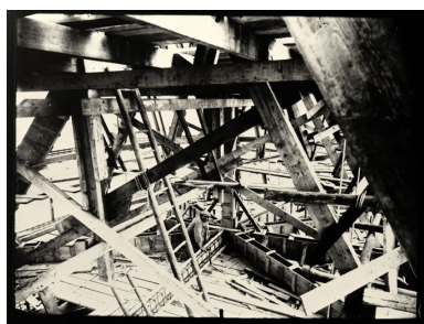
Construction de la charpente du chœur (photographie des années trente). Phot. Jean-Michel Périn (reproduction) IVR22_19840200055XB
