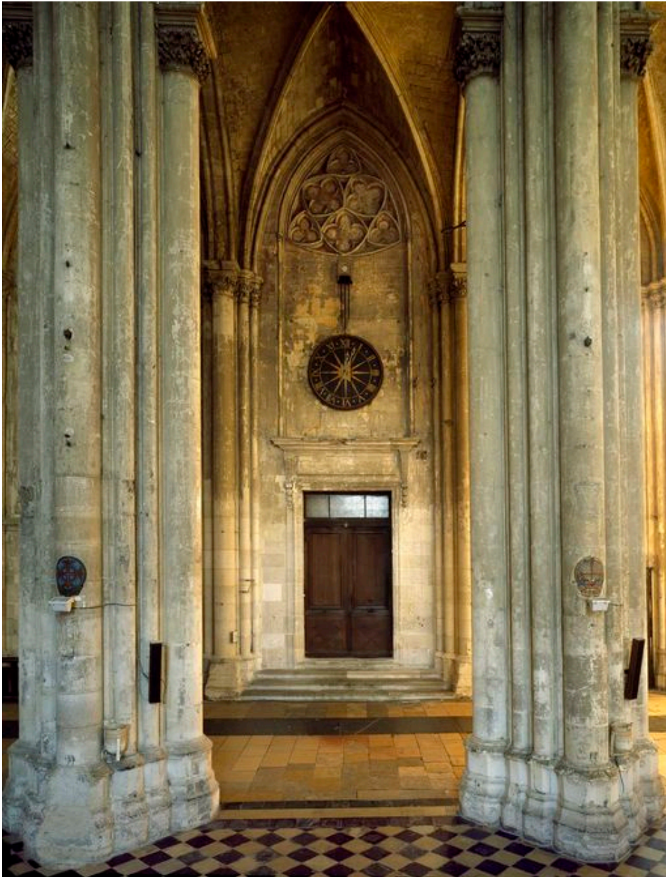
Détail du collatéral sud de la nef : porte conduisant jadis à la salle du chapitre.
