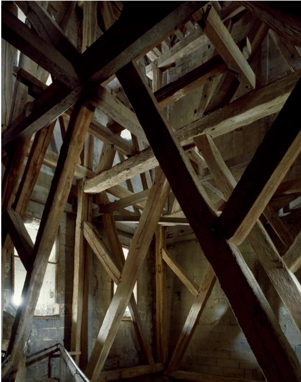
Vue de la charpente du clocher.
