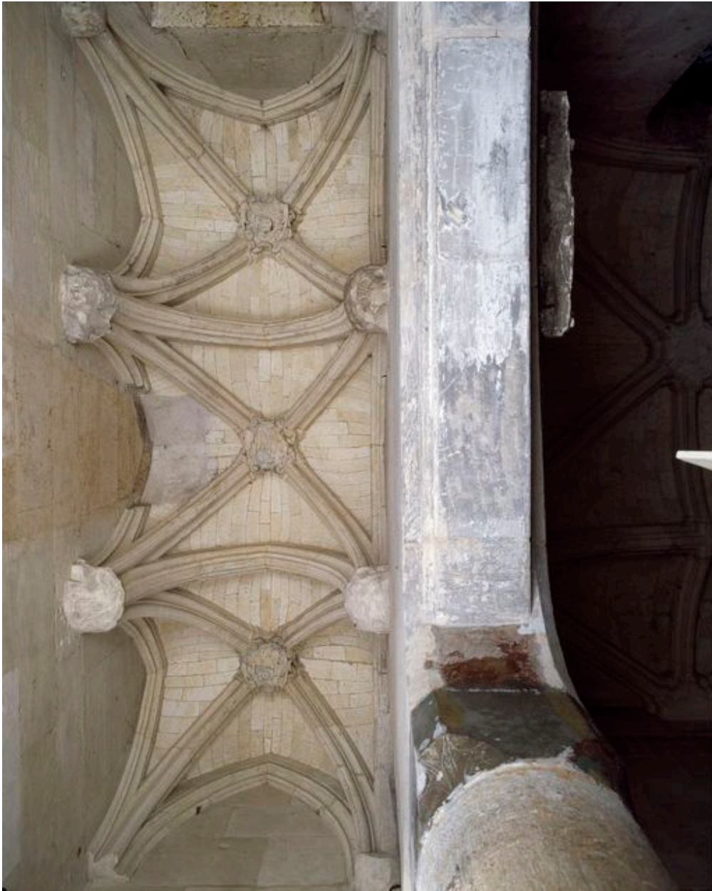
Détail de la voûte de la chapelle Saint-Fursy.
