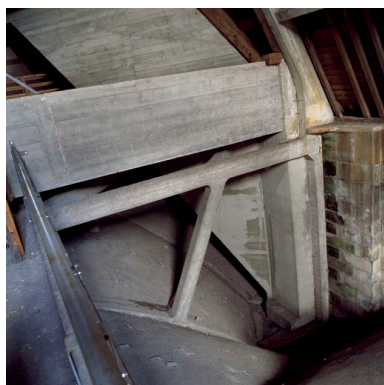
Détail de l'extrados des voûtes et de la charpente en béton. Phot. Thierry Lefébure IVR22_20100200243XA
