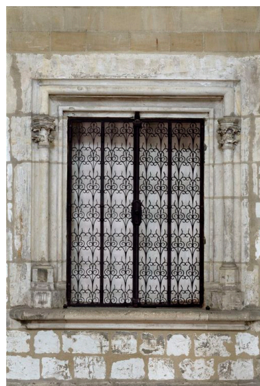
Ouverture ménagée dans le mur sud du choeur liturgique, servant jadis à l'exposition de reliquaires. Phot. Thierry Lefébure IVR22_20090200226XA
