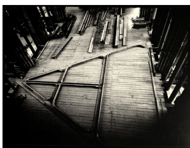
Vue d'une ferme de la charpente (photographie de l'entre-deux-guerres). Phot. Jean-Michel Périn (reproduction) IVR22_19840200068XB
