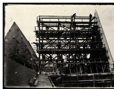
Construction de la charpente du bras nord du grand transept (photographie de la première moitié des années trente). Phot. Jean-Michel Périn (reproduction) IVR22_19840200066XB
