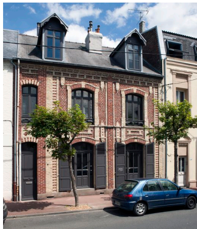
Vue générale. Phot. Pierre Thibaut IVR31_20146202197NUCA
