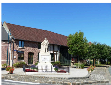
RIBEMONT-sur-ANCRES. Monument inauguré en 1921. Phot. Isabelle Barbedor IVR32_20168006048NUCA
