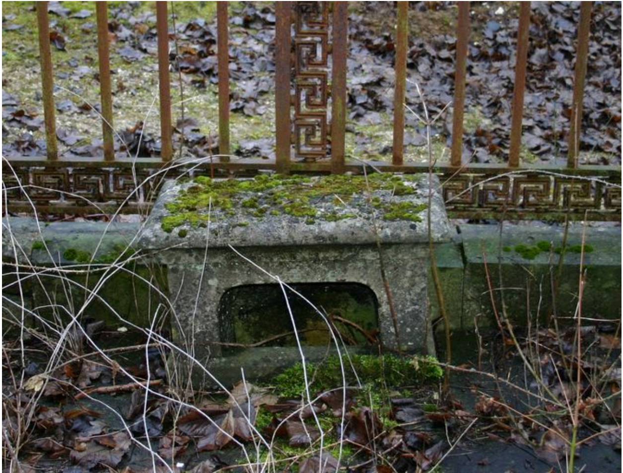
Banc en pierre, à usage de bouche d'aération du caveau.
