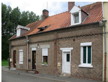
Façades sur rue des logements 235 à 239 rue des Prés. Phot. Bertrand Fournier IVR22_20128005074NUCA
