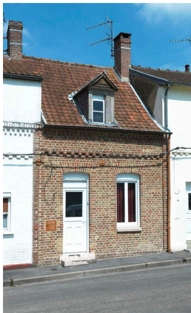
Façade sur rue du logement 247, rue des Prés, vue de trois-quarts. Phot. Thierry Lefébure IVR22_20128000283NUC2A
