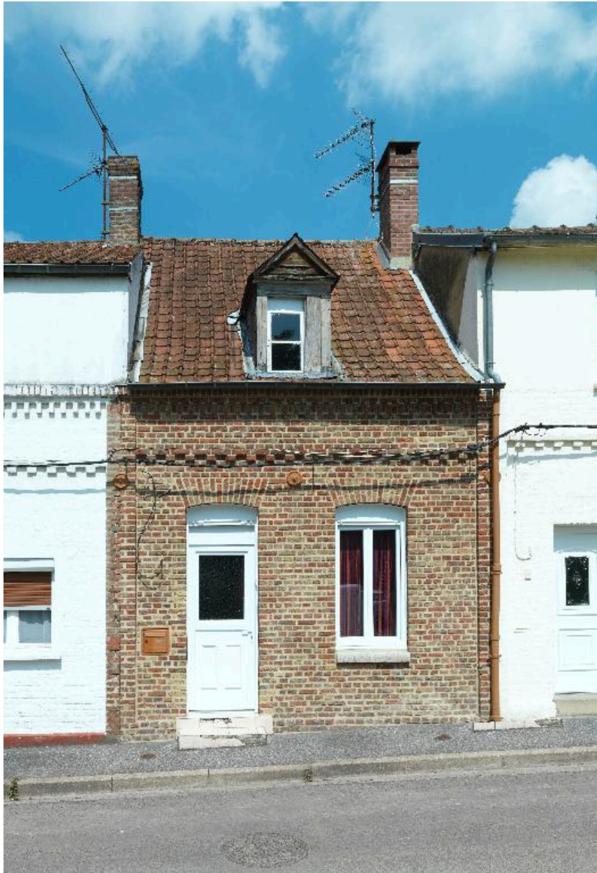
Façade sur rue du logement 247, rue des Prés.
