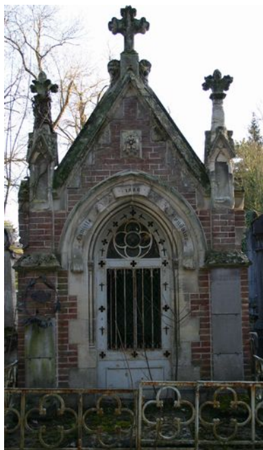
Vue rapprochée de la façade principale du tombeau-chapelle. Phot. Caroline Vincent IVR22_20088000246NUCA
