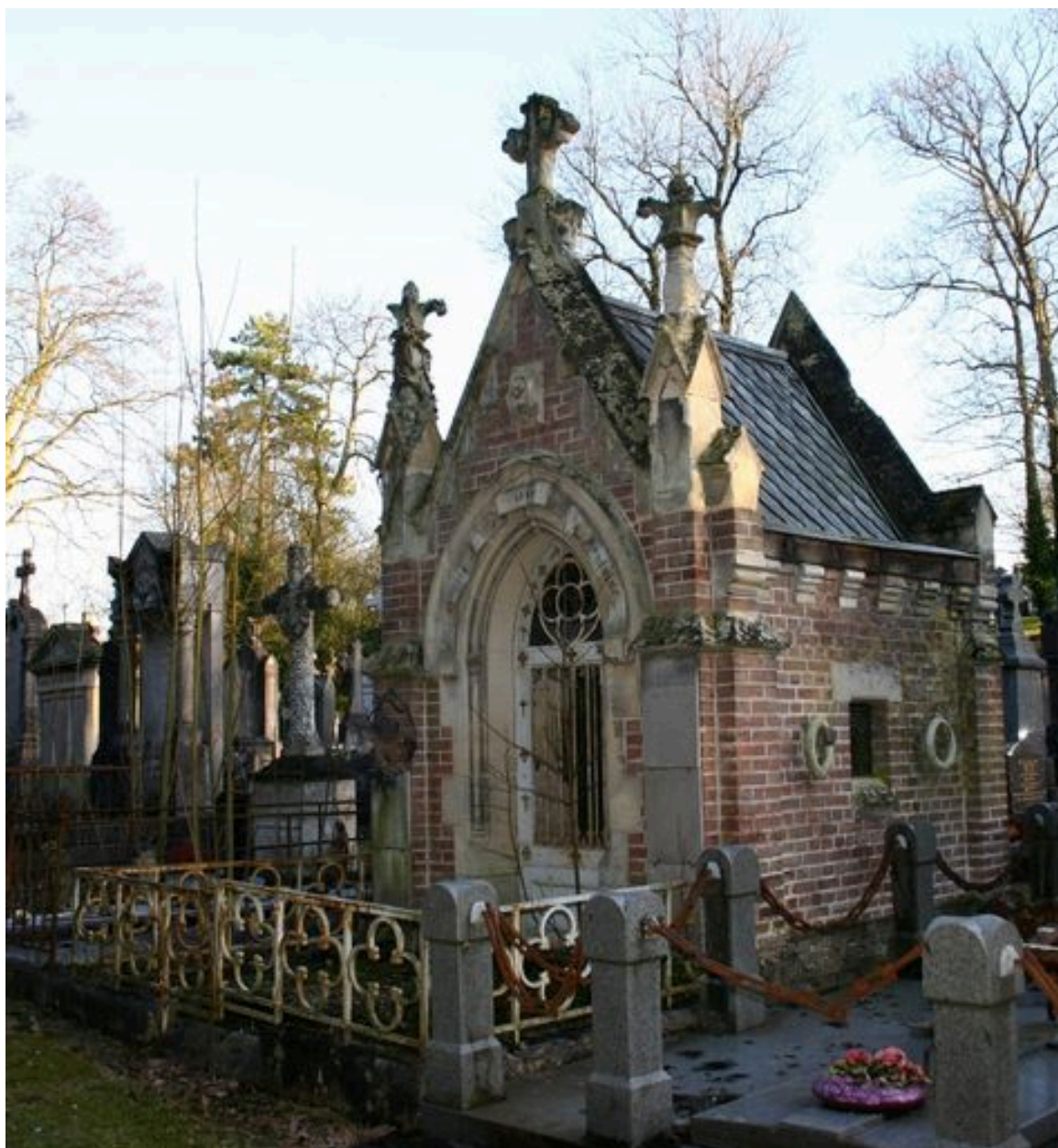
Vue générale, depuis le côté.
