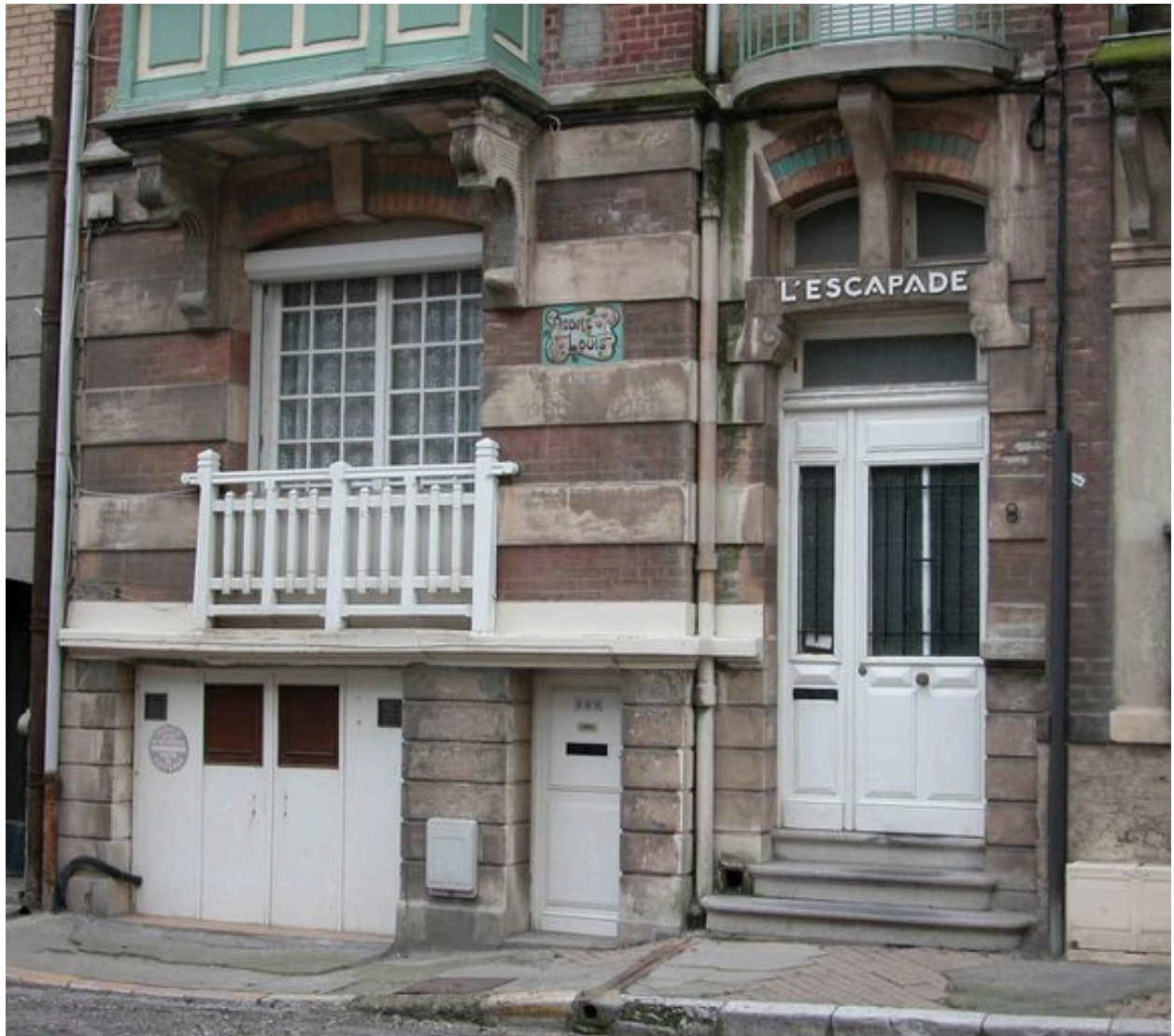
Détail du sous-sol semi-enterré habitable.
