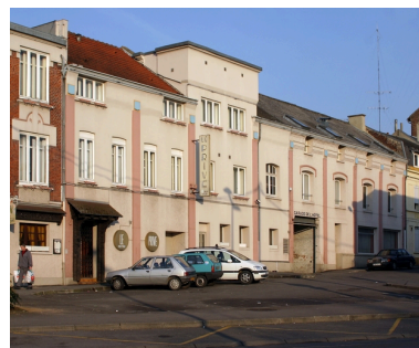
Façade antérieure, rue Michelet : on identifie, au centre, la touraille arasée. Phot. Frédéric Pillet IVR22_20050206168NUCA
