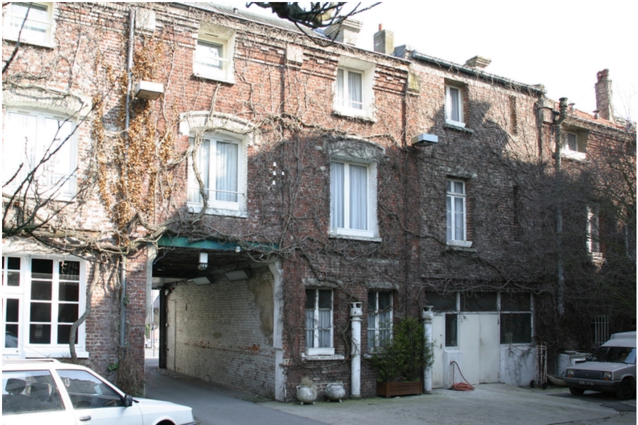
Façade postérieure de bâtiment aligné sur la rue Michelet.
