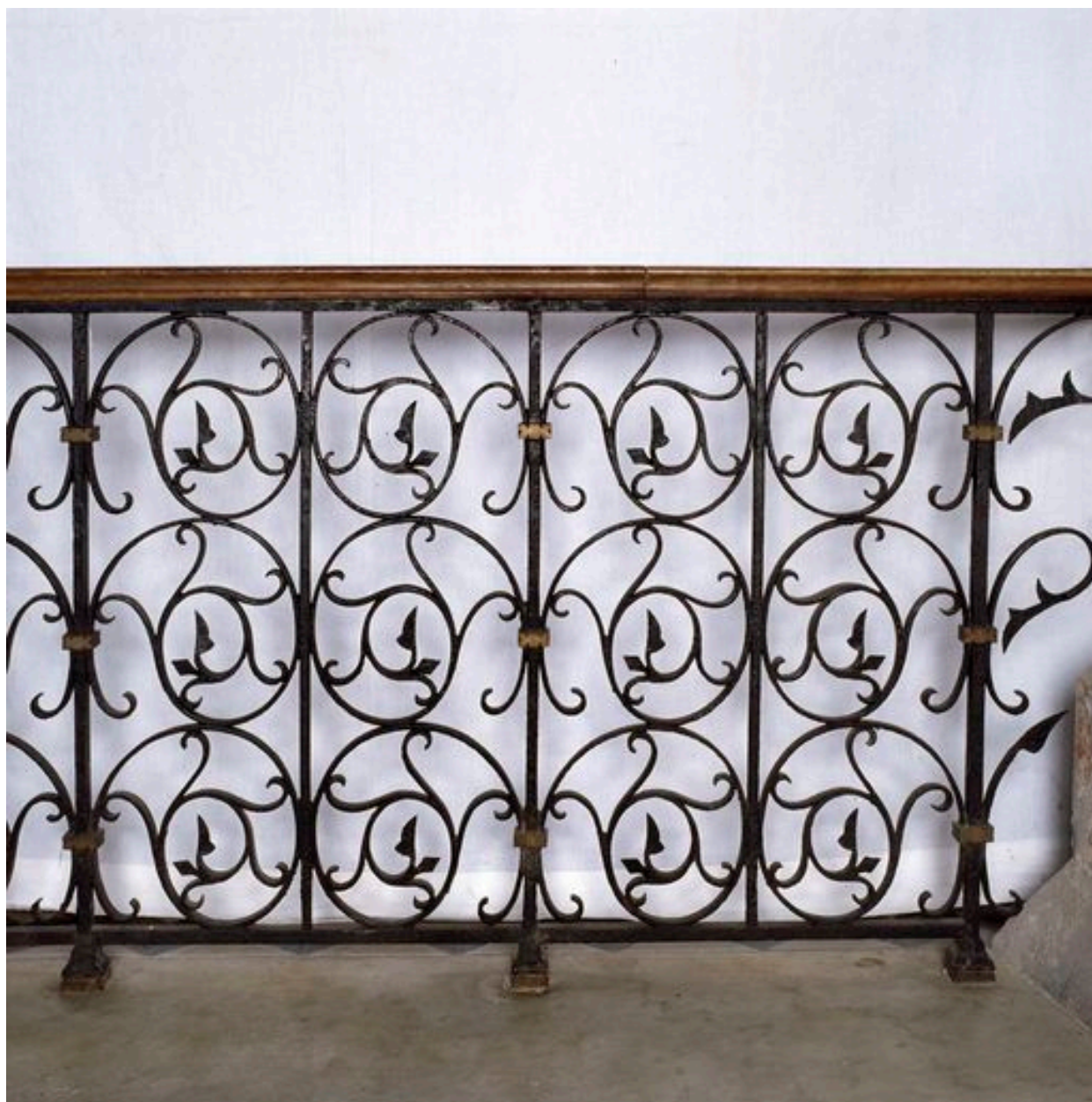
Détail de la clôture.
