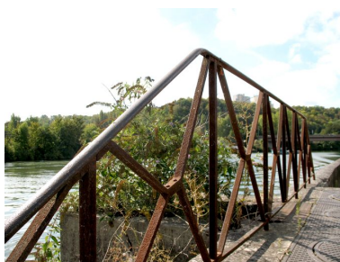
Détail du garde-corps en fonte.
