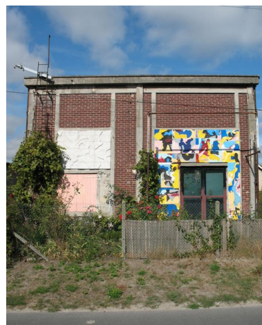
Mur pignon sud de la station de pompage. Phot. Clarisse Lorieux IVR22_20096005171NUCA
