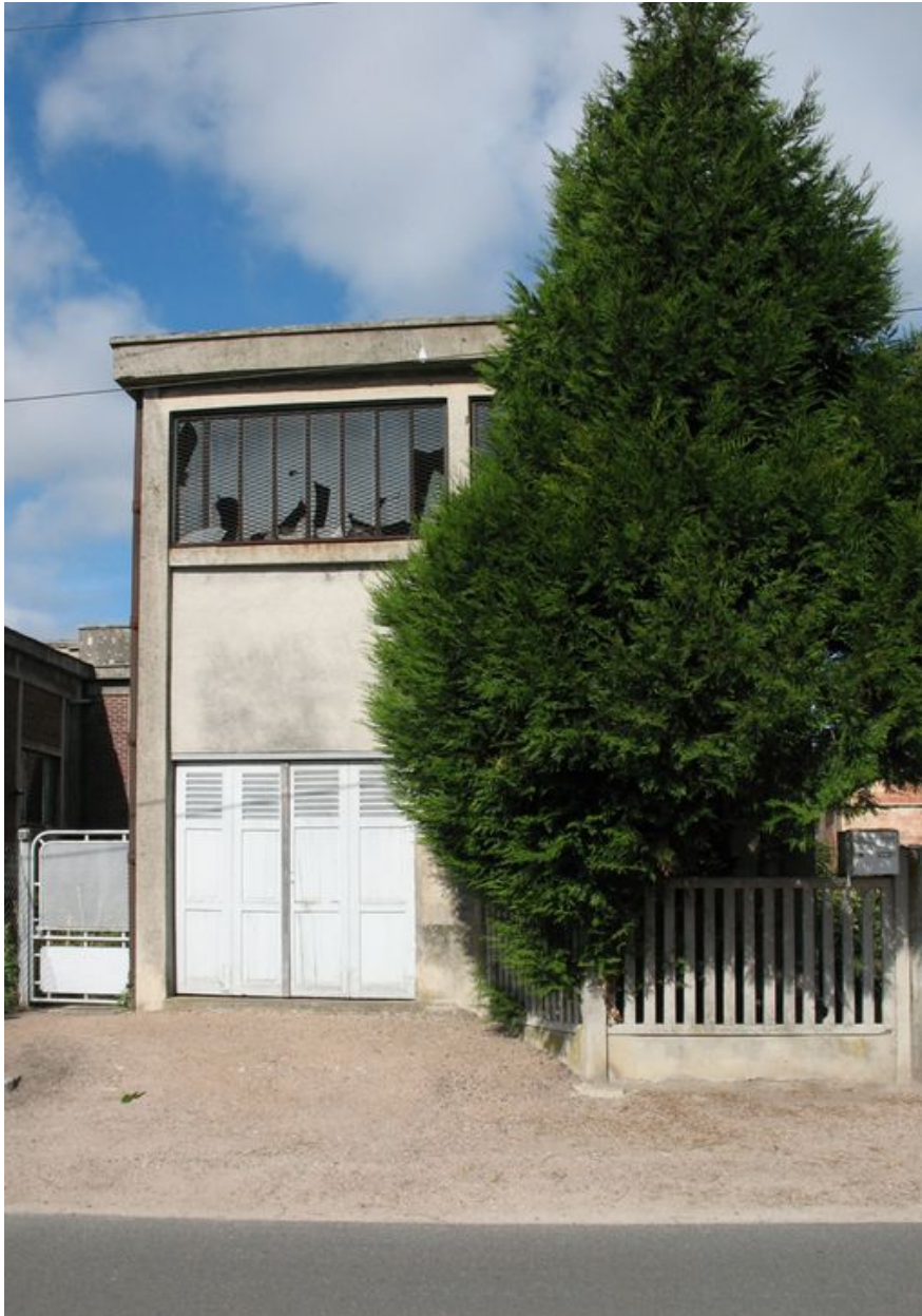
Transformateur électrique de la station de pompage.
