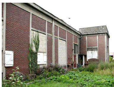
Façade est de la station de pompage et annexe surmontée du réservoir d'eau.
