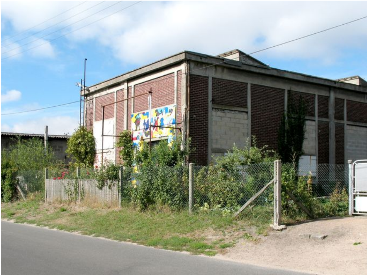
Vue générale de la station de pompage depuis le quai d'Amont.
