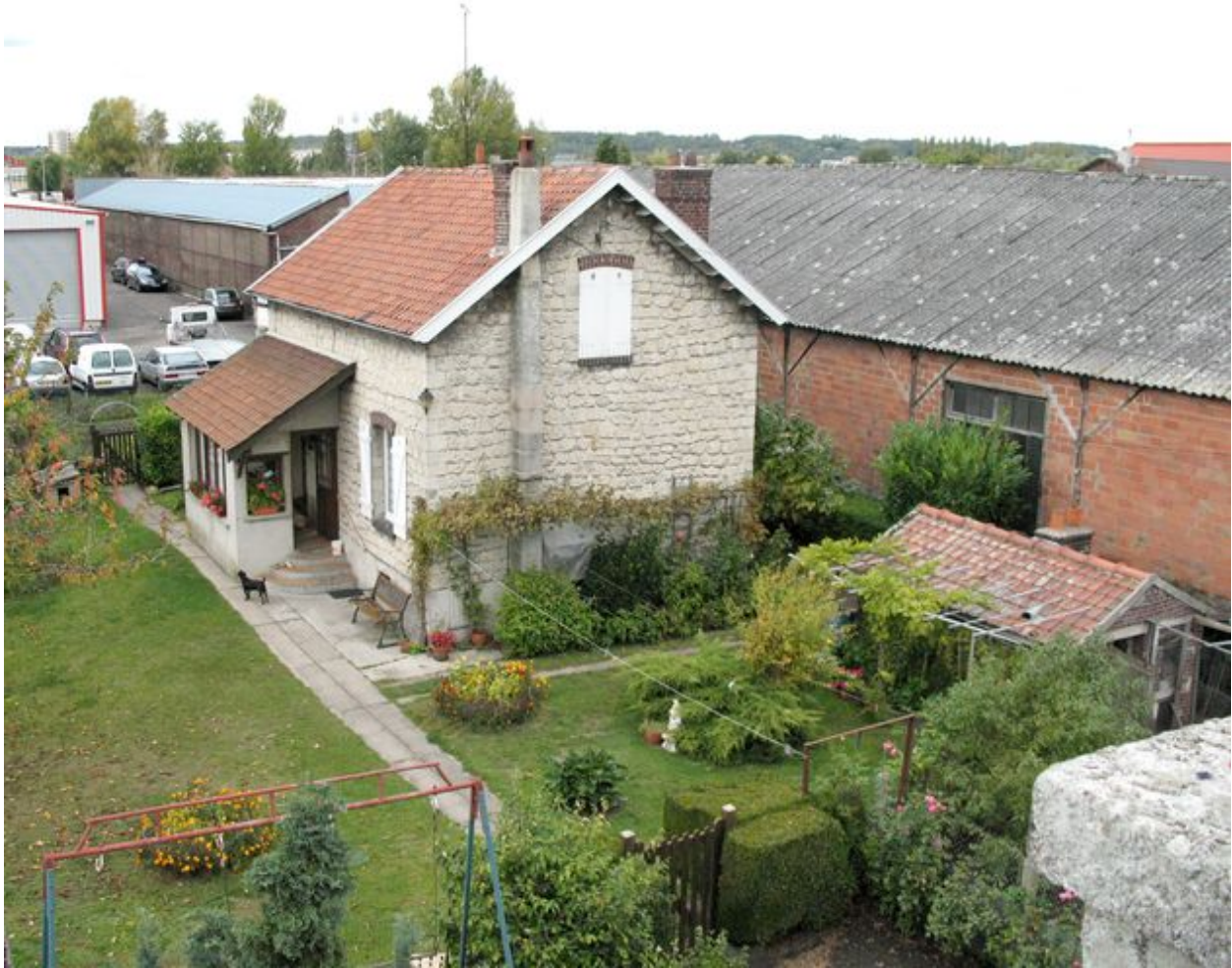
Le logement du chauffeur mécanicien et le poulailler depuis le toit de la station de pompage.
