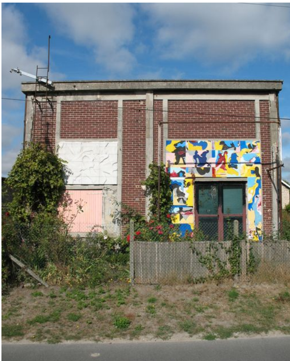
Mur pignon sud de la station de pompage.
