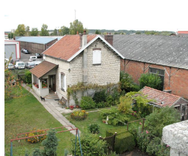
Le logement du chauffeur mécanicien et le poulailler depuis le toit de la station de pompage.
