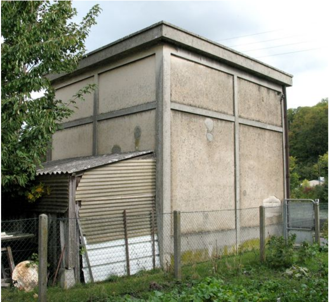
Le transformateur électrique vu vers l'Oise.
