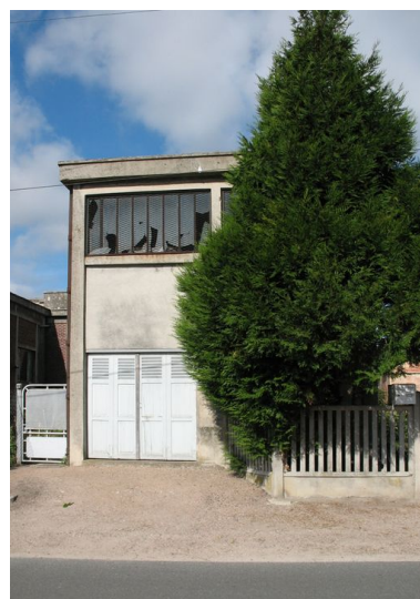
Transformateur électrique de la station de pompage.
