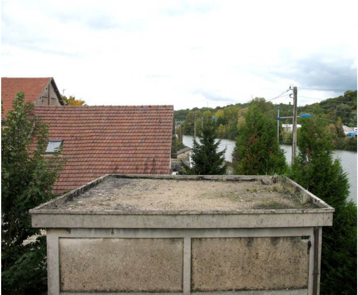
Toit terrasse du transformateur.
