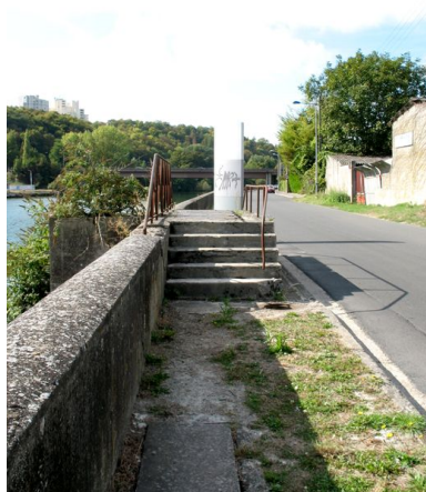
Escalier et garde-corps conduisant à la prise d'eau dans l'Oise.
