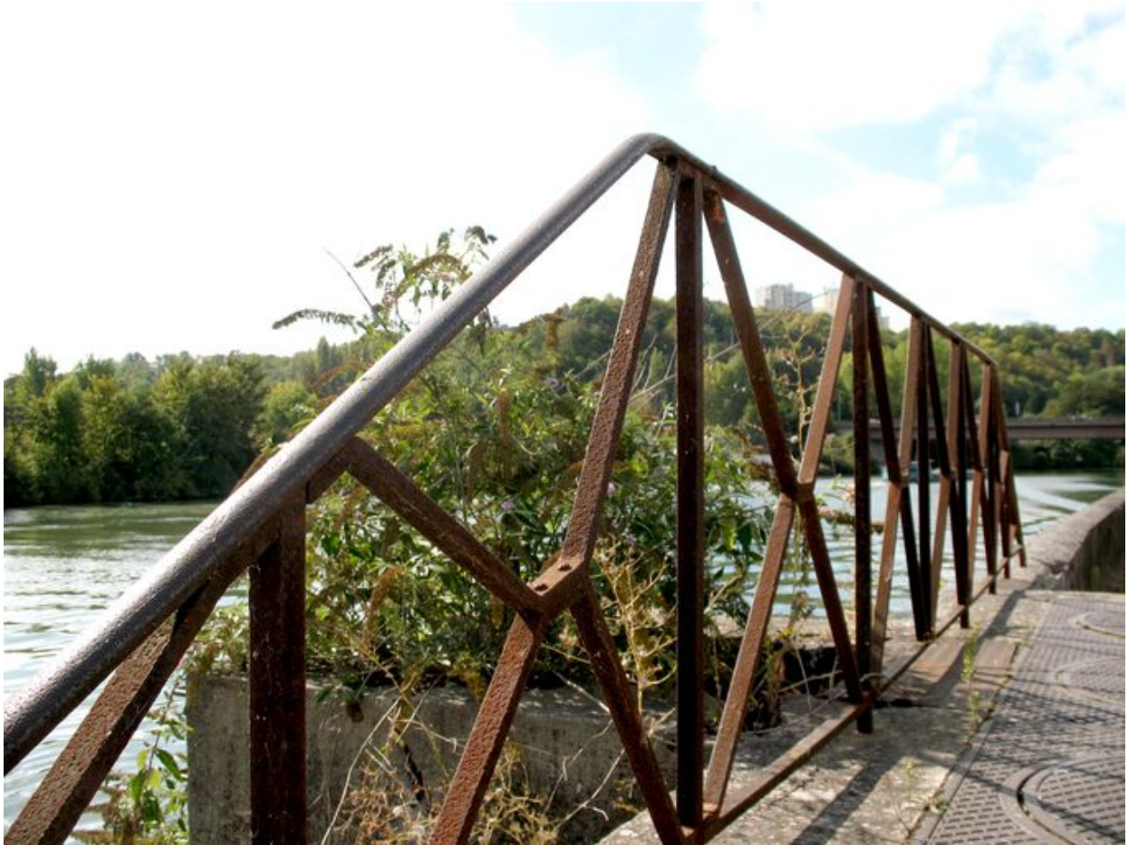
Détail du garde-corpe en fonte.
