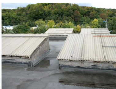
Toit et surtoits de la station de pompage.
