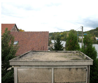
Toit terrasse du transformateur.
