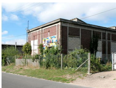
Vue générale de la station de pompage depuis le quai d'Amont. Phot. Clarisse Lorieux IVR22_20096005170NUCA
