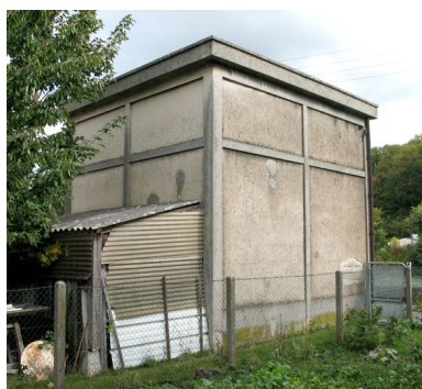
Le transformateur électrique vu vers l'Oise.
