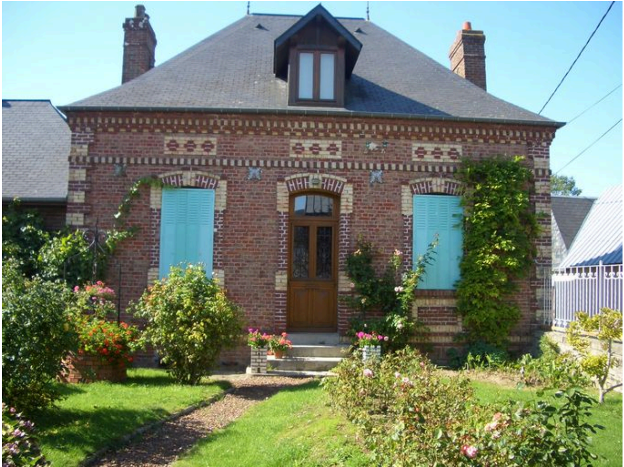
Vue du logis principal.
