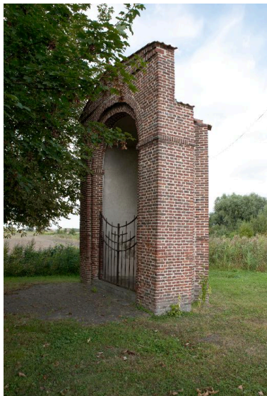
Vue générale de trois quarts. Phot. Pierre Thibaut IVR31_20125902187NUCA
