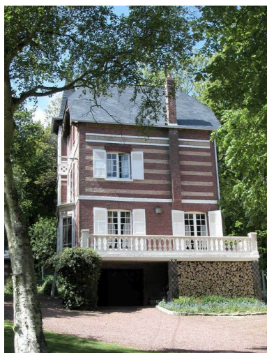
Vue d'ensemble depuis la rue. Phot. Elisabeth Justome IVR22_20058003030NUCA
