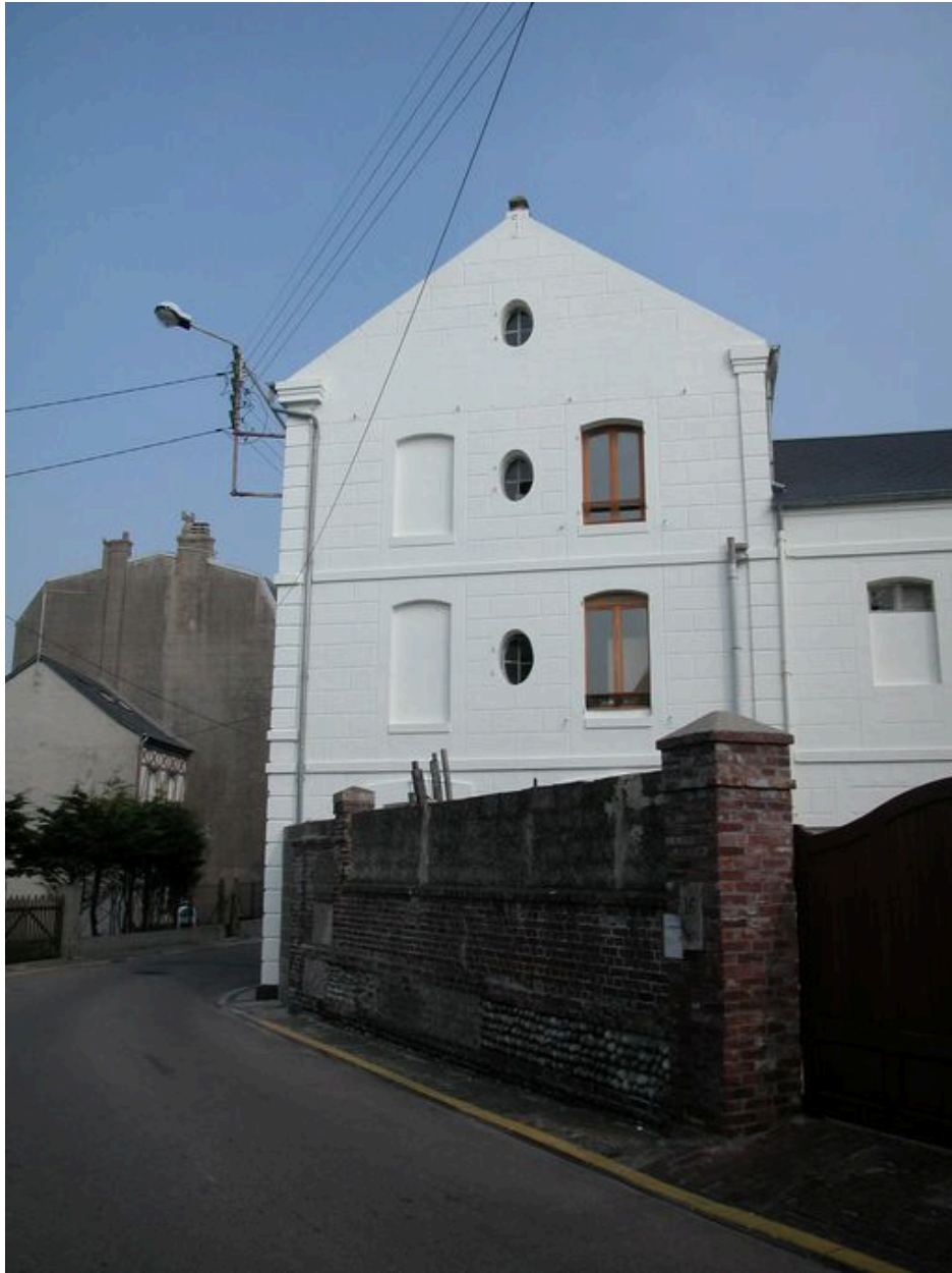
Vue de la façade latérale droite.
