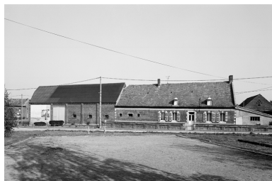
Vue de la façade du logis (construit en 1813), et du bâtiment abritant l'étable et la grange. Phot. Thierry Lefébure IVR22_19930200442V
