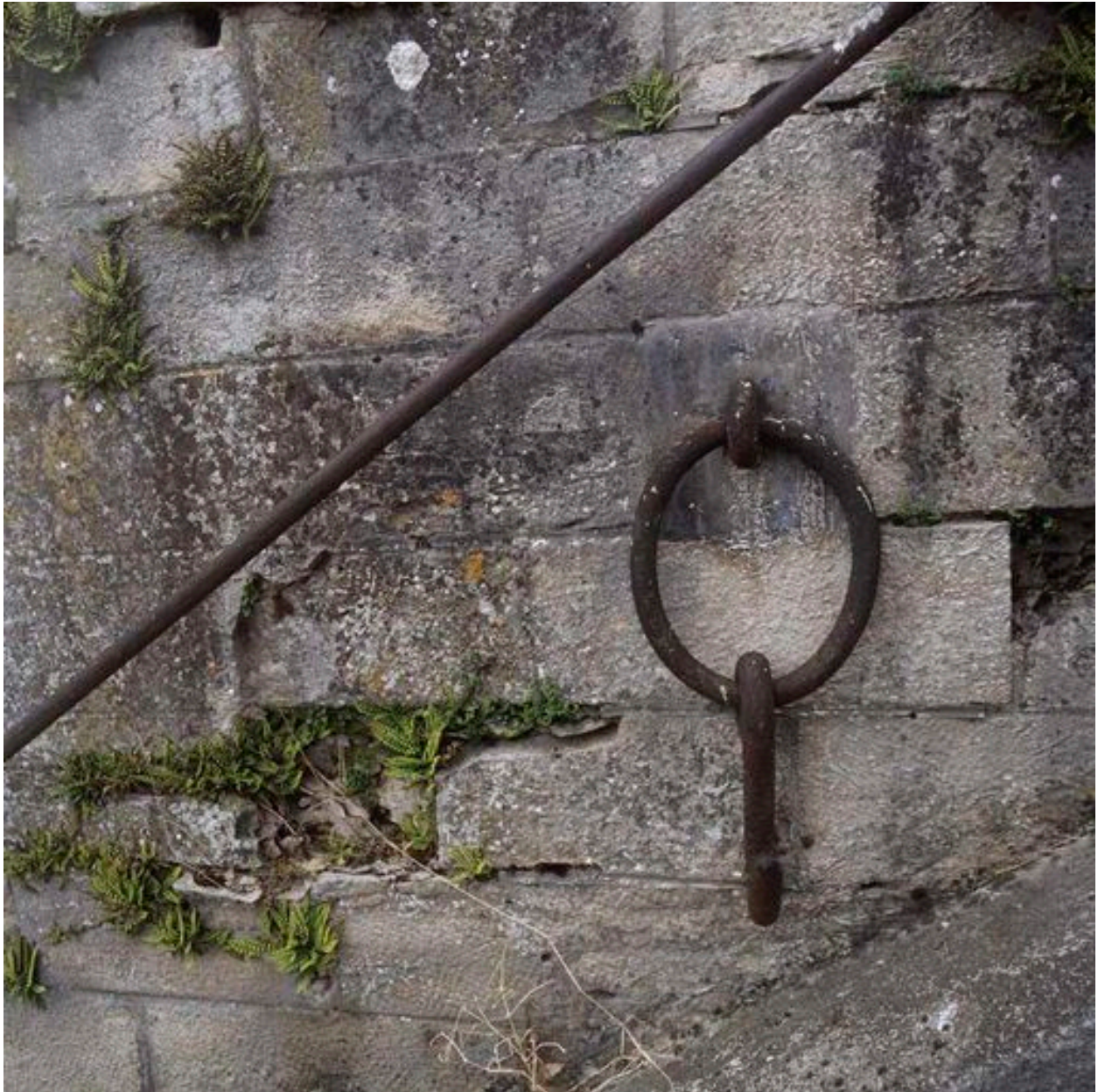
Creil : anneaux d'amarrage.
