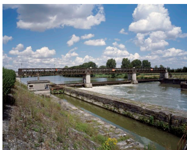
Sarron : vue générale du barrage Derôme construit en 1891 et de l'écluse (désaffectée). Phot. Thierry Lefébure IVR22_20076000142VA
