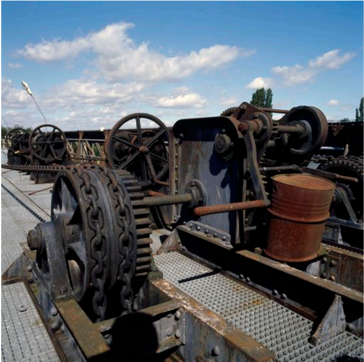
Sarron : détail du treuil de relevage.
