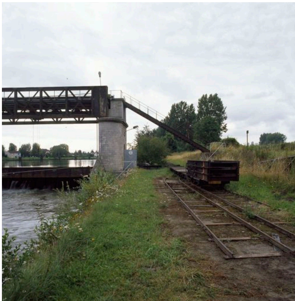
Sarron : passerelle métallique descendant du pont supérieur et voie Decauville.
