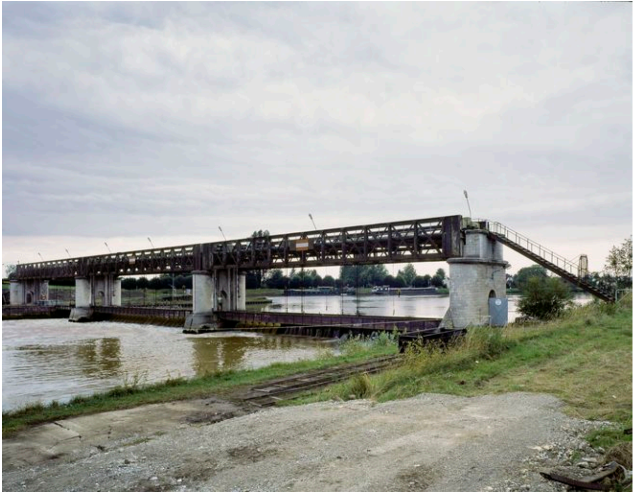
Sarron : le barrage en amont.
