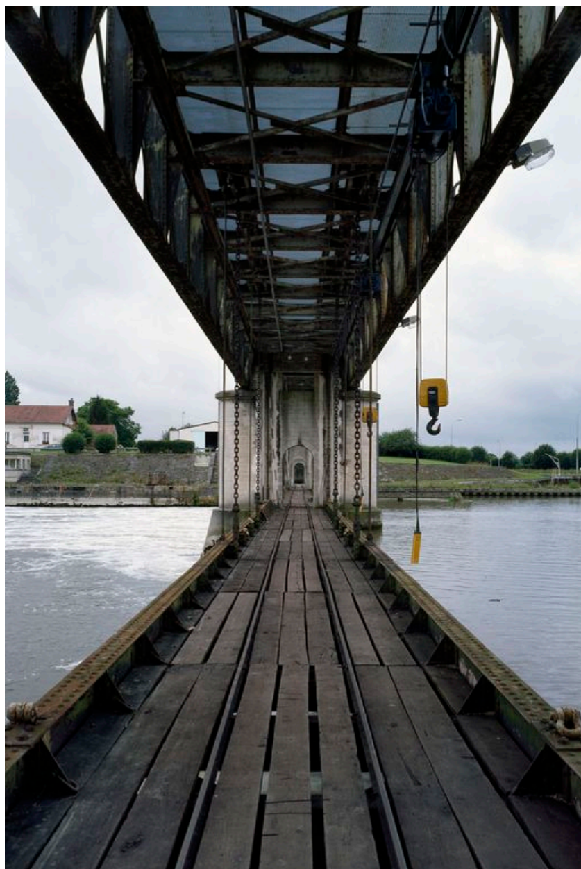
Sarron : passerelle mobile et voie Decauville.
