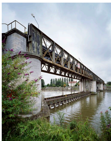
Sarron : détail du barrage Derôme. Phot. Thierry Lefébure IVR22_20076000144VA
