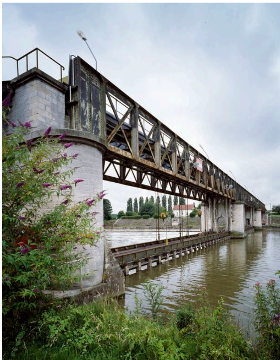
Sarron : détail du barrage Derôme.
