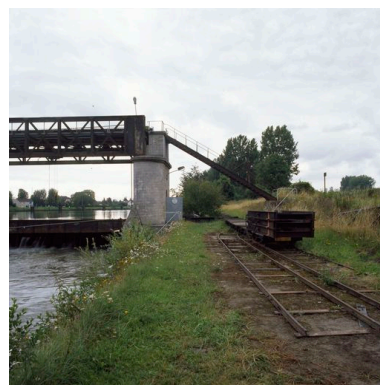
Sarron : passerelle métallique descendant du pont supérieur et voie Decauville. Phot. Thierry Lefébure IVR22_20076000158XA
