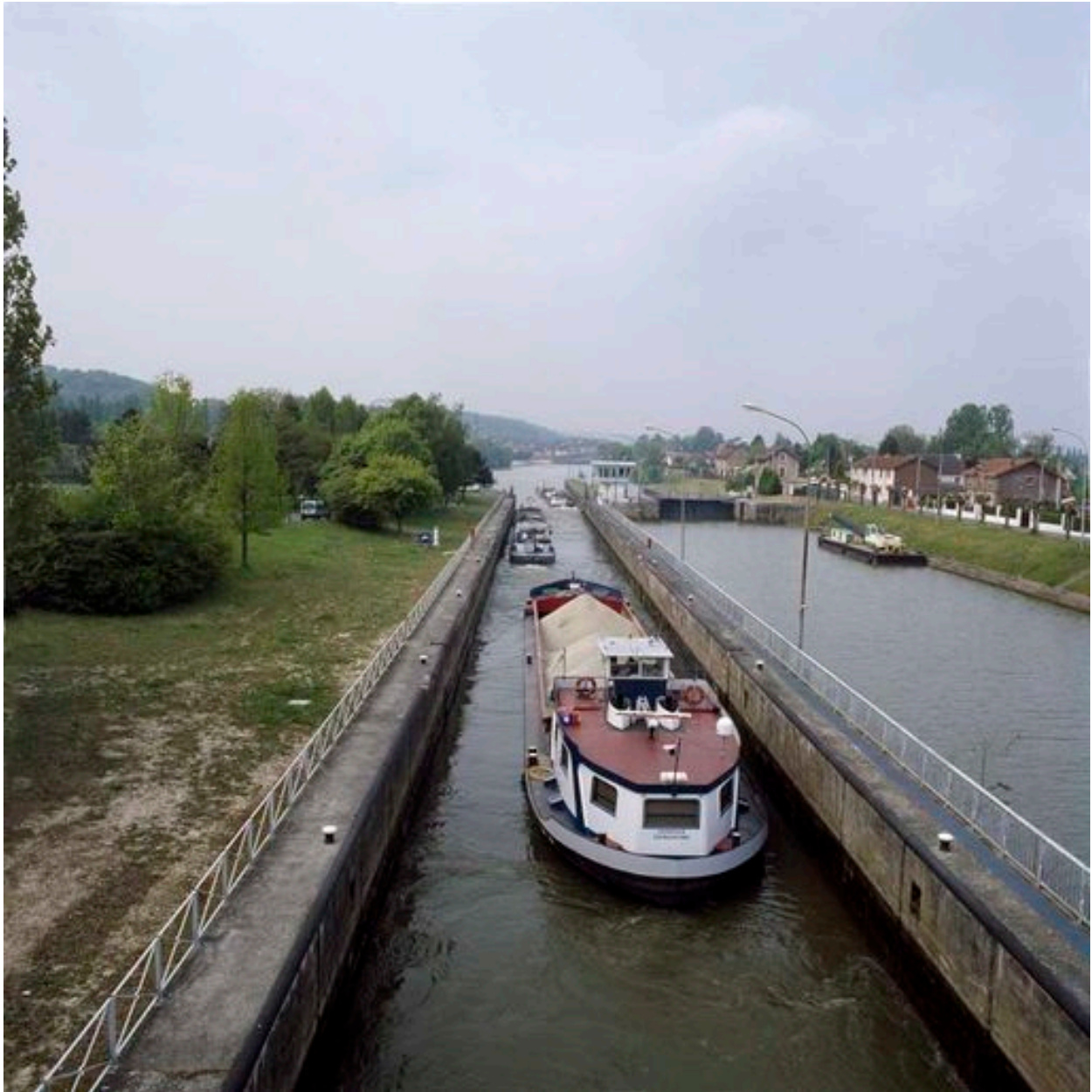
Sarron : passage de la nouvelle écluse.
