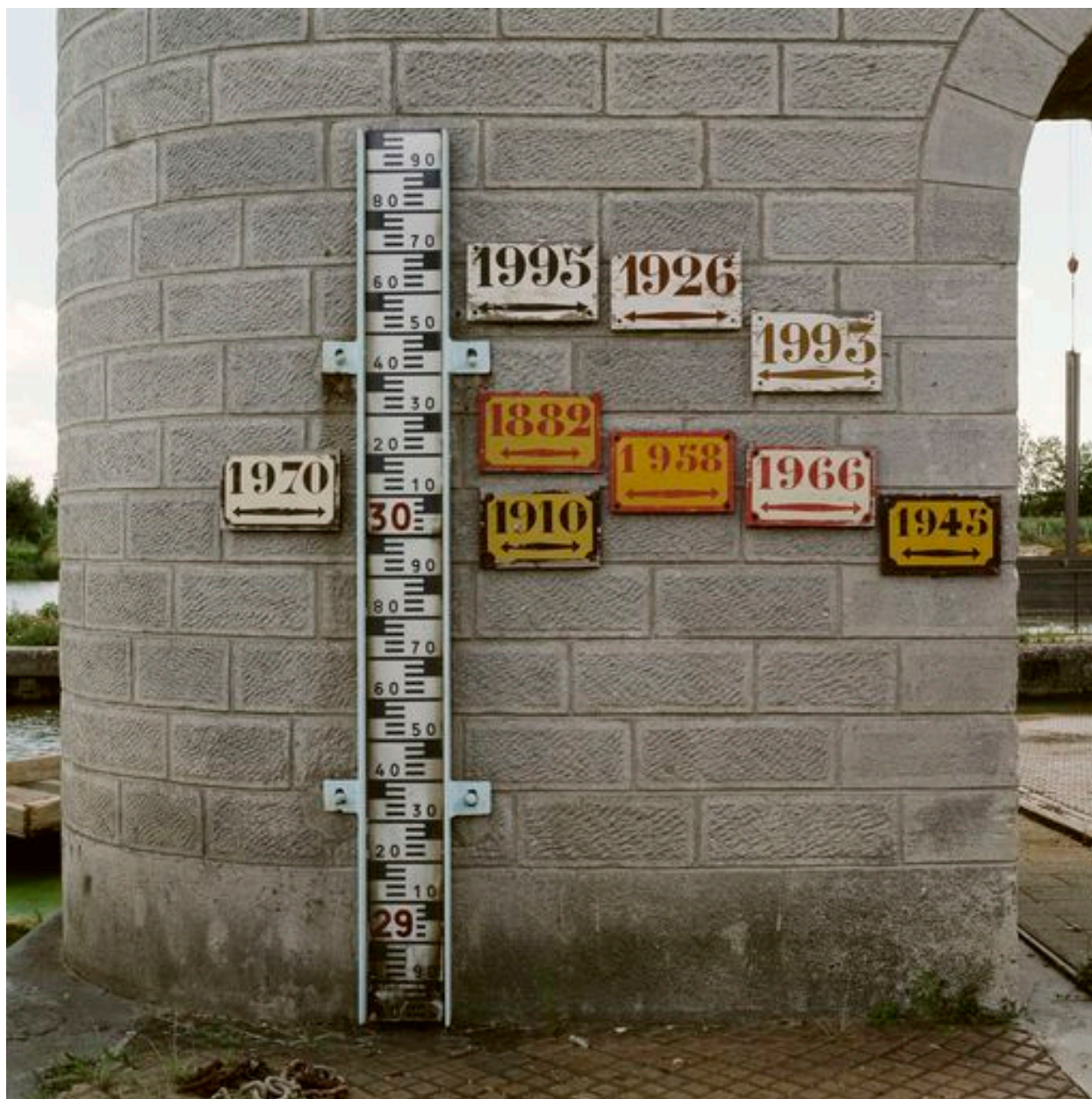
Sarron : niveaux de crues sur l'un des piliers du barrage.
