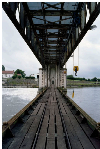
Sarron : passerelle mobile et voie Decauville. Phot. Thierry Lefébure IVR22_20076000155VA
