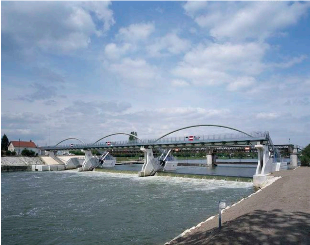
Creil : barrage à clapets.
