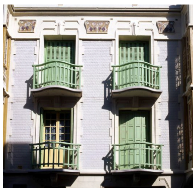
Détail des travées situées entre les oriels. Phot. Marie-Laure Monnehay-Vulliet IVR22_20048000359XA
