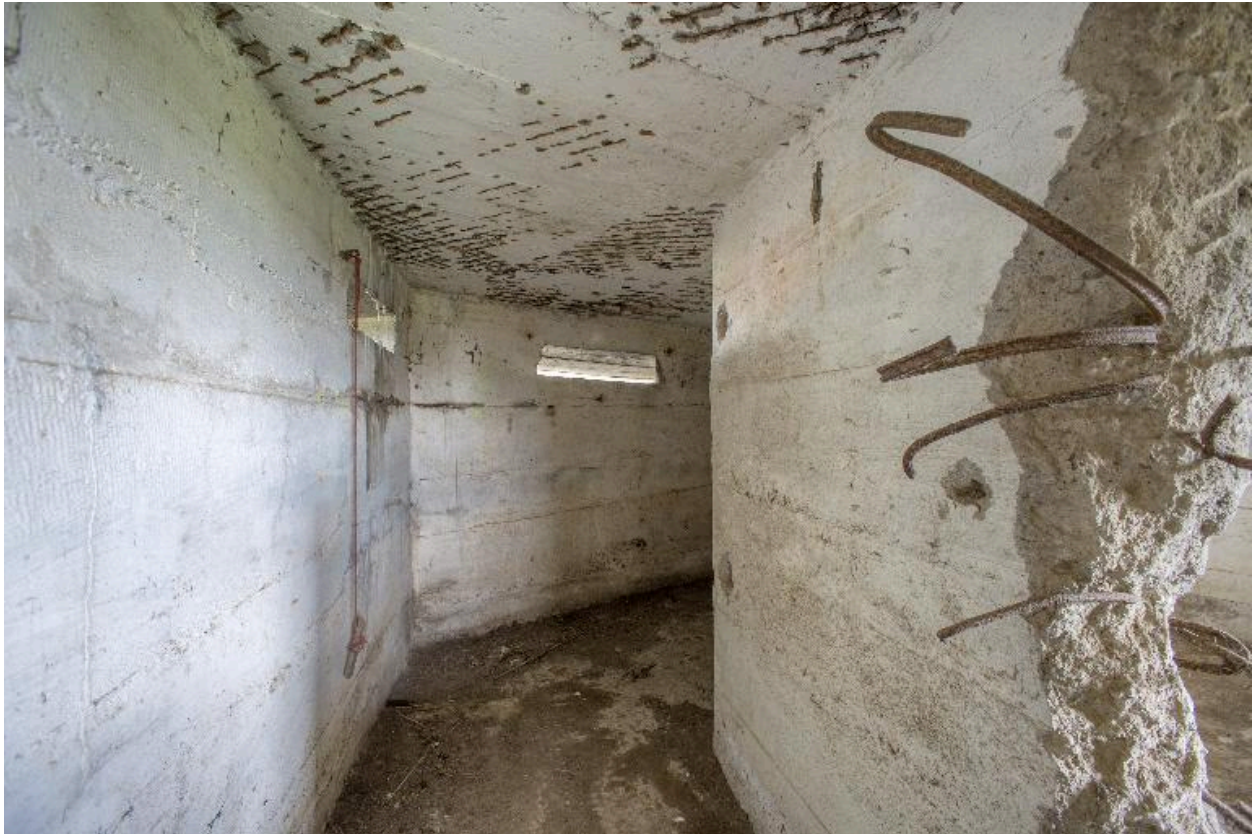
Premier étage, coursière de tir, vers l'ouest, au grand-angulaire.
