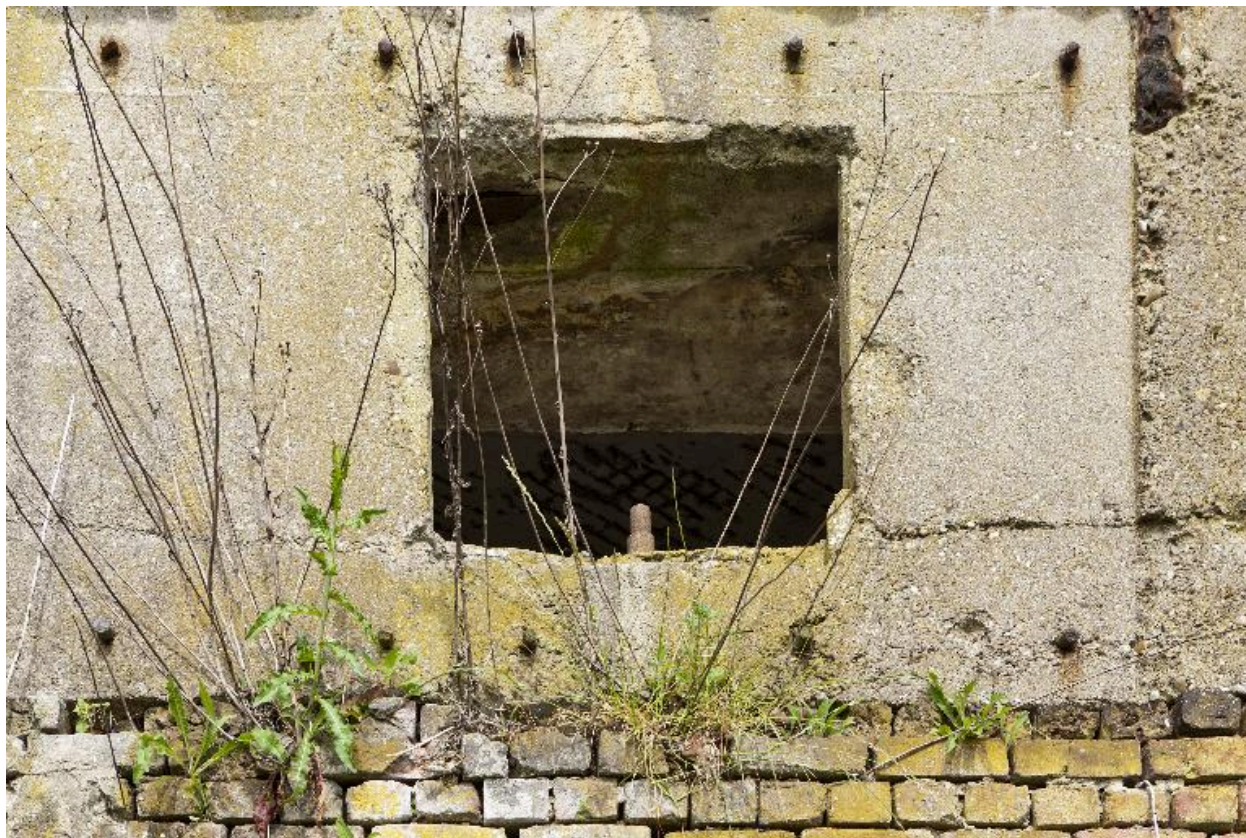
Elévation postérieure, détail d'une position de tir
