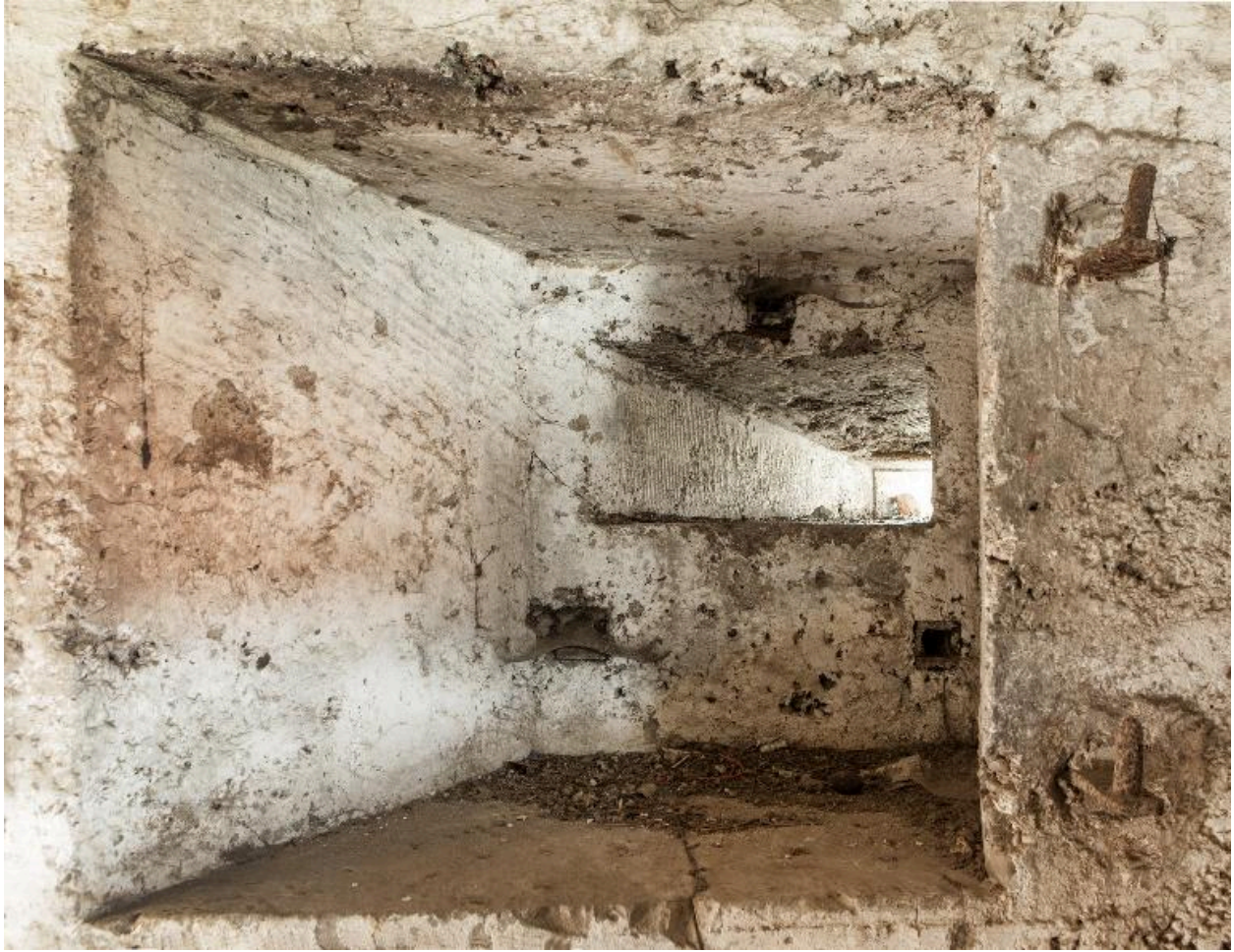
Rez-de-Chaussée. Créneau de fusillade protégeant l'entrée
