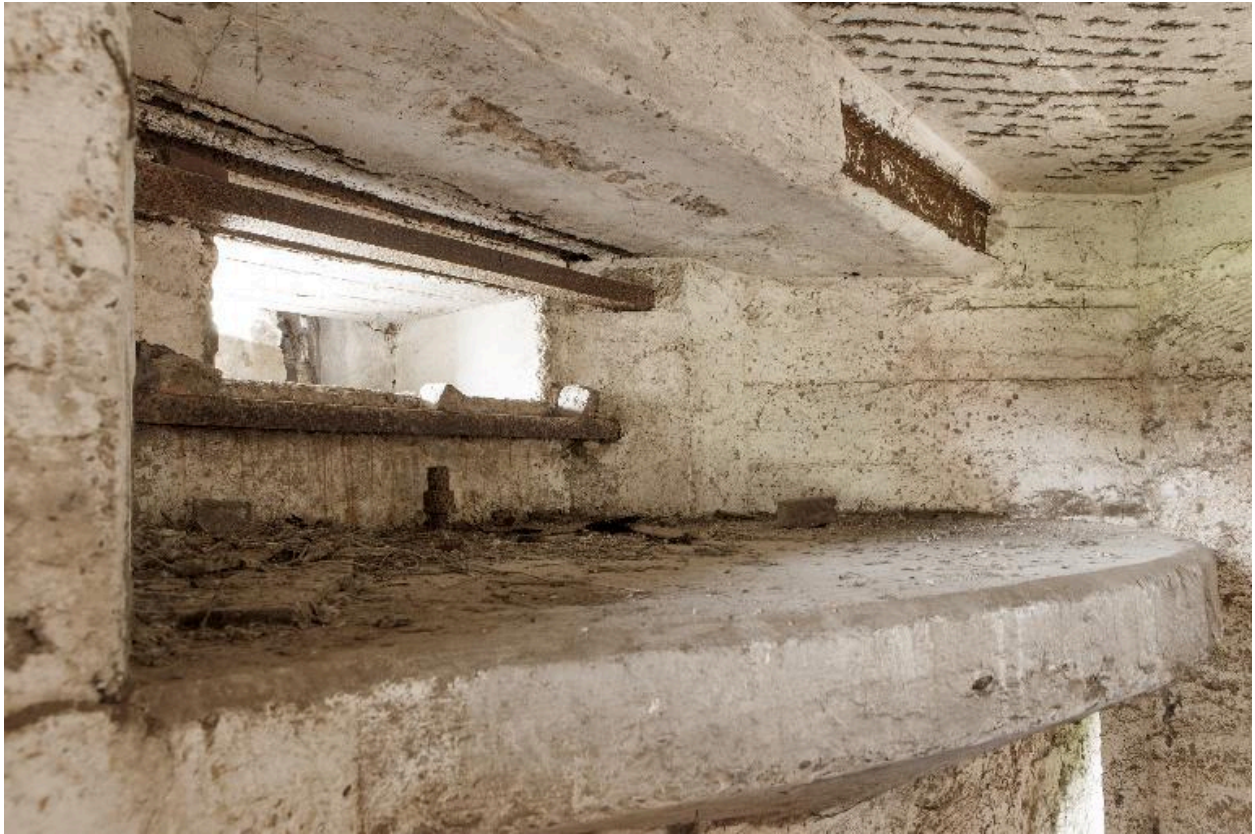
Rez-de-chaussée, appui pour mitrailleuse et embrasure de tir ouest
