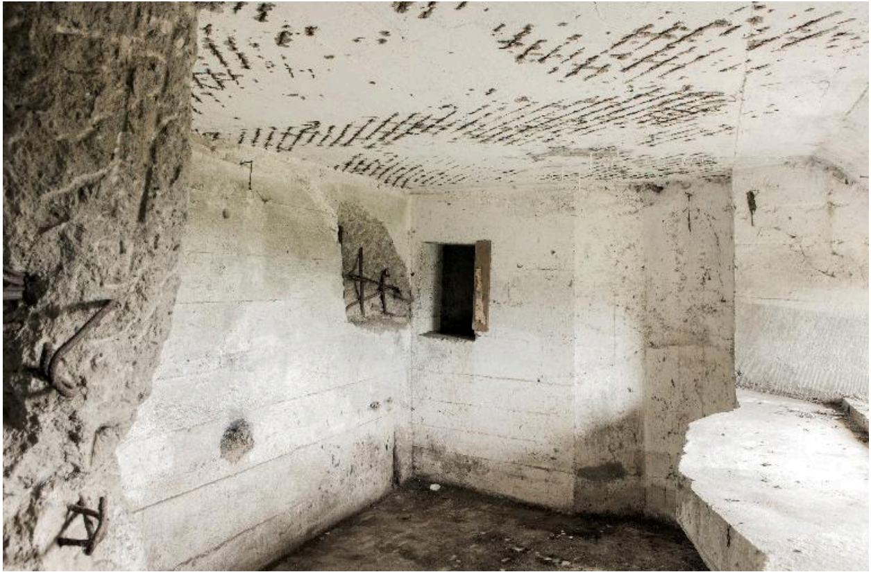
Premier étage, vue au grand-angle. A droite, appui pour mitrailleuse est
