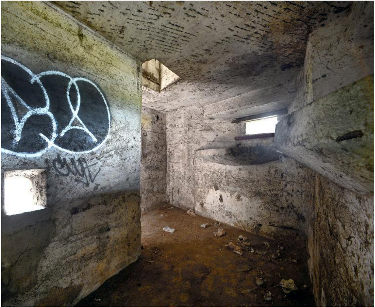
Rez-de-chaussée, vers le sud, au grand-angulaire. Au fond, l'appui pour mitrailleuse et l'embrasure de tir sud, à gauche, un créneau de fusillade couvrant le couloir d'entrée.
