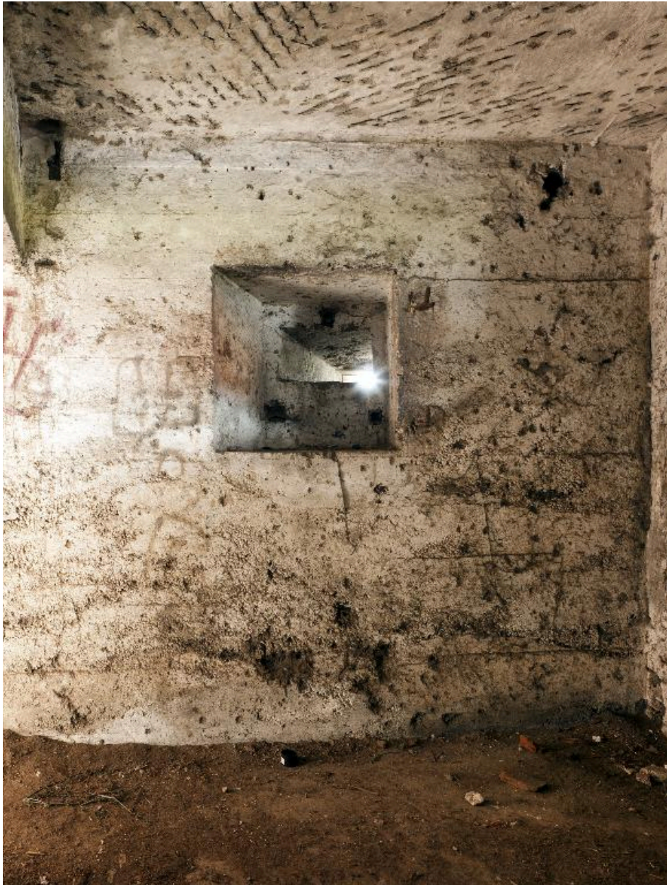
Rez-de-chaussée, de gauche à droite : Créneau de fusillade assurant les abords est de l'édifice.
