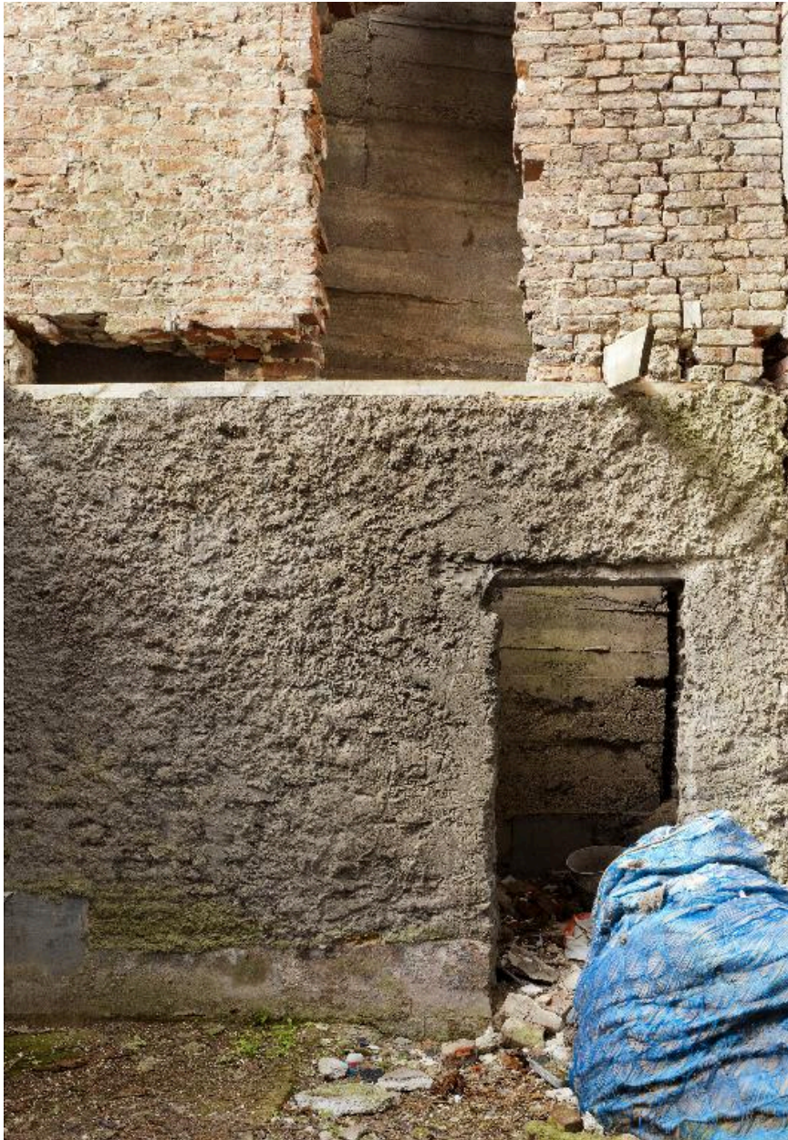
Elévation nord de l'abri, depuis l'intérieur de la maison voisine. On peut constater qu'il ne s'adosse pas au mur mitoyen.
