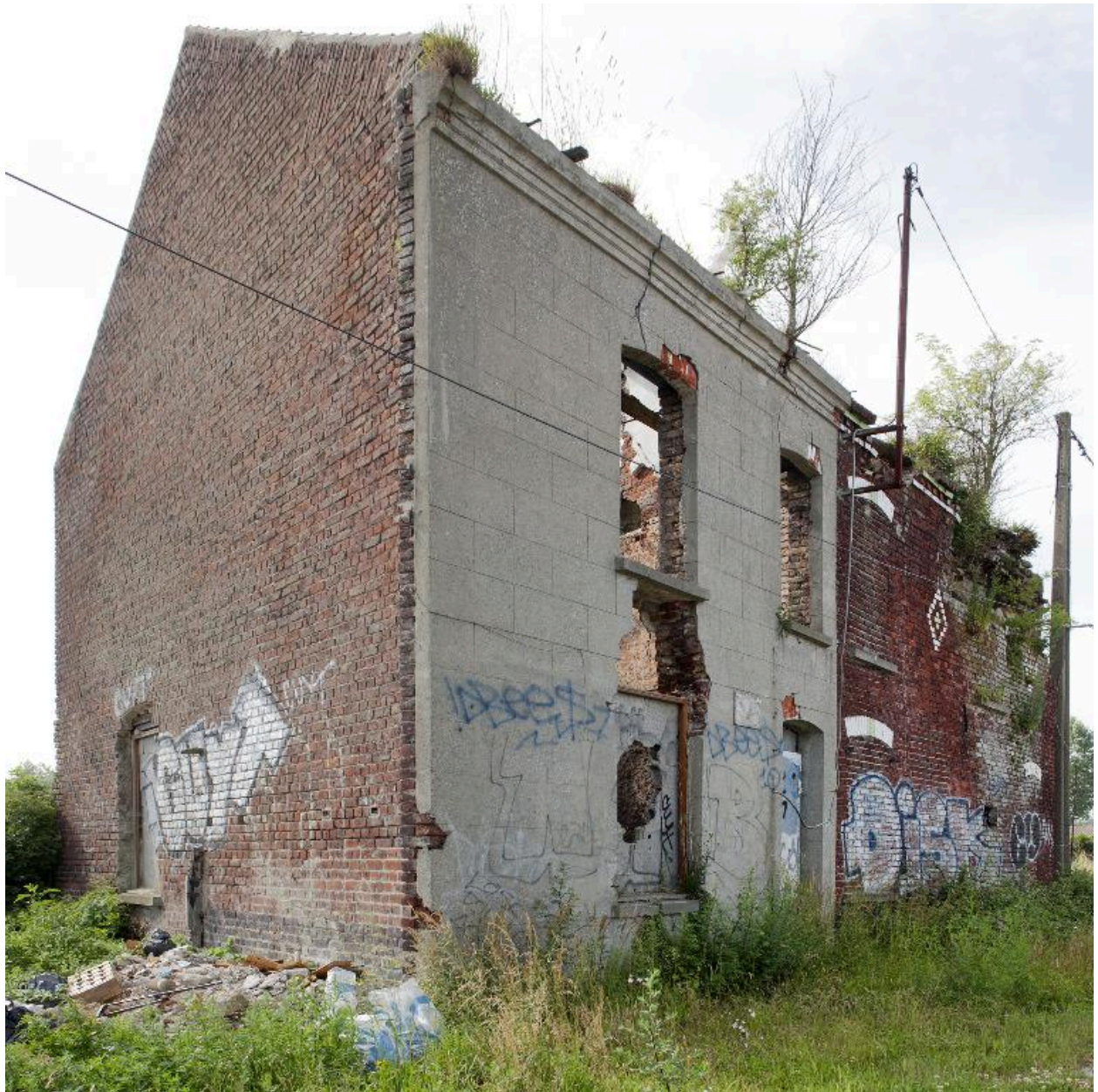
Vue générale vers le sud-ouest depuis la rue de Santes
