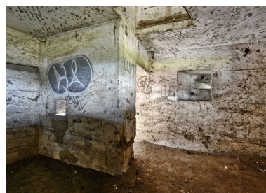
Rez-de-chaussée, de gauche à droite : Créneau de fusillade protégeant l'entrée en chicane, ouverture donnant accès à l'étage, couloir d'entrée et créneau de fusillage assurant les abords est de l'édifice. Phot. Jean-Marc Ramette IVR31_20145904848NUCA
