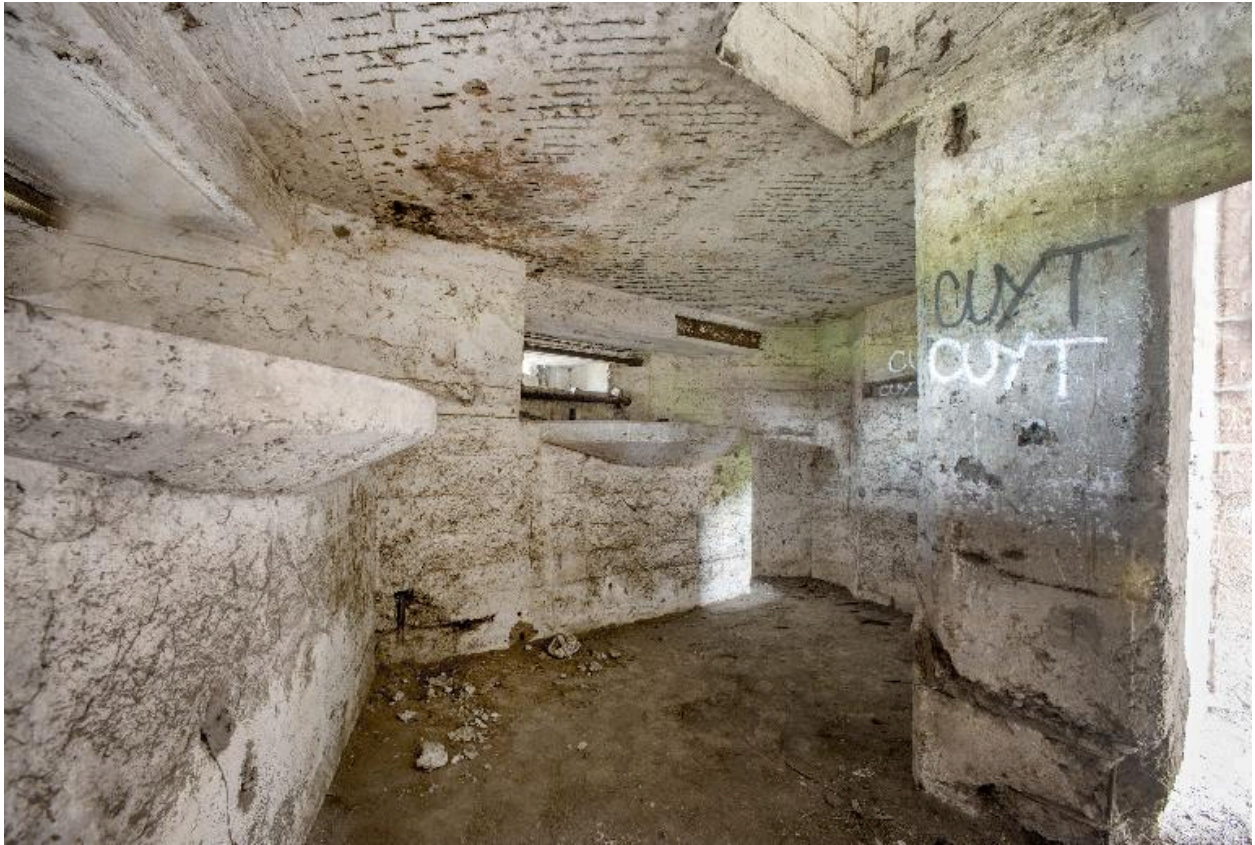
Vue générale du rez-de-chaussée (au grand-angulaire)
