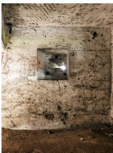
Rez-de-chaussée, de gauche à droite : Créneau de fusillade assurant les abords est de l'édifice. Phot. Jean-Marc Ramette IVR31_20145904834NUCA
