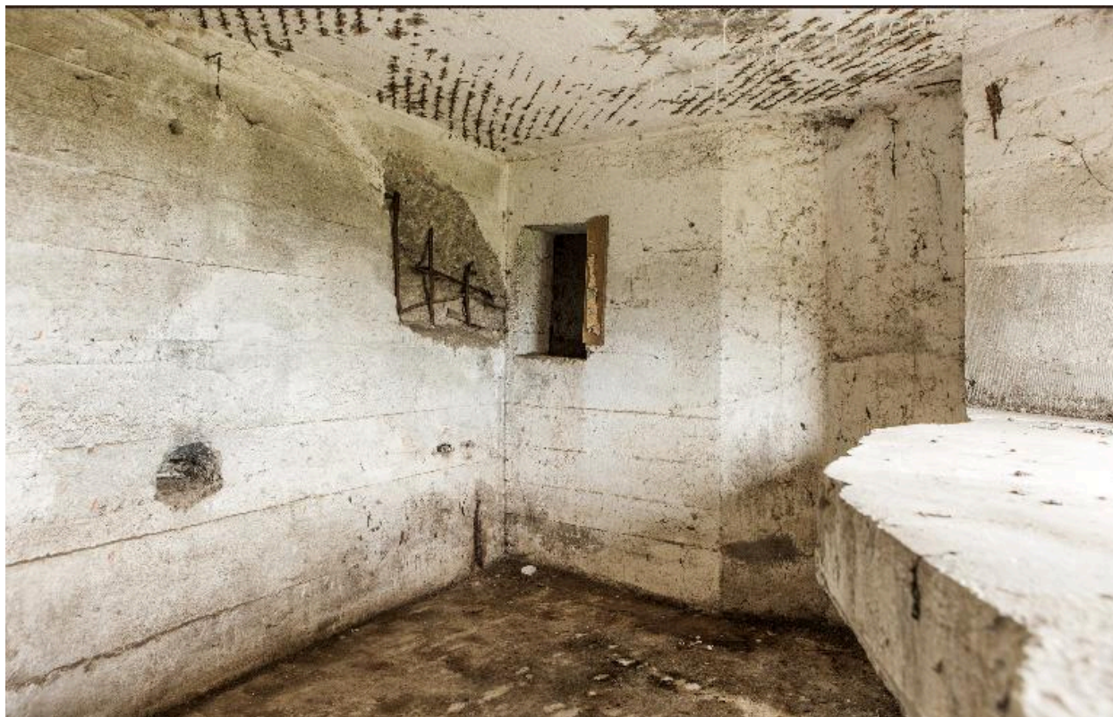
Premier étage, vue au grand-angle. A droite, appui pour mitrailleuse est
