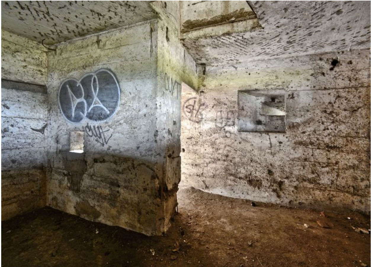
Rez-de-chaussée, de gauche à droite : Créneau de fusillade protégeant l'entrée en chicane, ouverture donnant accès à l'étage, couloir d'entrée et créneau de fusillage assurant les abords est de l'édifice.
