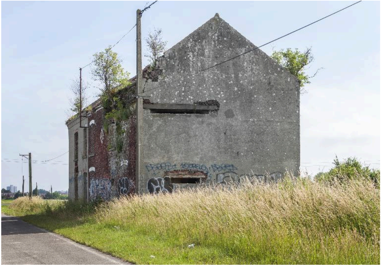
Vue générale vers le nord-est depuis la rue de Santes
