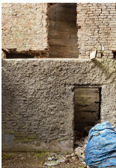
Elévation nord de l'abri, depuis l'intérieur de la maison voisine. On peut constater qu'il ne s'adosse pas au mur mitoyen. Phot. Jean-Marc Ramette IVR31_20145904838NUCA
