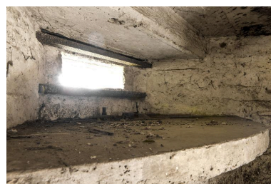
Rez-de-chaussée, appui pour mitrailleuse et embrasure de tir sud. Phot. Jean-Marc Ramette IVR31_20145904839NUCA
