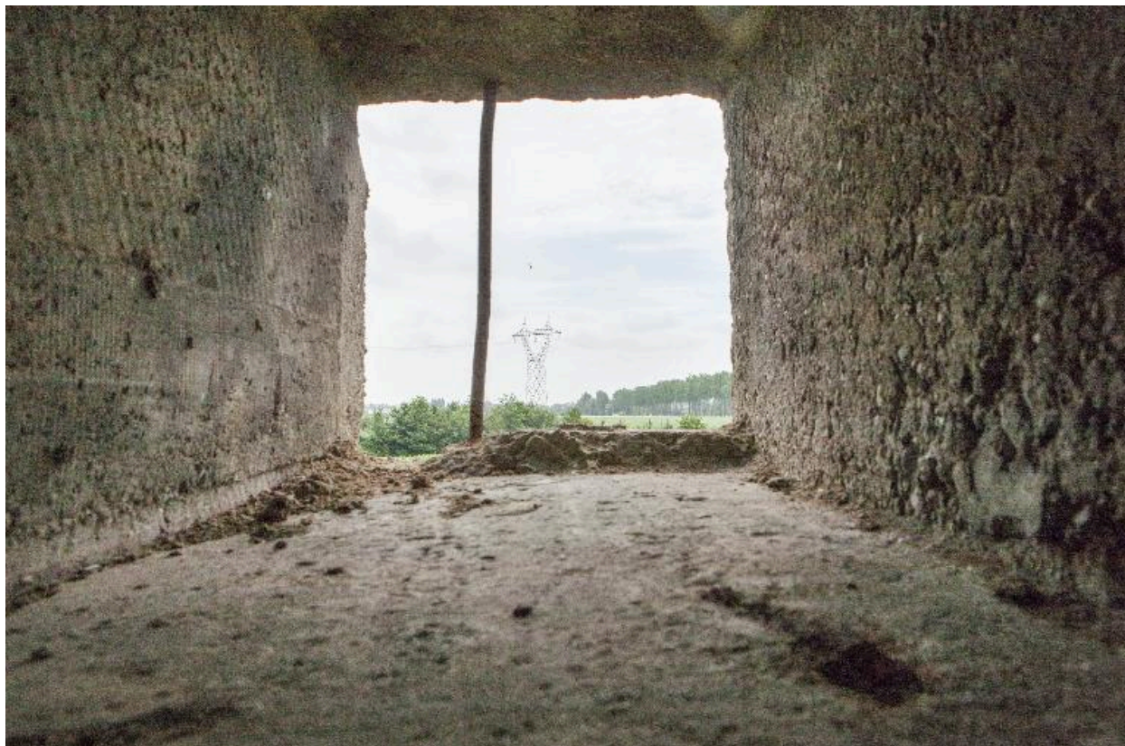
Premier étage, créneau de fusillade vers l'est
