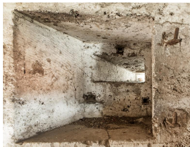
Rez-de-Chaussée. Créneau de fusillade protégeant l'entrée Phot. Jean-Marc Ramette IVR31_20145904840NUCA
