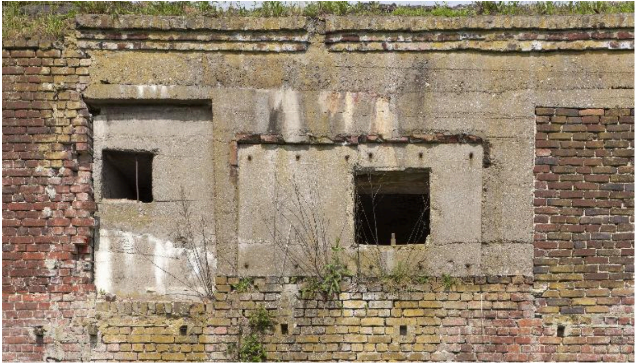
Elévation postérieure, détail des ouvertures de tir
