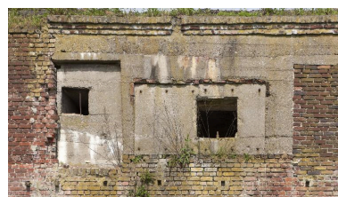
Elévation postérieure, détail des ouvertures de tir Phot. Jean-Marc Ramette IVR31_20145904830NUCA
