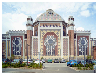
Vue d'ensemble sud. Phot. Pierre Thibaut IVR32_20215900095NUCA
