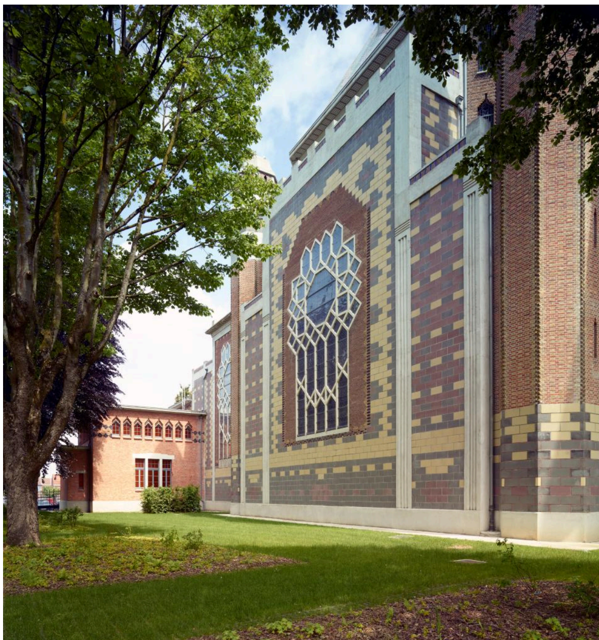
Façade nord, depuis l'angle nord-ouest.
