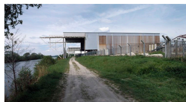
Quai de déchargement depuis le chemin de halage au bord de l'Oise. Phot. Thierry Lefébure IVR22_20106000513NUCA
