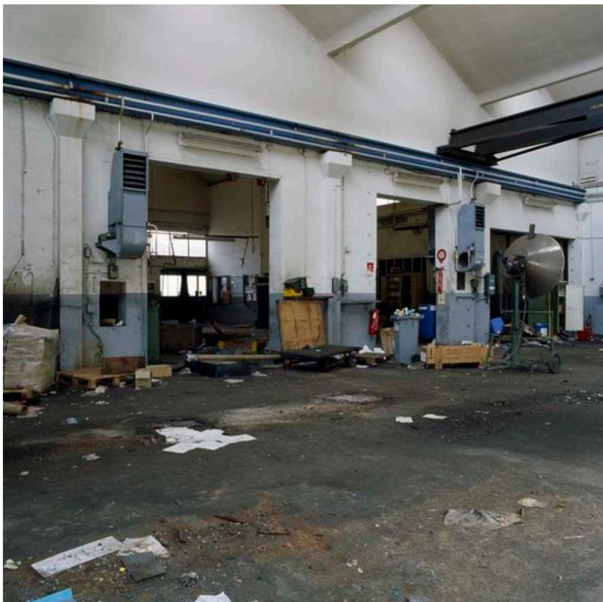
Anciens ateliers de maintenance.
