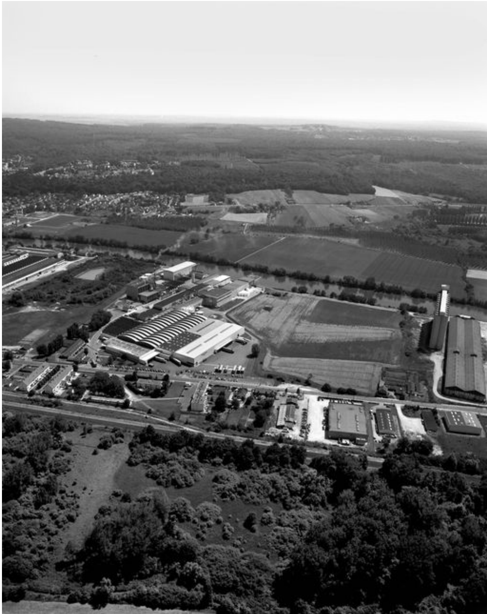
Vue aérienne de la papeterie vers le sud, 1995.
