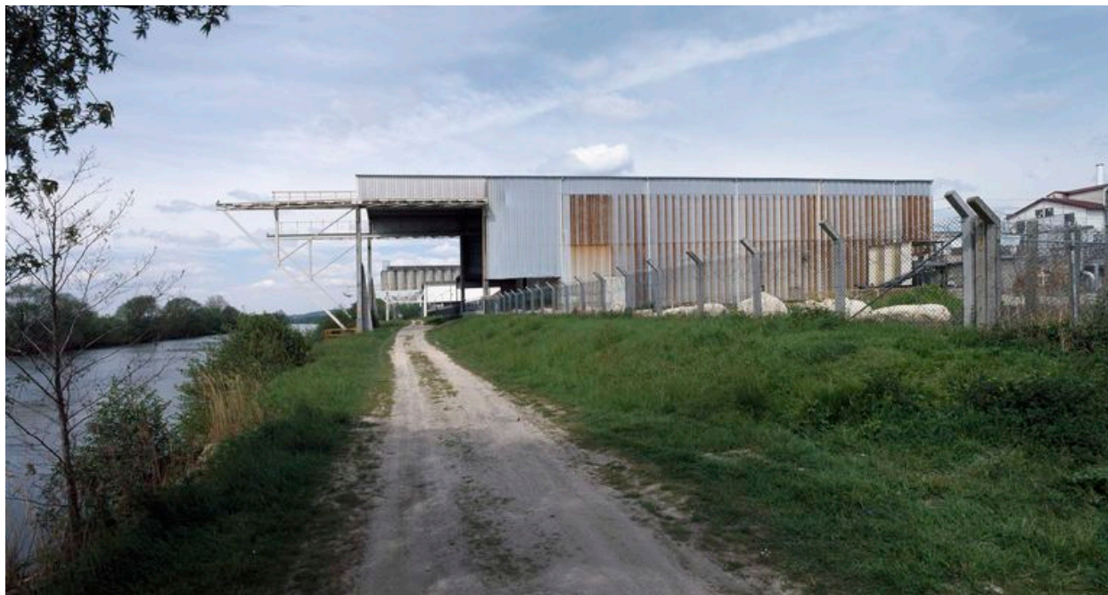
Quai de déchargement depuis le chemin de halage au bord de l'Oise.
