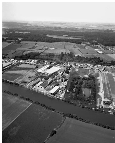
Vue aérienne de la papeterie vers le nord, 1995. Phot. Sanson Aviation IVR22_19956000881XA
