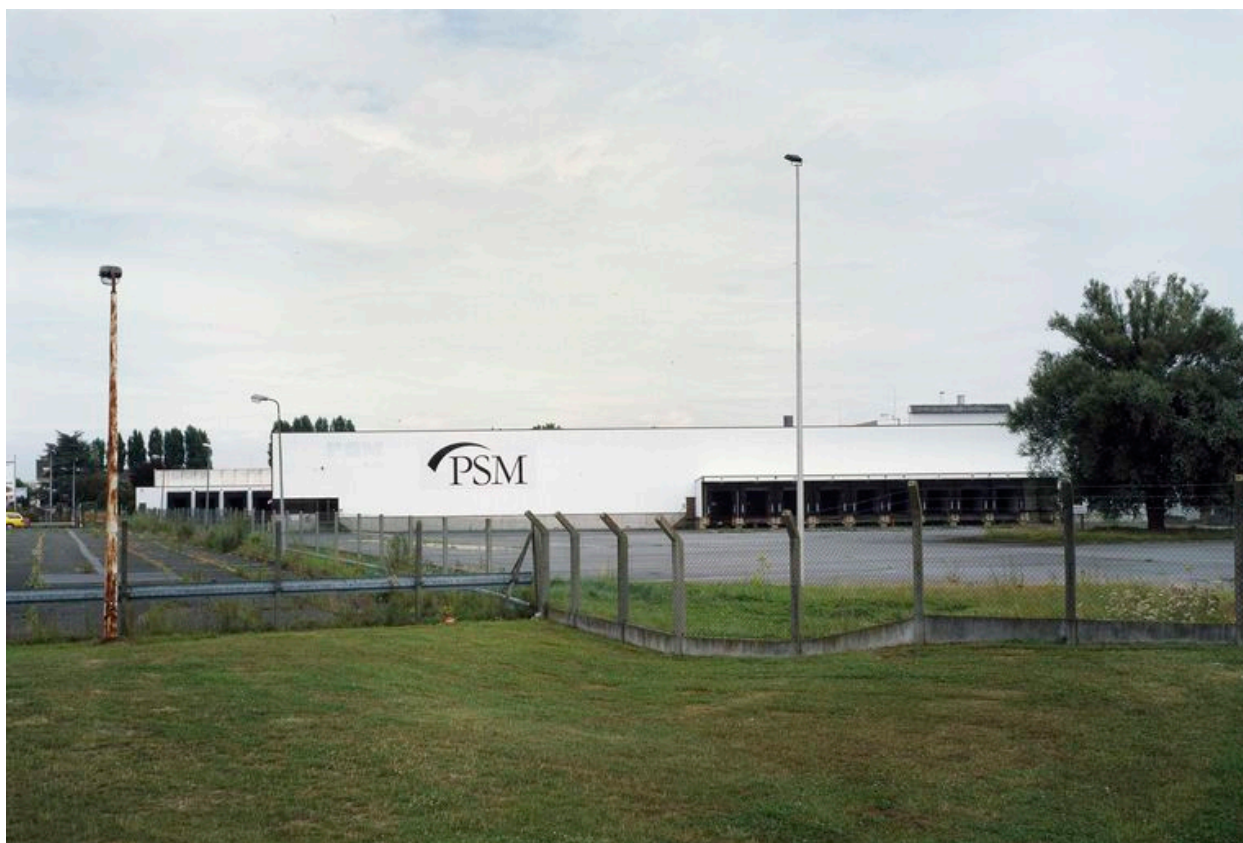
Vue générale du site de la papeterie.
