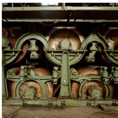
Détail des cylindres de la machine à papier Fourdrinier. Phot. Thierry Lefébure IVR22_20106000605XA
