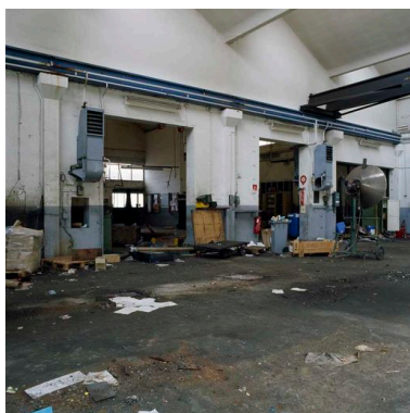
Anciens ateliers de maintenance. Phot. Thierry Lefébure IVR22_20106000868XA
