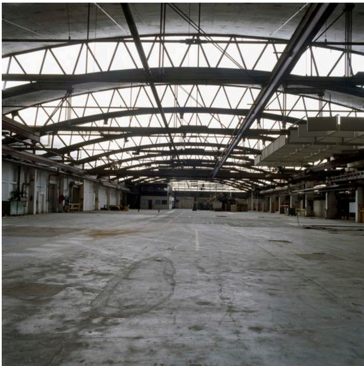
Intérieur de la salle d'apprêt et de finition qui abritait les machines à couper, à emballer et à emballer.
