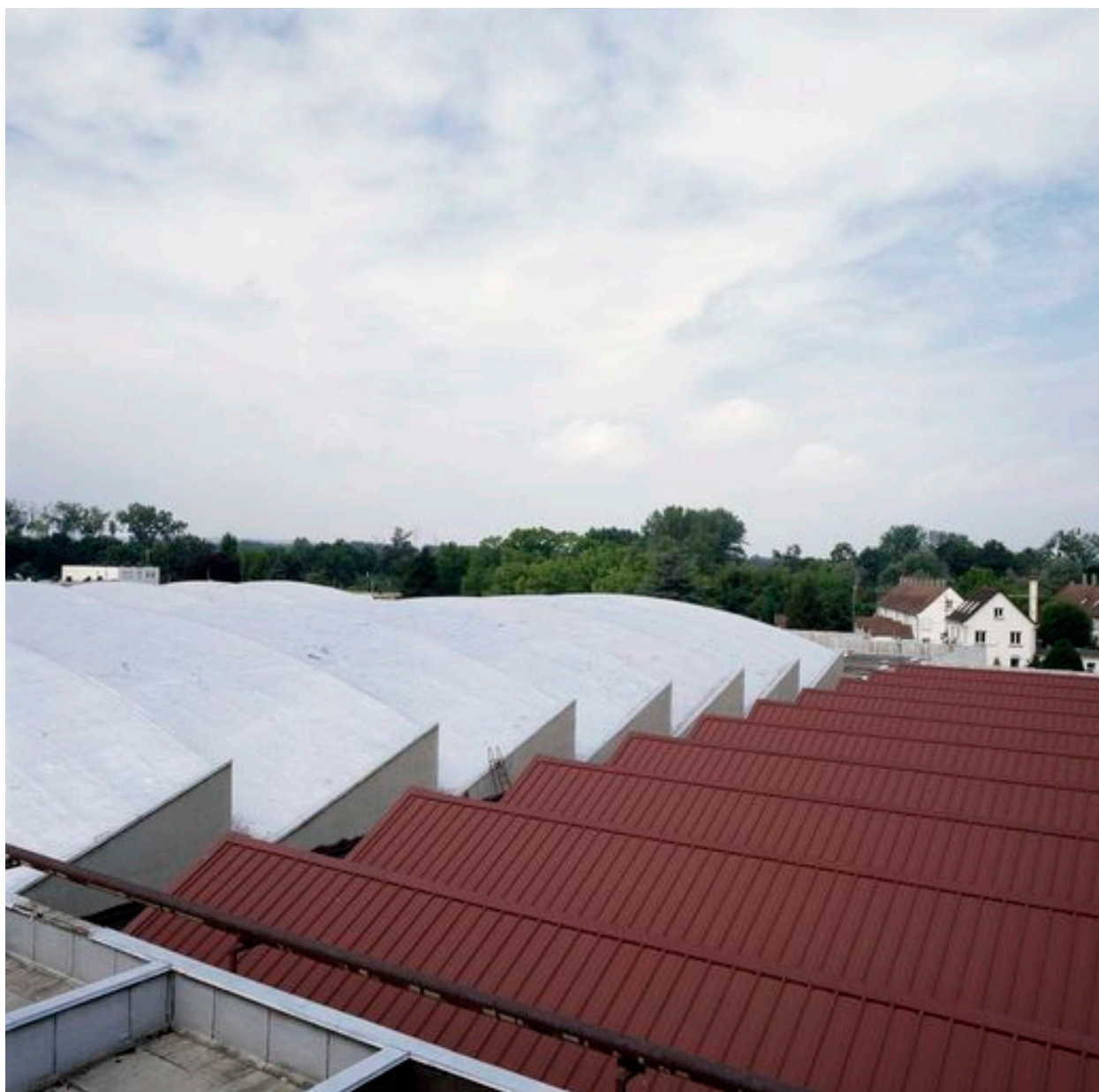
Détail de la toiture de la salle d'apprêt.
