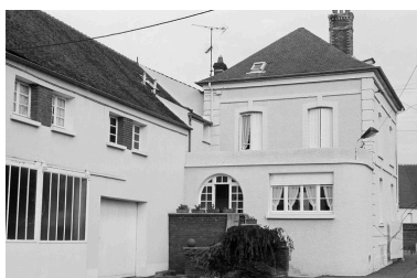
Logement patronal : façade postérieure. Phot. Patrick Glotain IVR22_19996001460Z
