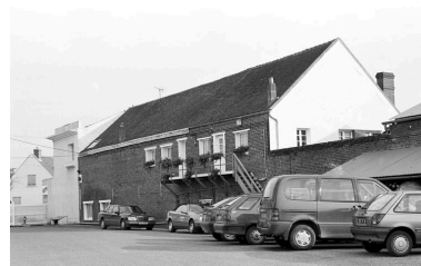
Façade nord de l'ancienne conciergerie, convertie en atelier de réparation et logement d'ouvriers. Phot. Patrick Glotain IVR22_19996001464Z
