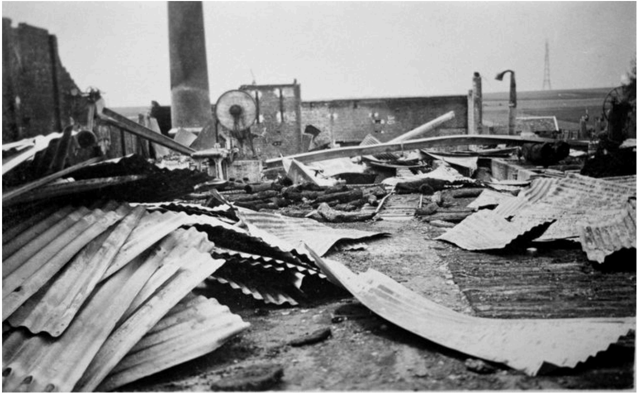
Etat des destructions après l'incendie de 1942 (AP).
