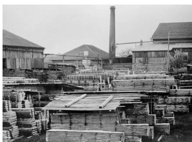
Aire de stockage des produits semi-finis avec la chaufferie et la cheminée d'usine à l'arrière-plan, vers 1930 (AP). Phot. Bertrand Fournier IVR22_19996001458ZB
