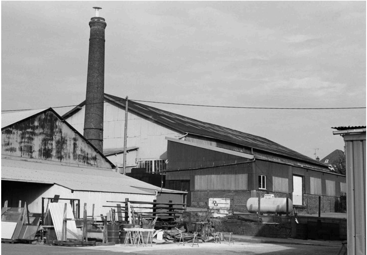
Ateliers et cheminée d'usine.
