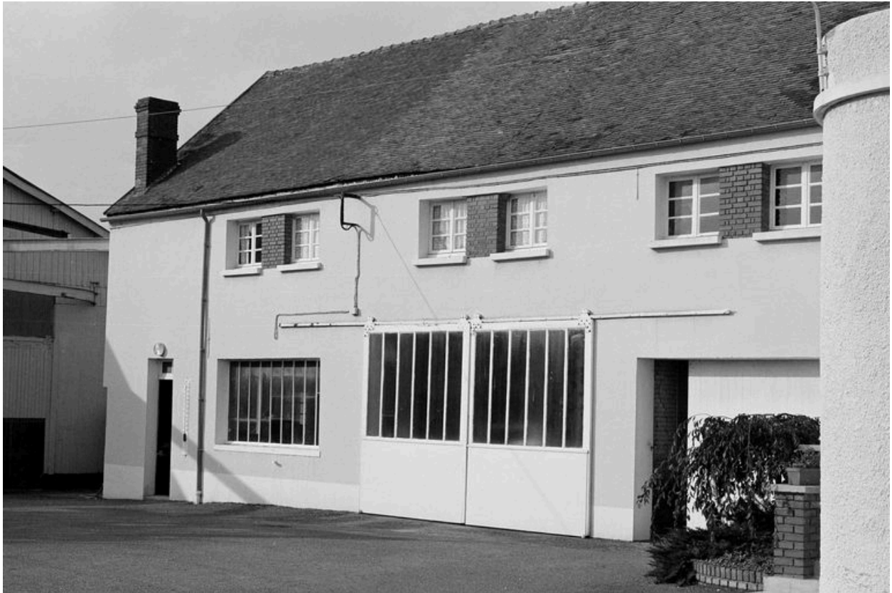
Ancienne conciergerie convertie en atelier de réparation et logements d'ouvriers à l'étage.
