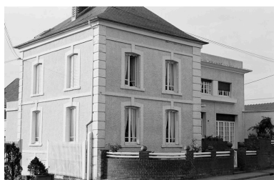
Logement patronal : façade sur rue. Phot. Bertrand Fournier IVR22_19996001462Z
