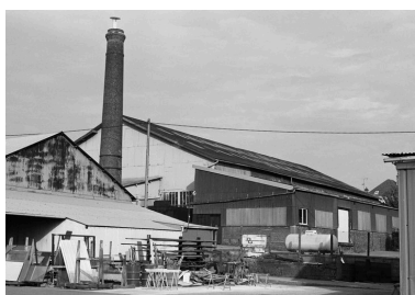
Ateliers et cheminée d'usine. Phot. Patrick Glotain IVR22_19996001465Z
