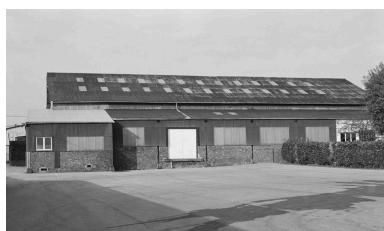
Atelier principal de sciage : façade longitudinale sud. Phot. Bertrand Fournier IVR22_19996001467Z
