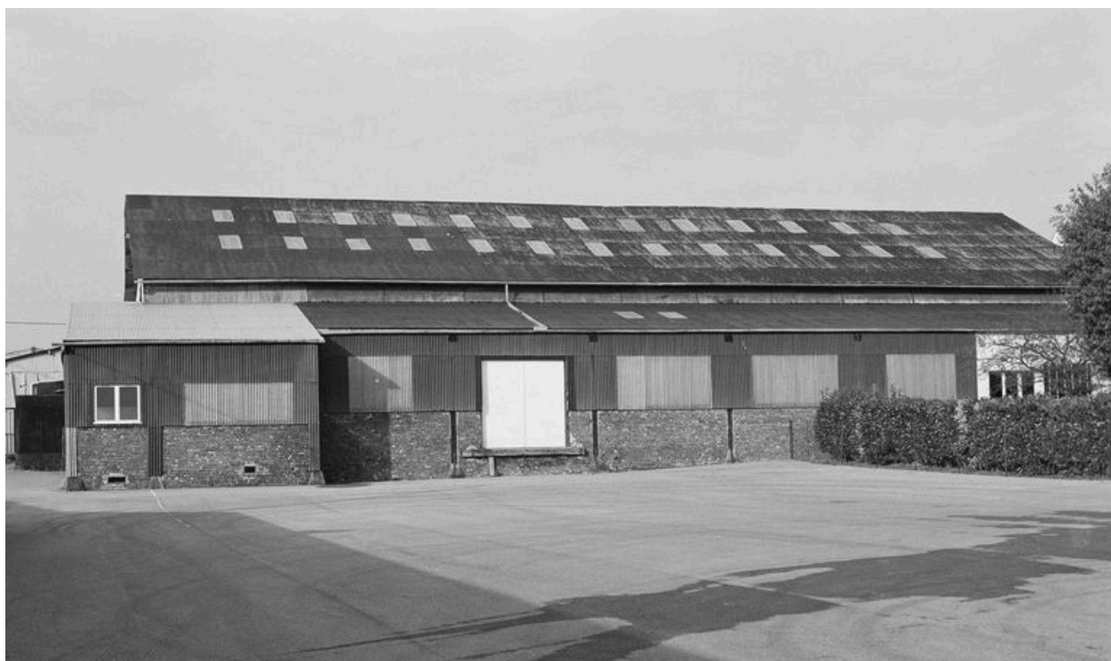
Atelier principal de sciage : façade longitudinale sud.
