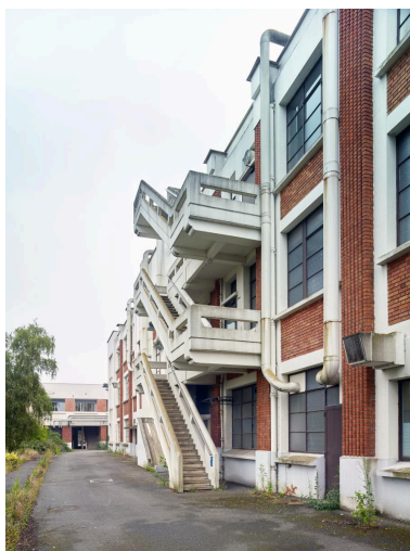
Elévation nord de l'atelier de fabrication (G), vers l'est. Phot. Pierre Thibaut IVR32_20225900652NUCA
