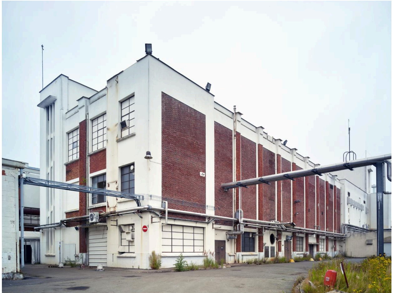
Vue de trois-quarts vers nord-est de l'atelier de fabrication (H).
