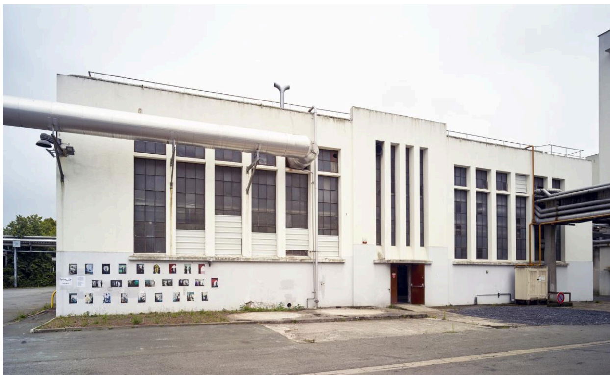
La chaufferie (A), élévation nord.
