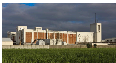
Ateliers de fabrication (H) vers le nord-est depuis le chemin de Molpas. Phot. Hubert Bouvet IVR31_20125900259NUC4A
