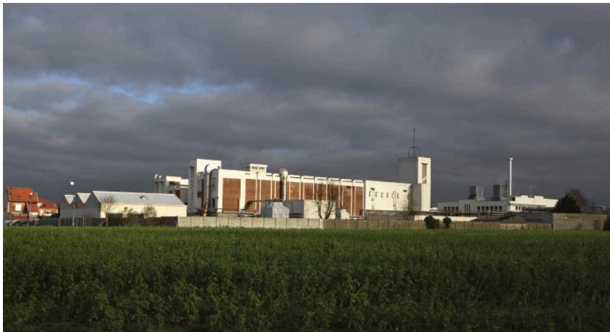
Vue générale vers le nord-est depuis le chemin de Molpas.
