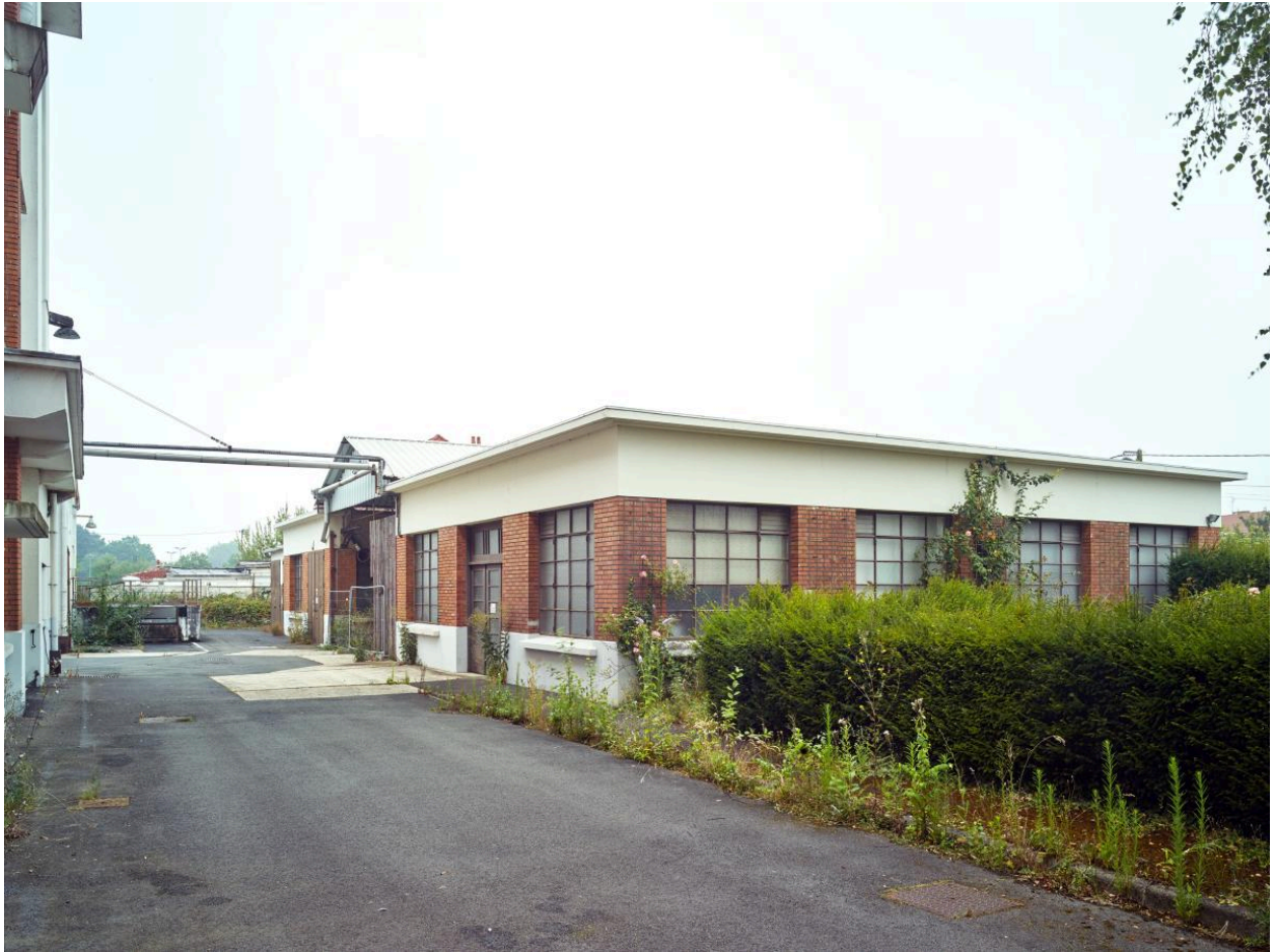
Vue vers l'ouest de la menuiserie (F, L, I)
