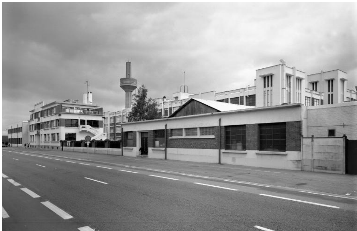
Elévation rue du Général De Gaulle, vers le sud-est.
