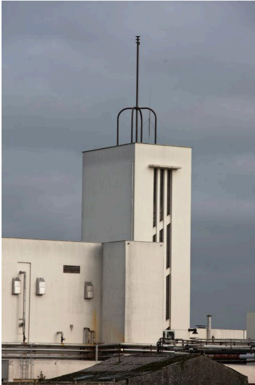
Détail de la tour d'escalier de l'atelier de fabrication (H), vers le nord-est.
