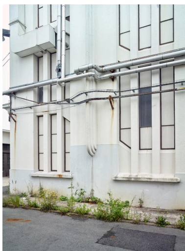
Base du pignon ouest de l'atelier de fabrication (G). Détail des baies éclairant l'escalier et moulures toriques décoratives. Phot. Pierre Thibaut IVR32_20225900662NUCA
