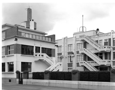
Les escaliers de distribution extérieurs des bureaux et de l'atelier de fabrication, vers le sud-est. Phot. Olivier Marlard IVR31_19945901380V
