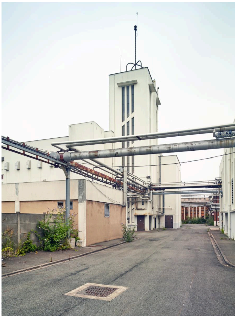
Atelier de fabrication (H) vers le nord. Au fond le hall d'accueil (V7).
