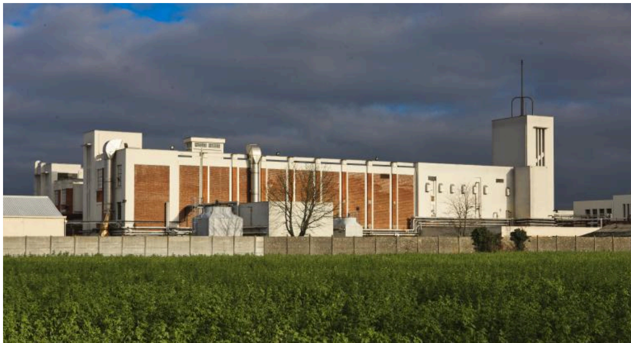
Ateliers de fabrication (H) vers le nord-est depuis le chemin de Molpas.
