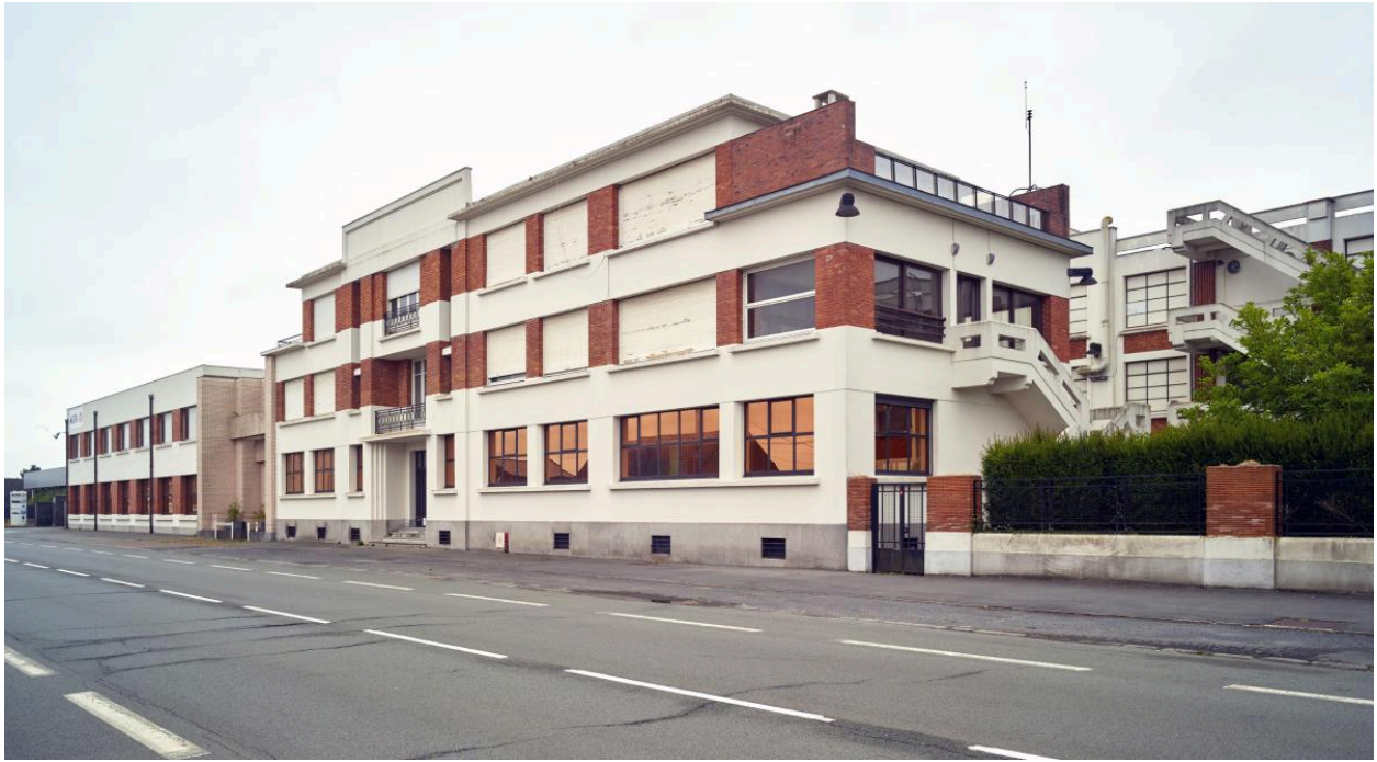
Vue générale vers le sud-est, depuis l'avenue du Général-de-Gaulle.
