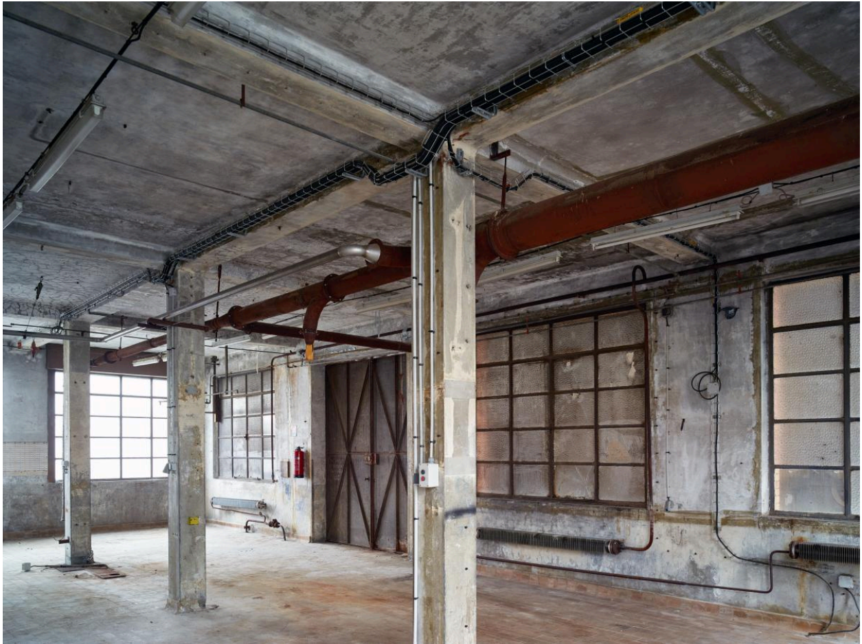
Vue intérieure de la menuiserie (I).
