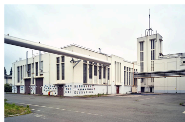
La chaufferie (A) à gauche et l'atelier de fabrication (H) vers l'ouest. Phot. Pierre Thibaut IVR32_20225900645NUCA
