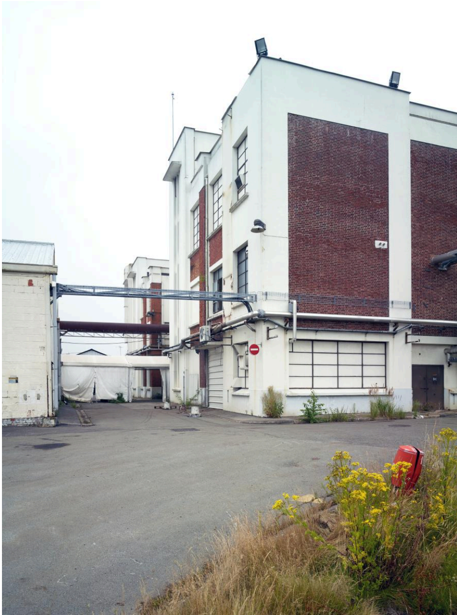
Pignons ouest des ateliers de fabrication (H et G), vers le nord-est.
