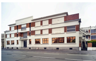
Bâtiment des bureaux et logements (E). Élévation sur rue, vers le sud-est. Phot. Pierre Thibaut IVR32_20225900675NUCA
