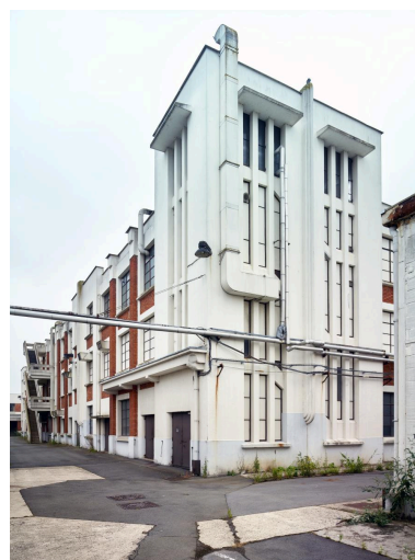
Vue de trois-quart vers le sud-est de l'atelier de fabrication (G). Au premier plan, la tour d'escalier demi-hors-oeuvre. Phot. Pierre Thibaut IVR32_20225900658NUCA
