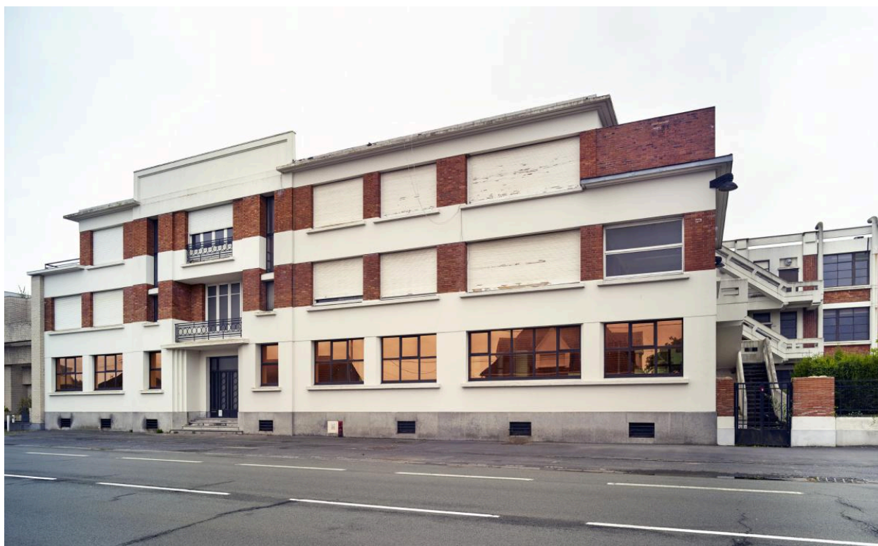
Bâtiment des bureaux et logements (E). Elévation sur rue, vers le sud-est.
