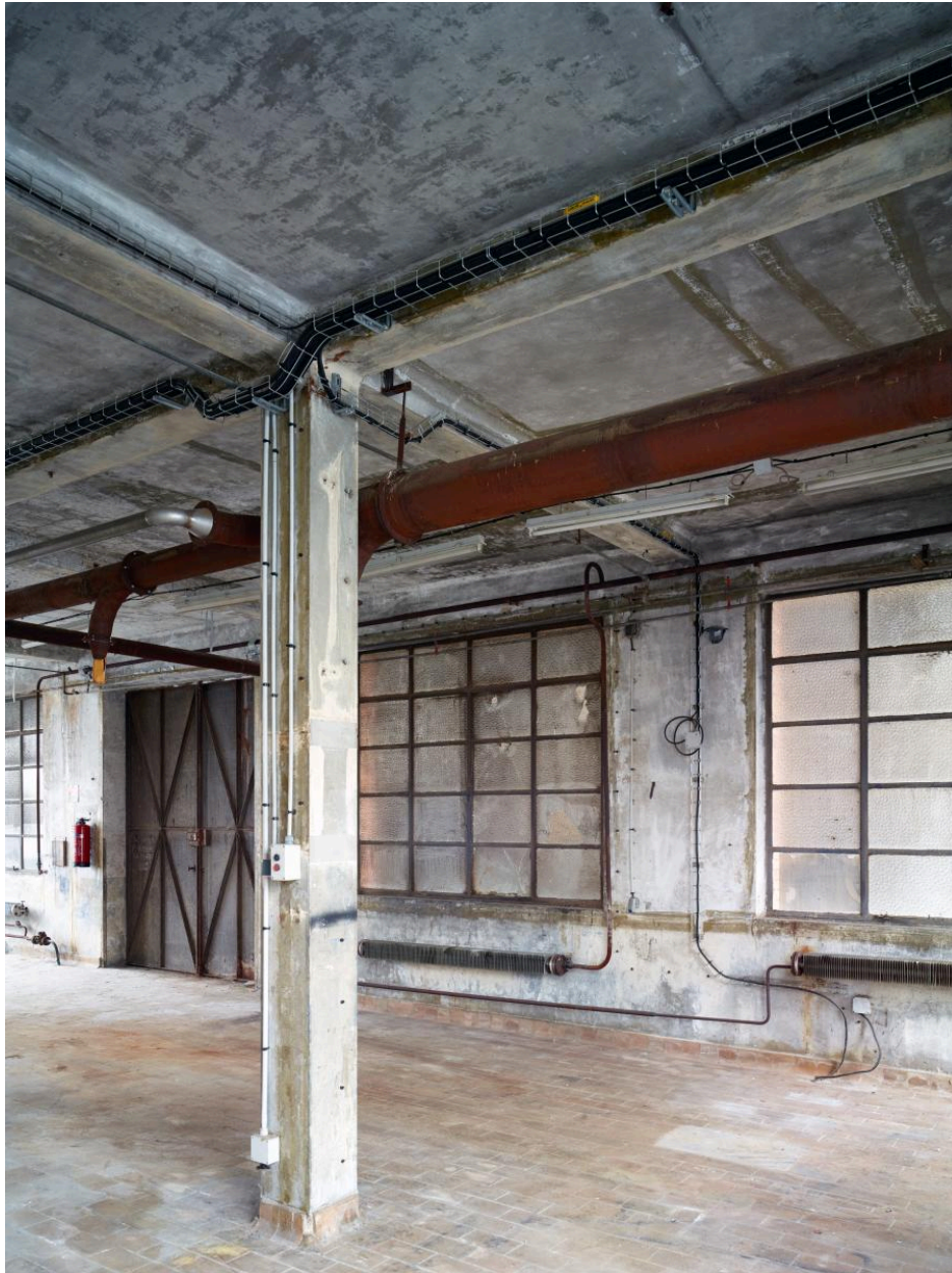
Vue intérieure de la menuiserie (I).
