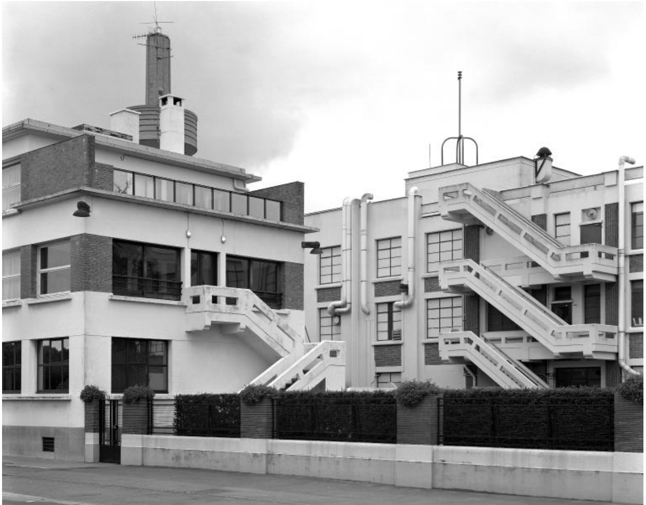
Les escaliers de distribution extérieurs des bureaux et de l'atelier de fabrication, vers le sud-est.
