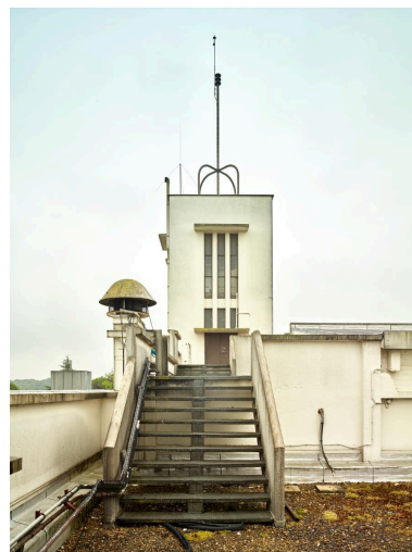
Tour surmontant l'atelier de fabrication (H) depuis le couvrement du bâtiment de conditionnement (AH), vers le sud. Phot. Pierre Thibaut IVR32_20225900670NUCA
