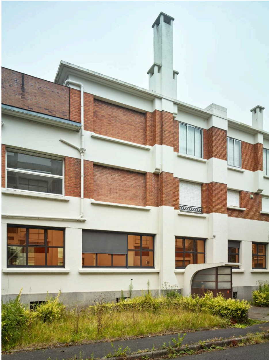
Bureaux et logements (E). Elévation postérieure. Descente de cave protégée d'une marquise.
