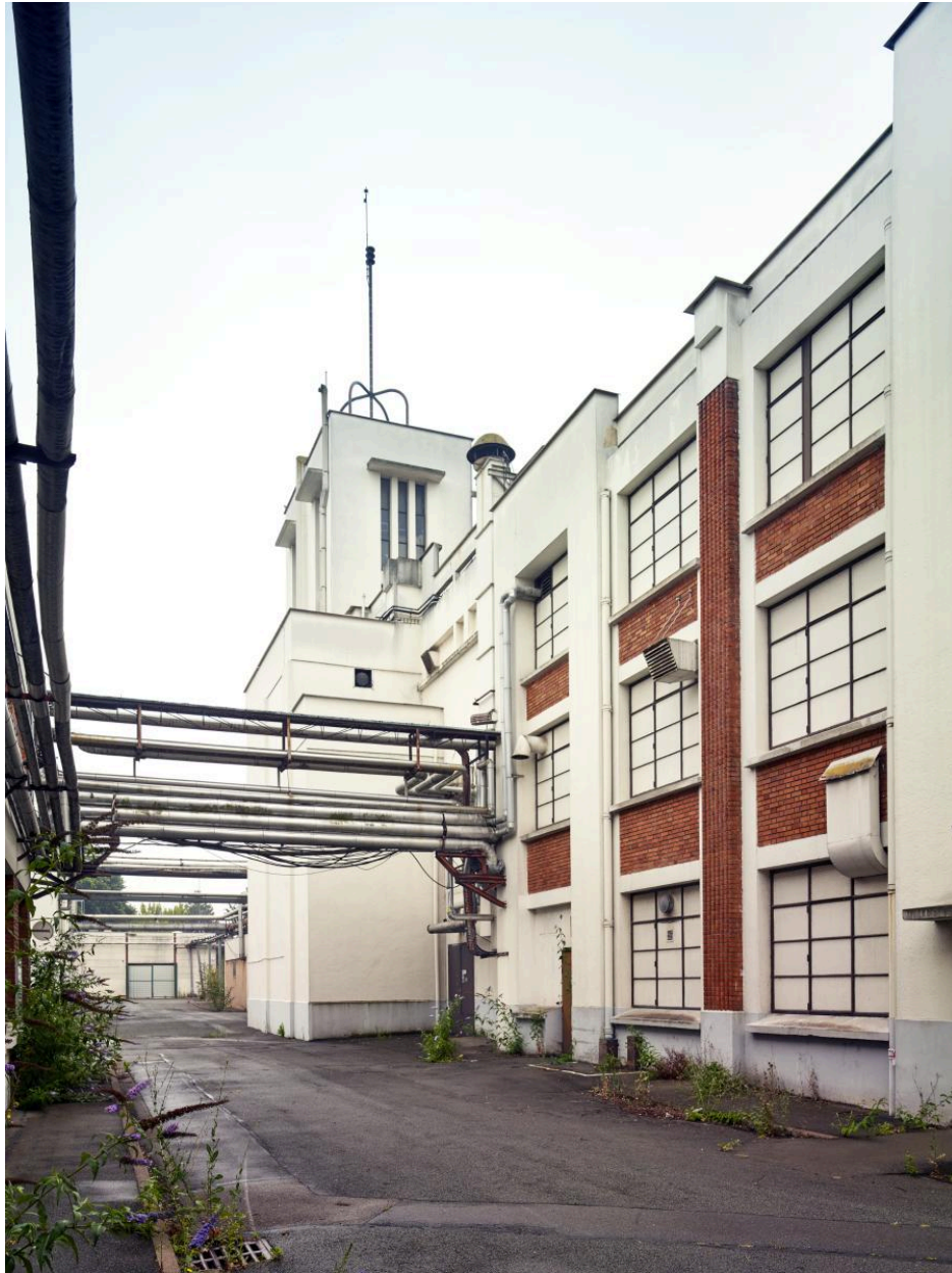
Elévation est des ateliers de fabrication (H et G) reliés par le bâtiment de conditionnement (AH).
