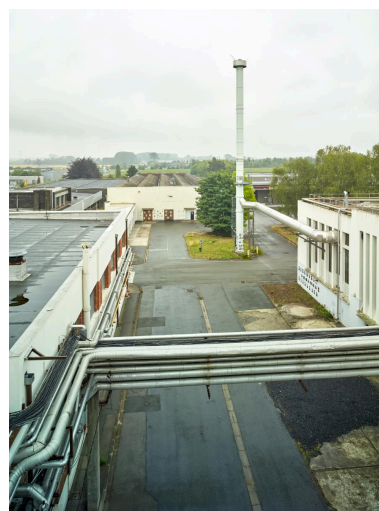
En arrière plan, le magasin aux produits chimiques (AD) depuis le couvrement de l'atelier de fabrication (H). Phot. Pierre Thibaut IVR32_20225900671NUCA
