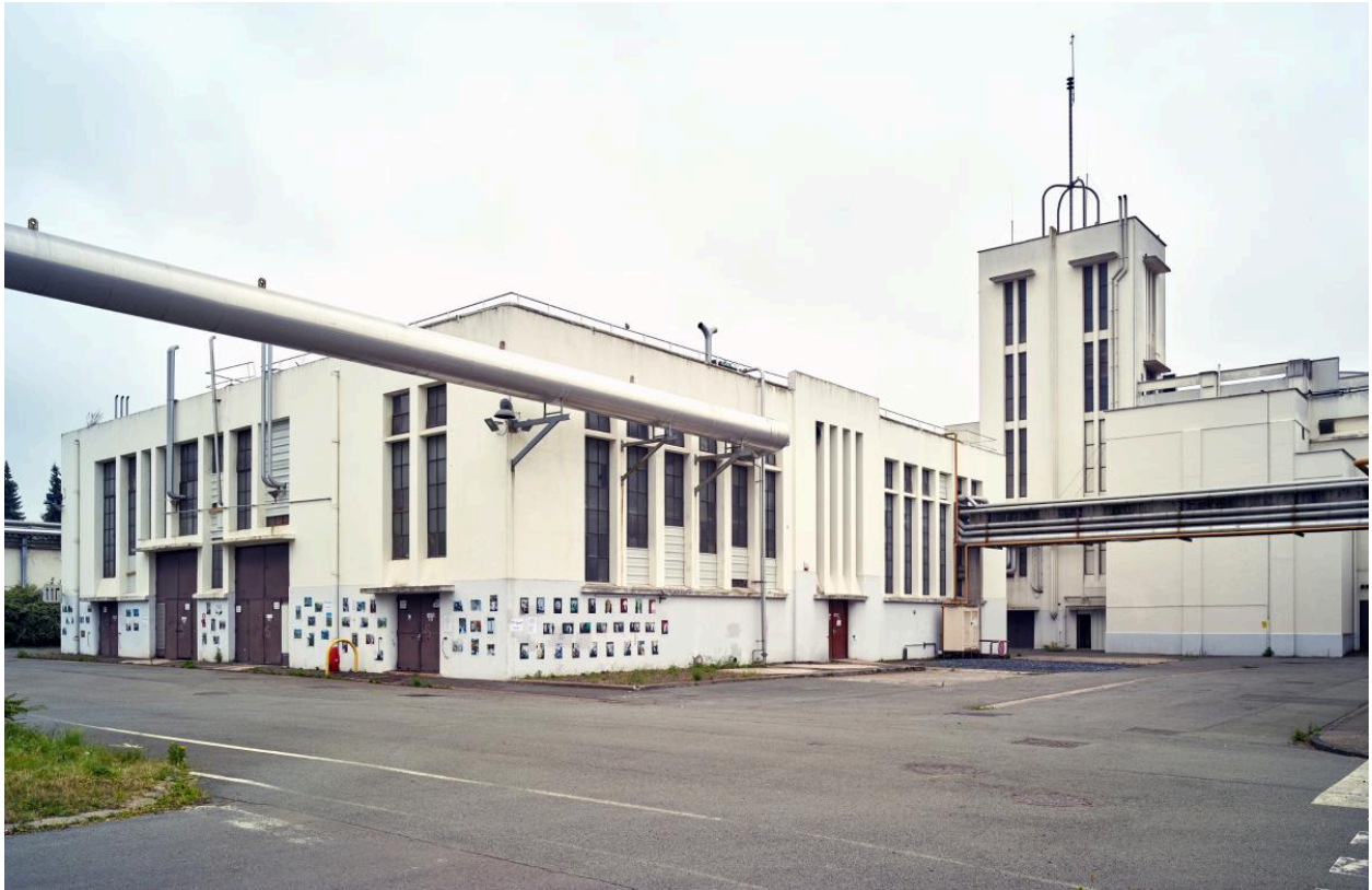
La chaufferie (A) à gauche et l'atelier de fabrication (H) vers l'ouest.
