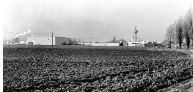
Vue générale vers l'ouest. Phot. Olivier Marlard IVR31_19945900503V
