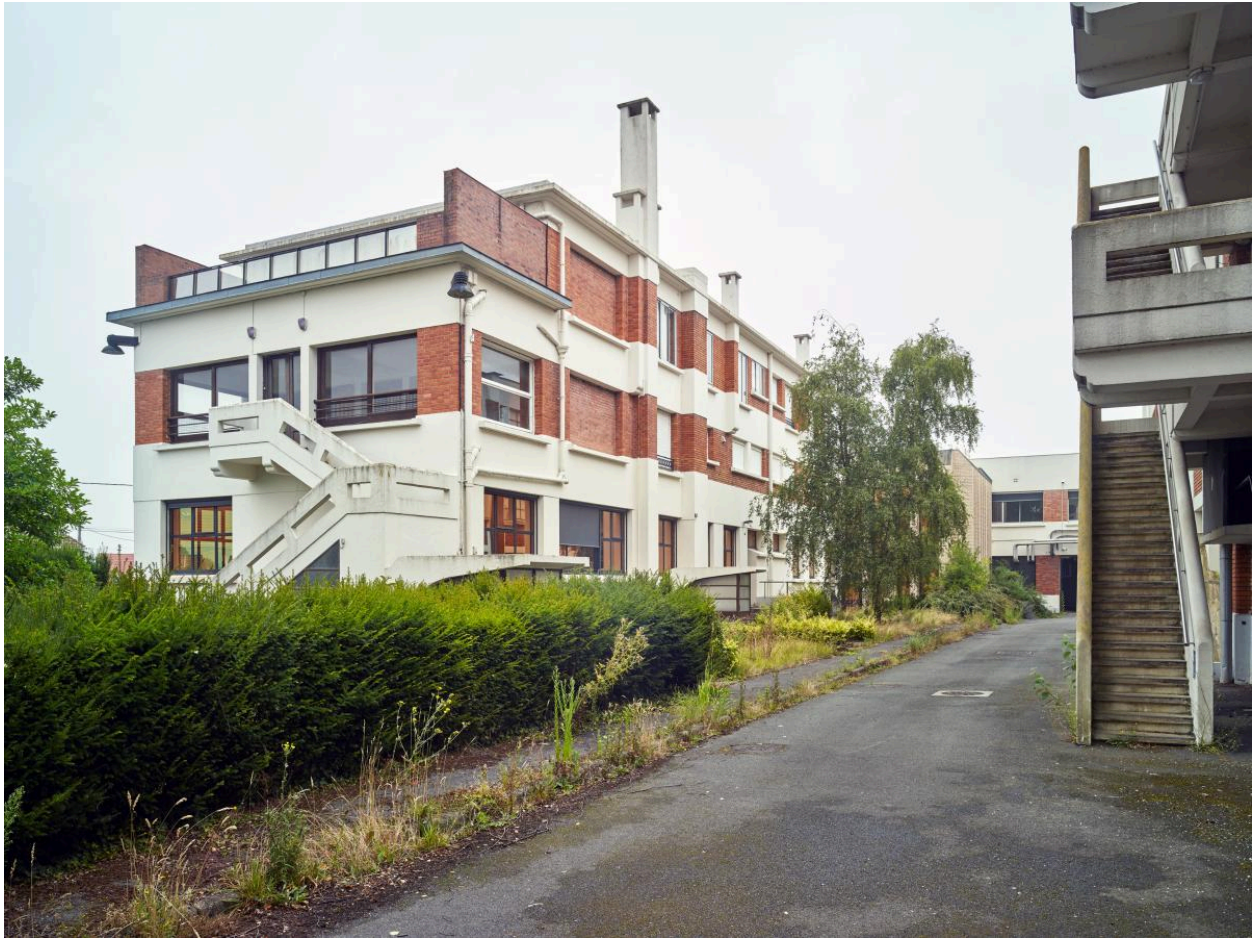
Bureaux et logements (E). Pignon et élévation postérieure. Vue de trois-quarts vers le nord-est.
