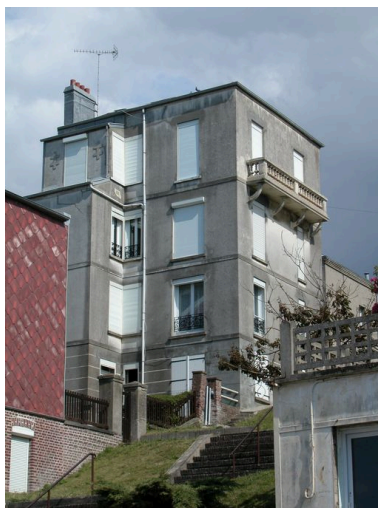
Vue depuis la rue de Saint-Valery, façade sur mer. Phot. Elisabeth Justome IVR22_20058003514NUCA
