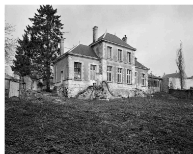
Vue générale de l'élévation arrière. Phot. Thierry Lefébure IVR22_19900200564V
