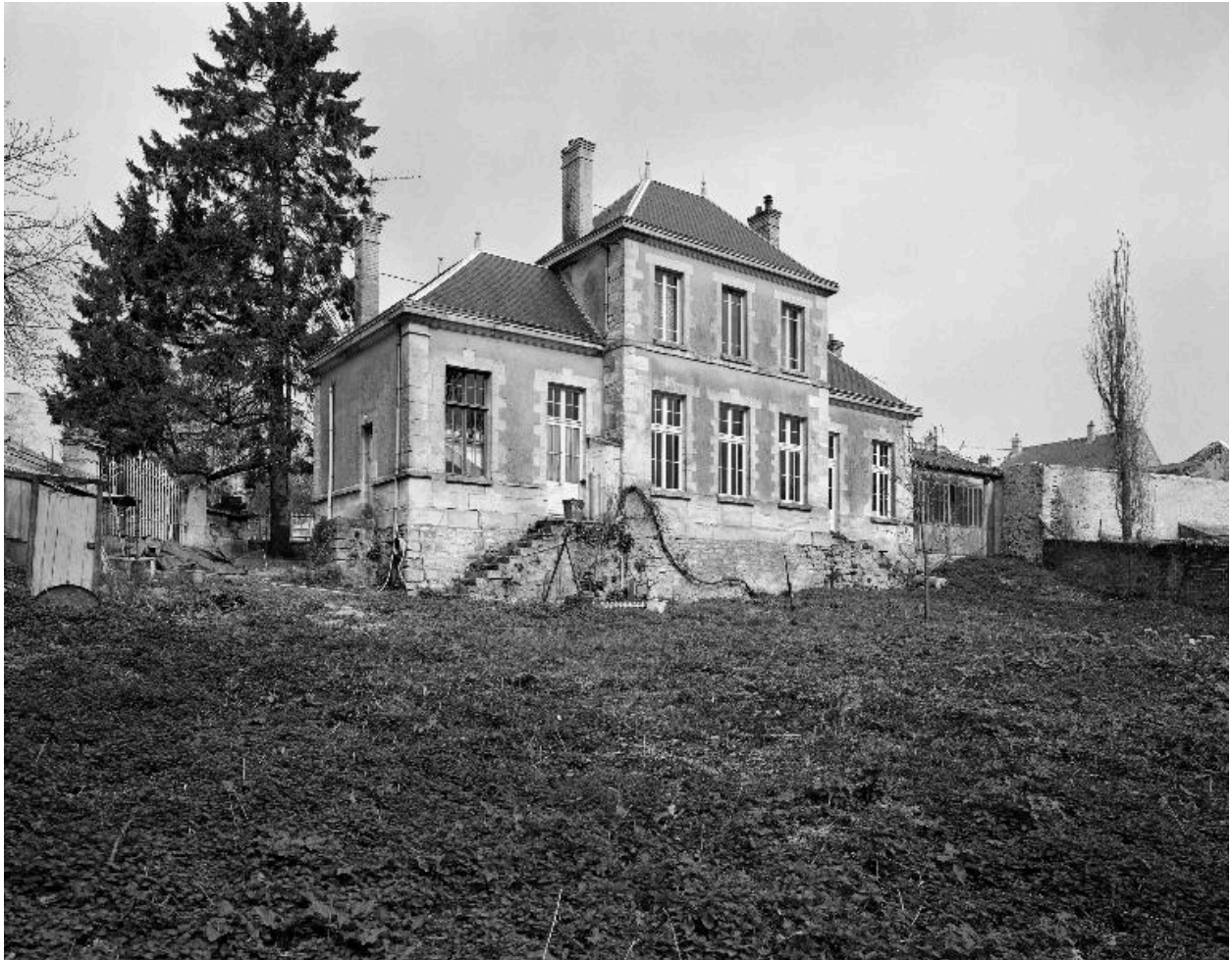
Vue générale de l'élévation arrière.
