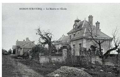
Carte postale montrant une vue d'ensemble ouest de la mairie-école, dans le courant des années 1920 (coll. part.). Phot. Charrondière Fabrice IVR22_19860200521XB
