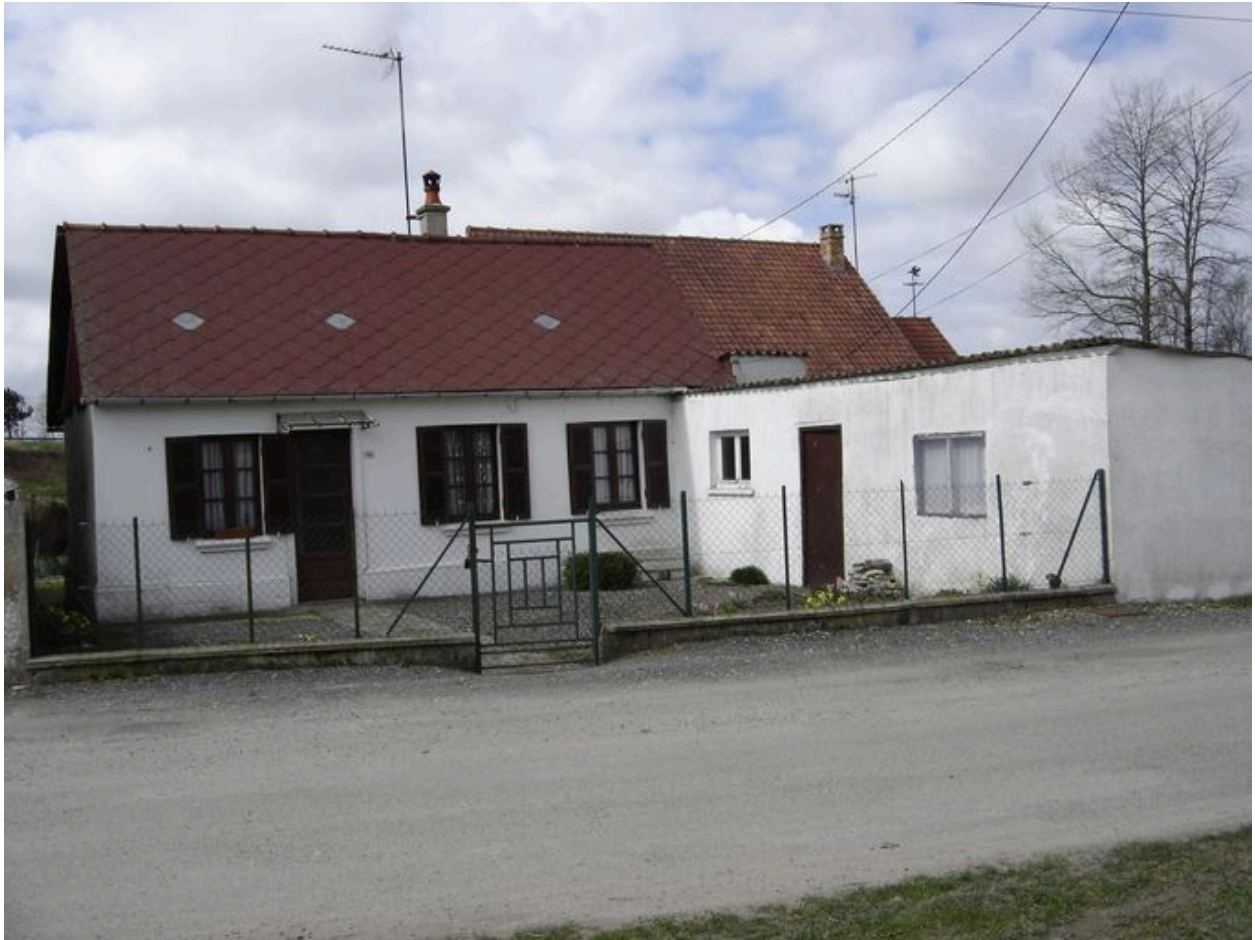
Vue générale du 18 Chemin de Valois.
