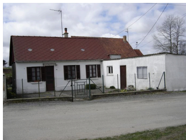
Vue générale du 18 Chemin de Valois. Phot. Inès Guérin IVR22_20058005304NUCA
