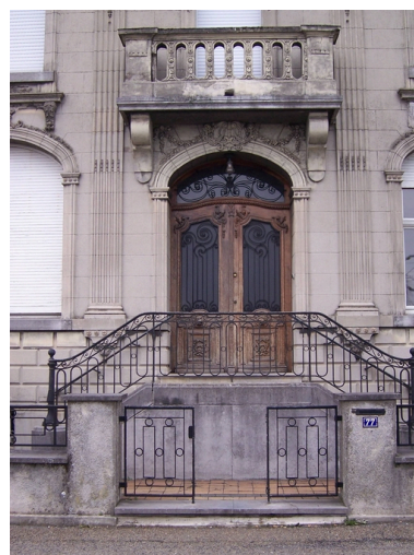
Vue générale de l'entrée et du perron. Phot. Cyril Cailleau IVR31_20055907301NUCA
