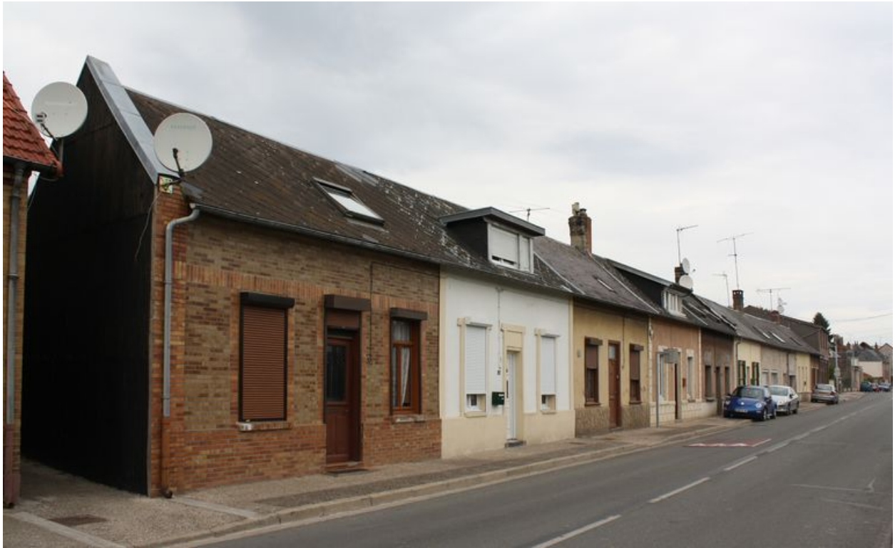
Vue d'ensemble sur rue.
