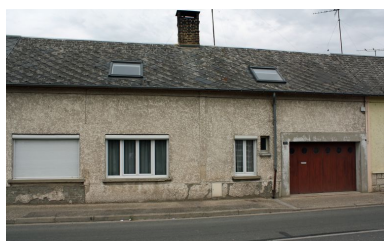
Logement au 72 rue du Général- Leclerc, façade sur rue. Phot. Bertrand Fournier IVR22_20098005140NUCA
