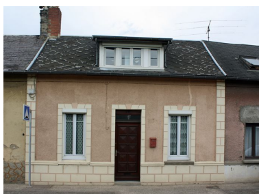
Logement au 78 rue du Général- Leclerc, façade sur rue. Phot. Bertrand Fournier IVR22_20098005141NUCA
