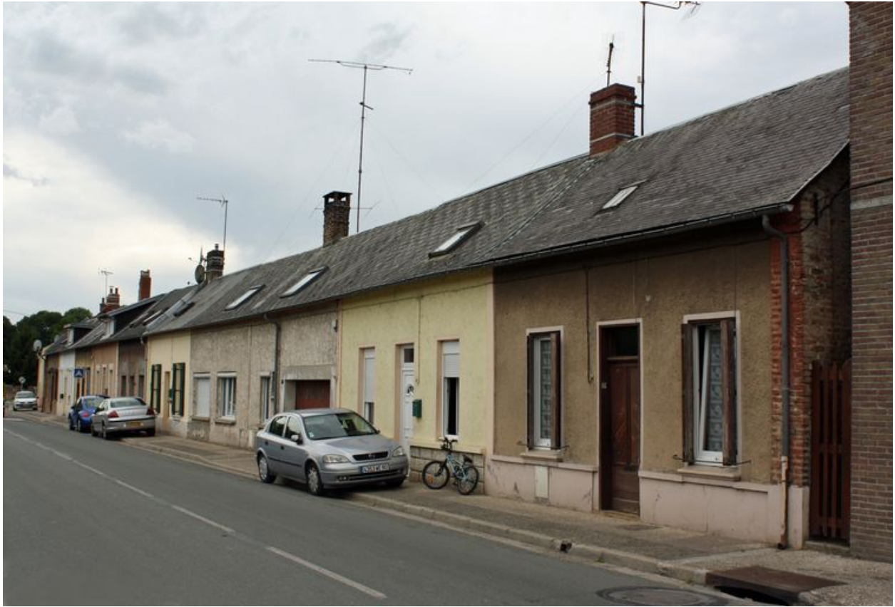
Vue d'ensemble sur rue.
