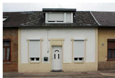
Logement au 82 rue du Général- Leclerc, façade sur rue. Phot. Bertrand Fournier IVR22_20098005142NUCA
