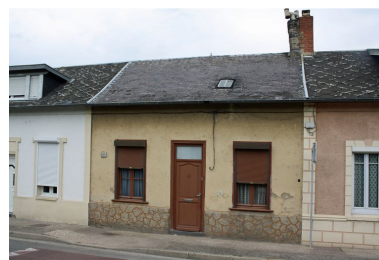
Logement au 80 rue du Général- Leclerc, façade sur rue. Phot. Bertrand Fournier IVR22_20098005139NUCA
